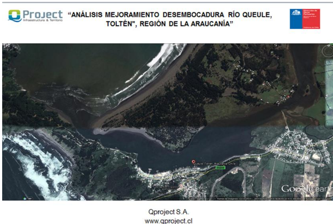
Figura N°106 Desembocadura Río Queule, Toltén
