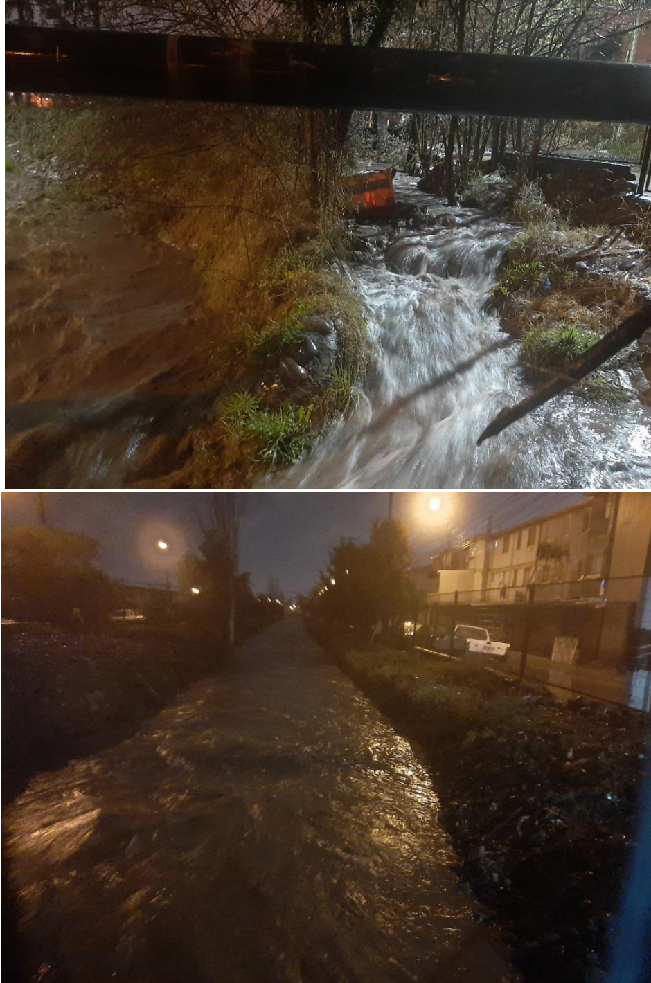
FOTOGRAFÍA 4-62: AGUAS ARRIBA Y ABAJO RESPECTIVAMENTE DEL PUENTE DEL FERROCARRIL
