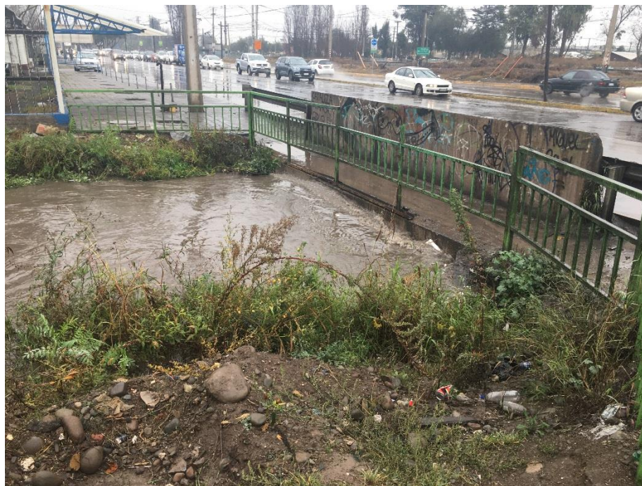
FOTOGRAFÍA 4-20: CRUCE CANAL SANTA MARTA CON CAMINO A MELIPILLA. AGUAS ARRIBA. HORA 16:11
