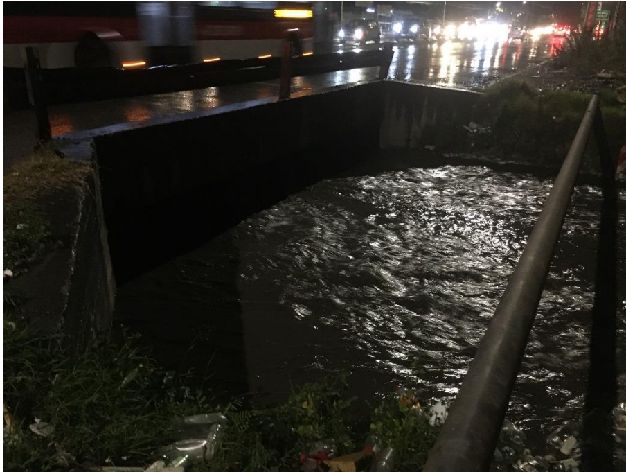
FOTOGRAFÍA 4-9: INTERSECCIÓN CANAL SANTA MARTA CON CAMINO A MELIPILLA. VISTA AGUAS ABAJO ALCANTARILLA DESDE RIBERA DERECHA HACIA CAMINO A MELIPILLA (21:06 HRS)
