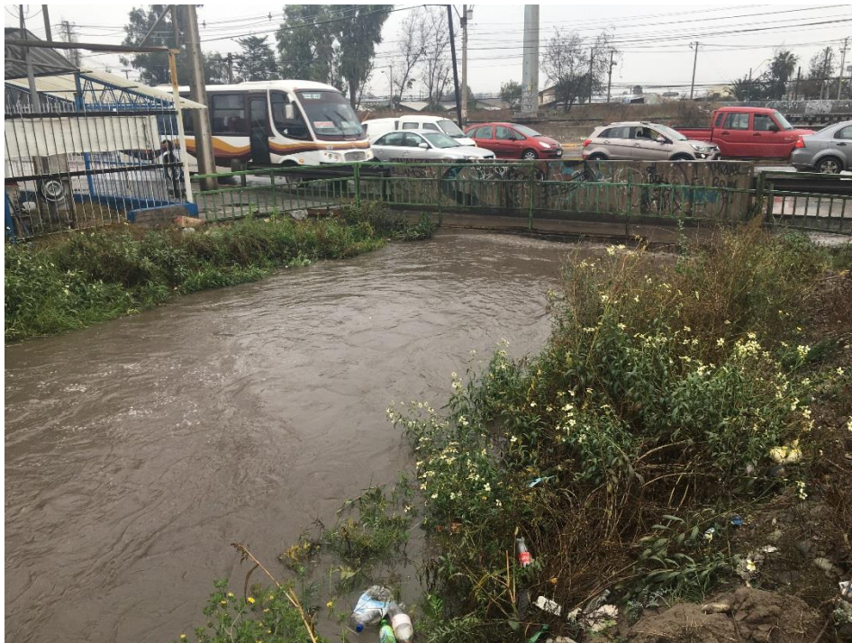
FOTOGRAFÍA 4-19: CRUCE CANAL SANTA MARTA CON CAMINO A MELIPILLA. AGUAS ARRIBA. HORA 16:10
