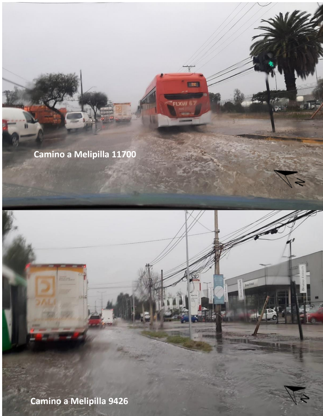
FOTOGRAFÍA 4-22: ANEGAMIENTO CAMINO A MELIPILLA
