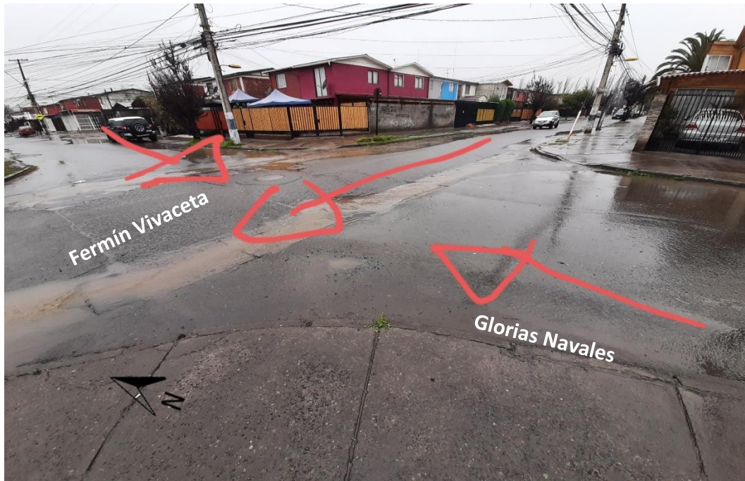
FOTOGRAFÍA 4-9: FLUJO APORTANTE AL COLECTOR MORRO DE ARICA INTERSECCIÓN CALLES FERMÍN VIVACETA CON GLORIAS NAVALES; HORA; 11:10
