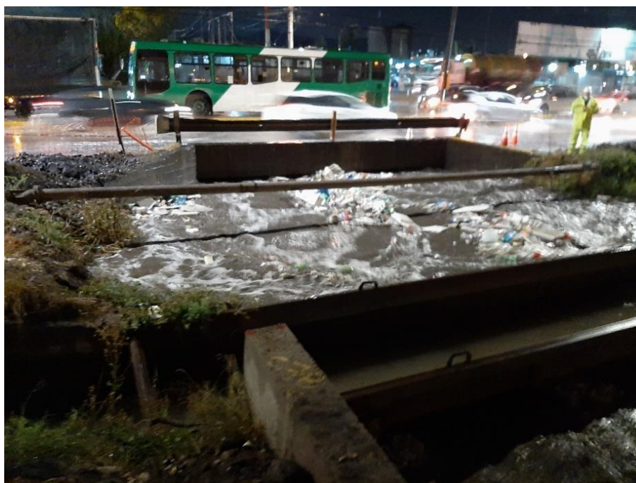
FOTOGRAFÍA 4-26: BOCA DE SALIDA DEL PUENTE CAMINO A MELIPILLA, HORA 20:18
