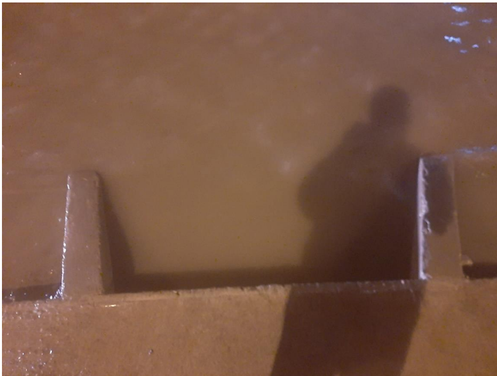
FOTOGRAFÍA 4-53: SUMIDERO VALLE DE LOS REYES CON FARO DE ALEJANDRÍA
