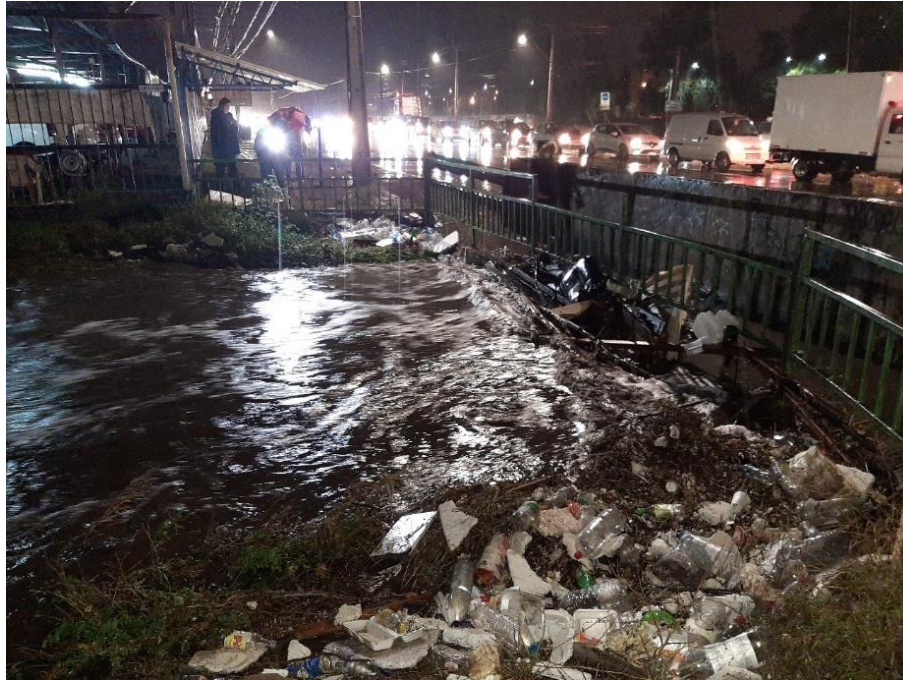
FOTOGRAFÍA 4-27: BOCA DE ENTRADA DEL PUENTE CAMINO A MELIPILLA, HORA 21:17
