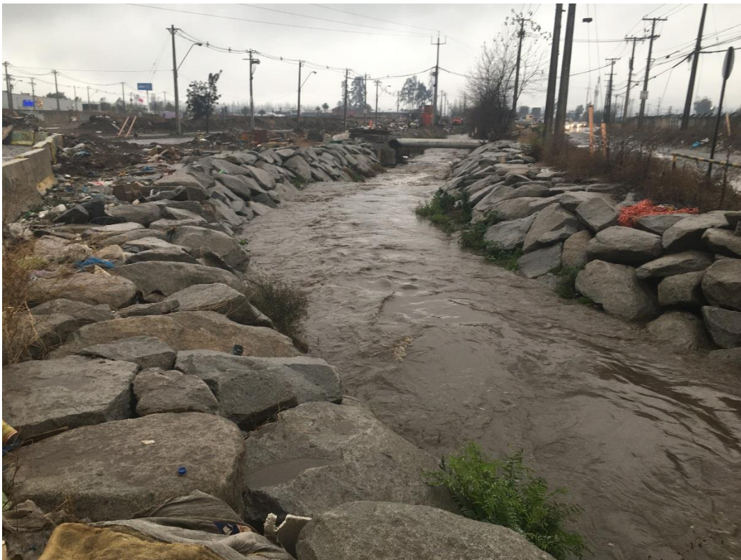
FOTOGRAFÍA 0-5: INTERSECCIÓN AVDA LAS INDUSTRIAS CON TRES PONIENTE. VISTA AGUAS ABAJO. HORA 17:07
