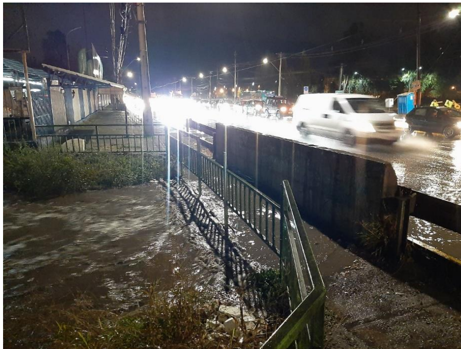
FOTOGRAFÍA 4-25: BOCA DE ENTRADA DEL PUENTE CAMINO A MELIPILLA, HORA 20:12
