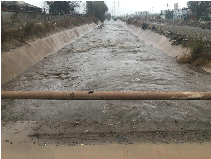
FOTOGRAFÍA 0-2: VISTA AGUAS ABAJO DESDE ALCANTARILLA INTERSECCIÓN AVDA LAS INDUSTRIAS CON EL MILAGRO: HORA 16:50
