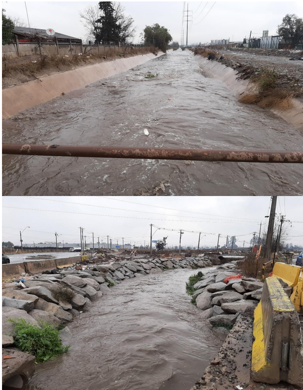
ANEXO 5.1: CANAL SANTA MARTA AL ORIENTE CAMINO MELIPILLA. HORA 12:13
