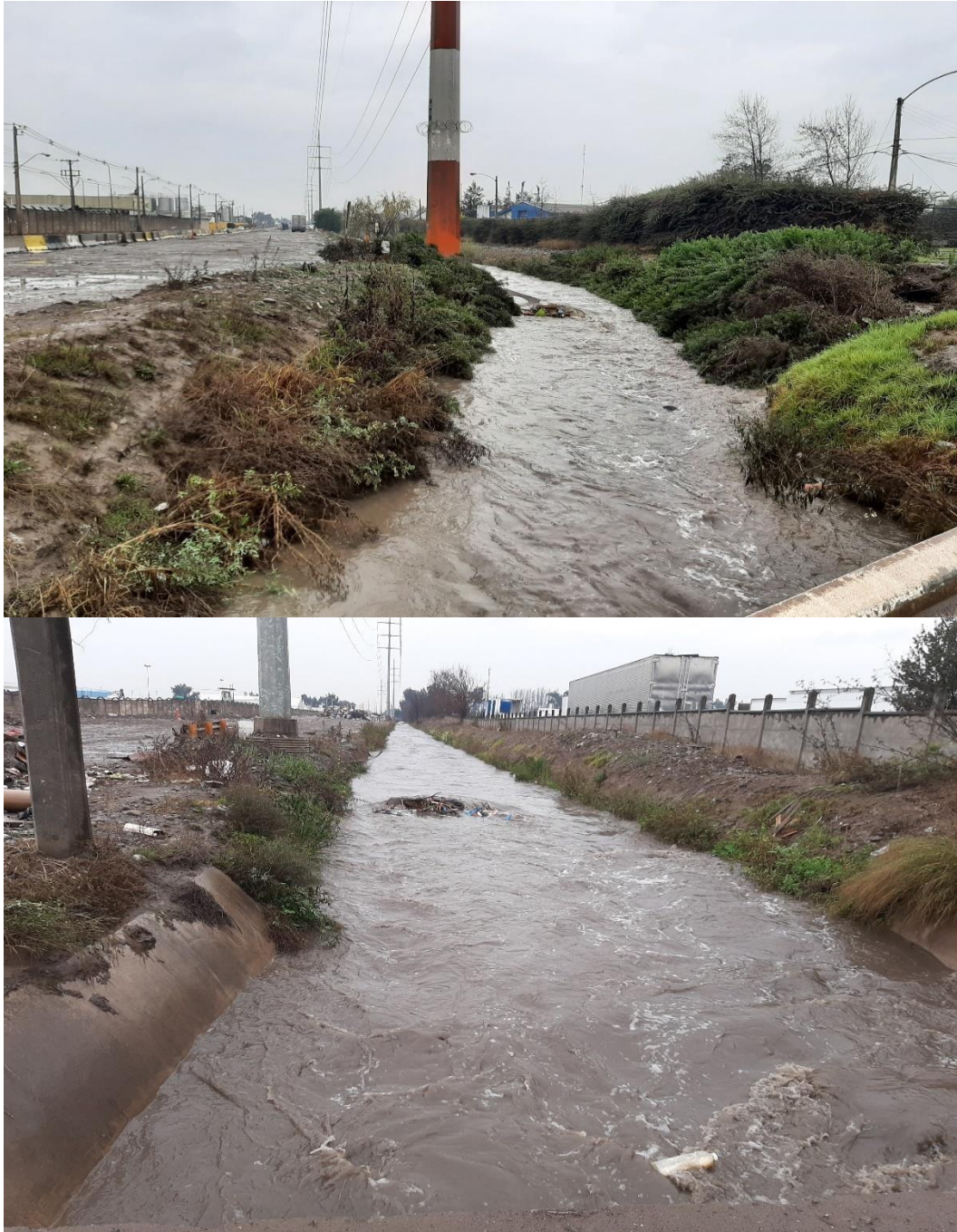
ANEXO 5.2: CANAL SANTA MARTA AL ORIENTE CAMINO MELIPILLA. Hora 12:15
