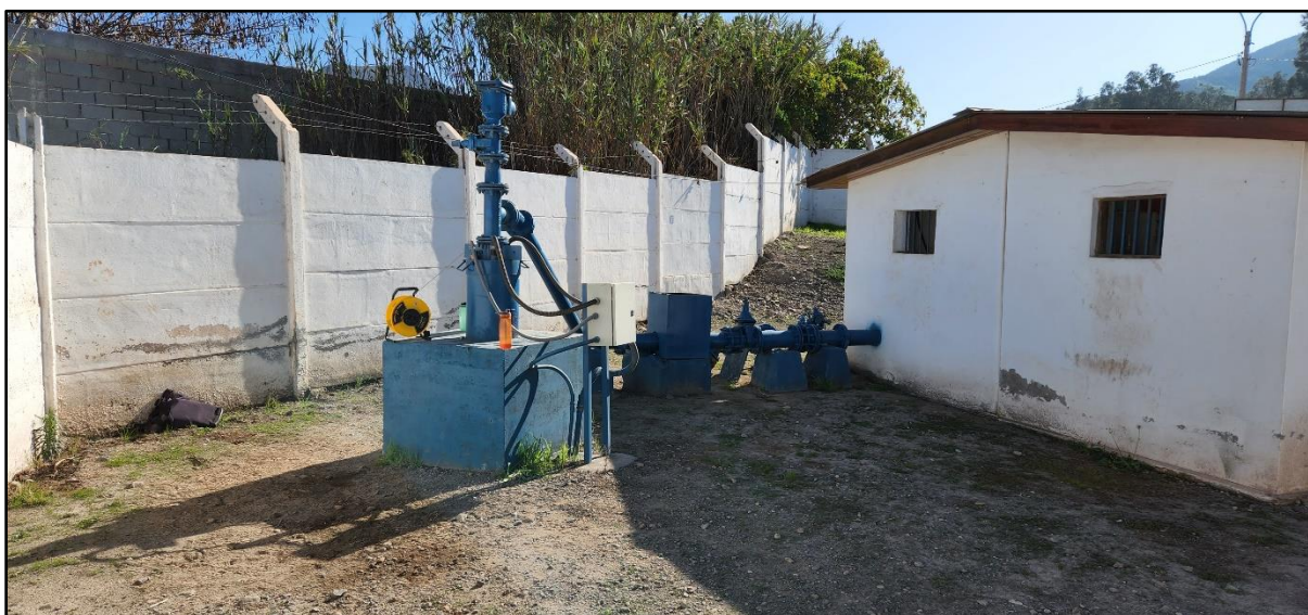
Figura 3.3. Registro de los descensos durante el bombeo. Fuente: Elaboración Propia.
