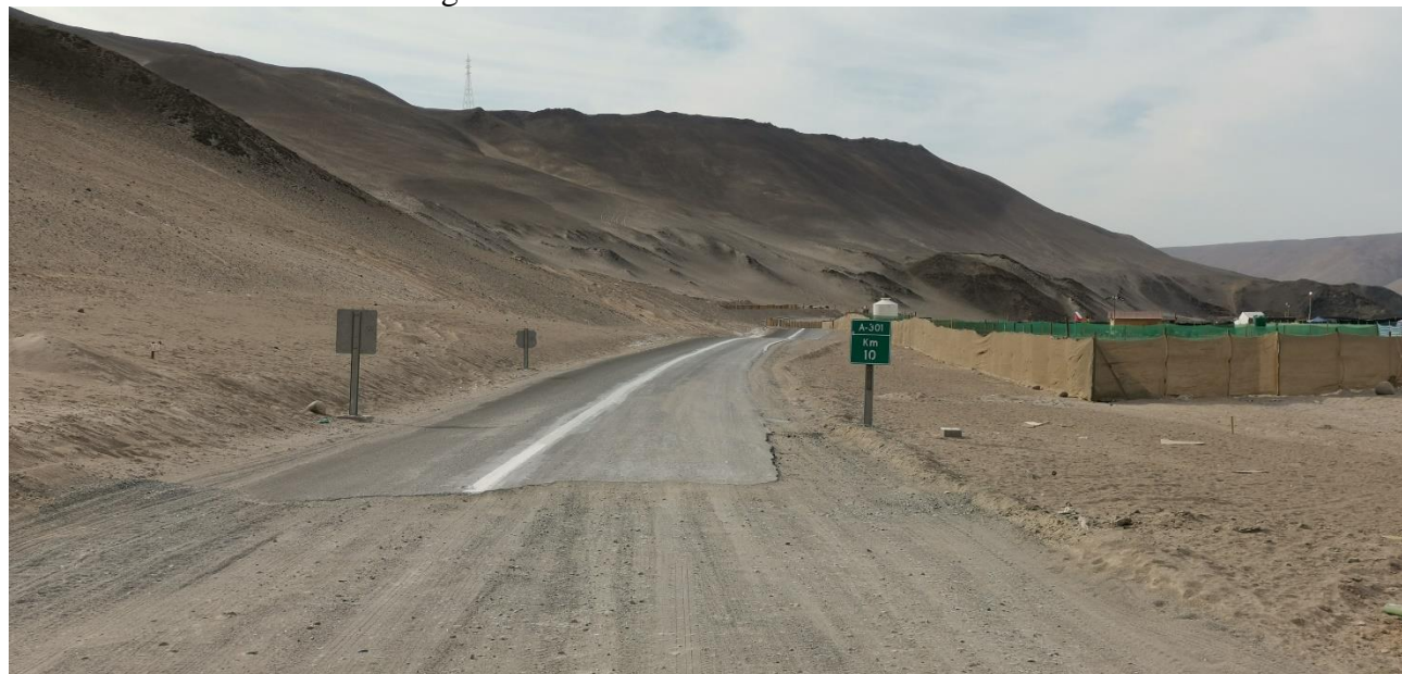
Figura 13-11. Infraestructura vial existente
