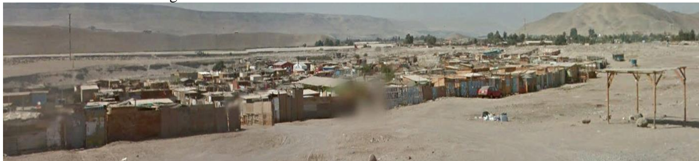
Figura 13-38. Vista SE desde Ciudad de Arica a ZR1
