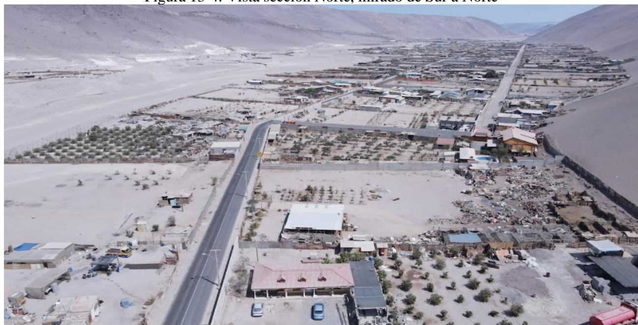
Figura 13-4. Vista sección Norte, mirado de Sur a Norte
