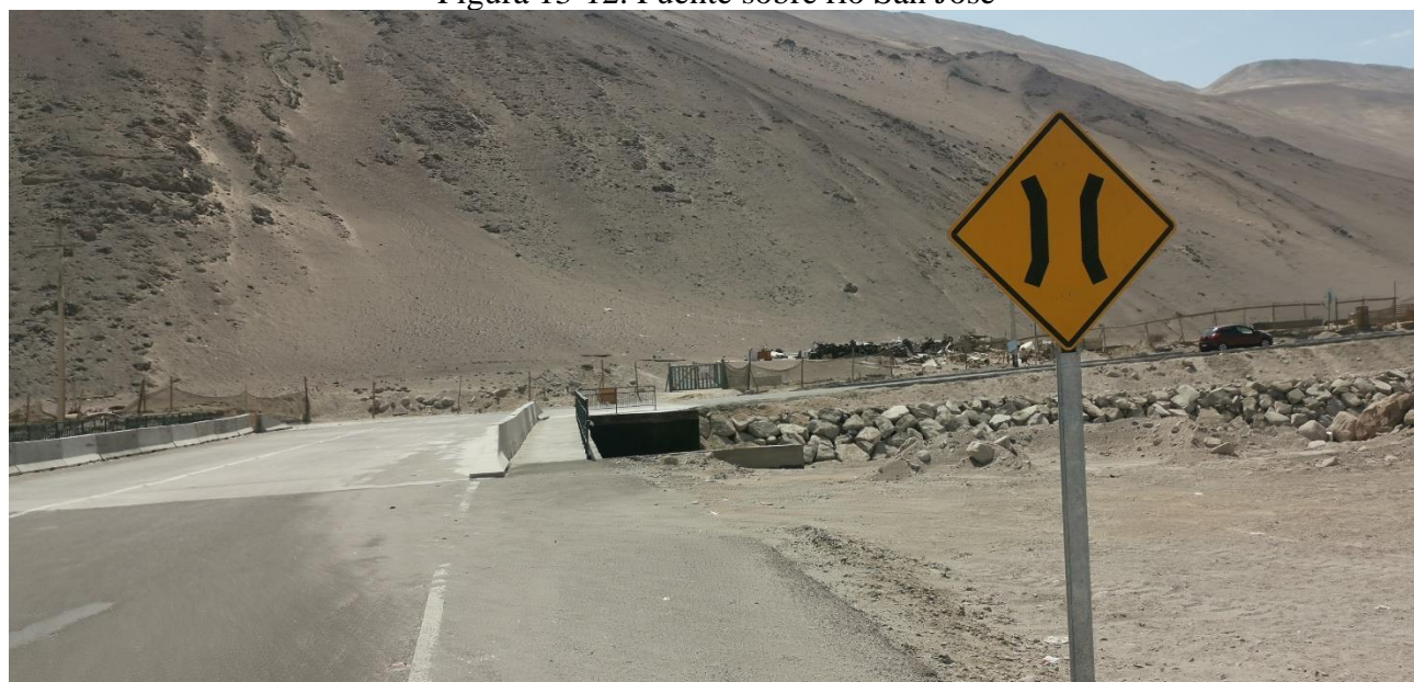
Figura 13-12. Puente sobre río San José
