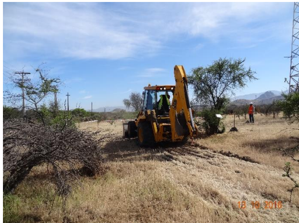
Foto N° 9 Ubicación Calicata CA-3
