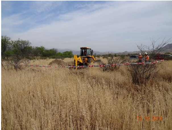
Foto N° 5 Ubicación Calicata CA-2
