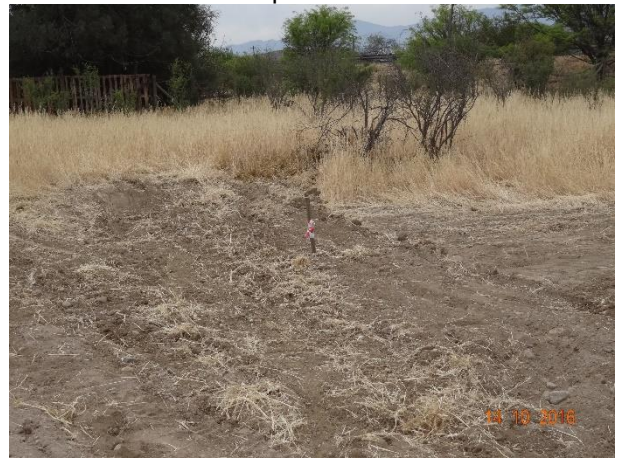
Foto N° 8 Tapado Calicata CA-2
