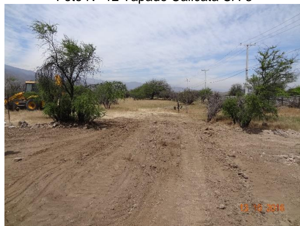
Foto N° 12 Tapado Calicata CA-3
