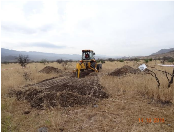
Foto N° 1 Ubicación Calicata CA-1
