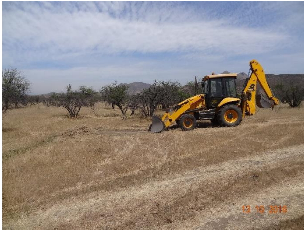
Foto N° 13 Ubicación Calicata CA-4
