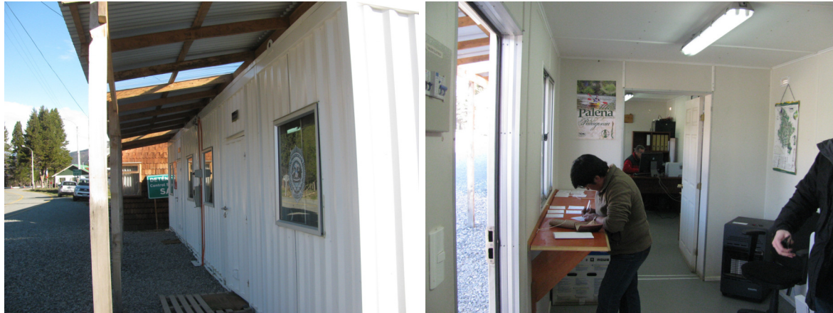
FIGURA N° 5.5-2: FOTOS SECTOR CONTROL PDI Y ADUANA RIO ENCUESTRO
