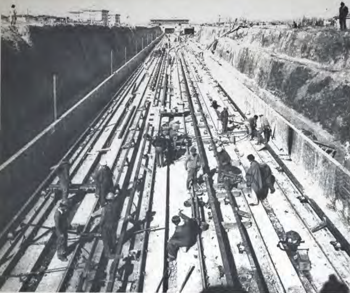
54. COLOCACION DE VIAS, 1974.
