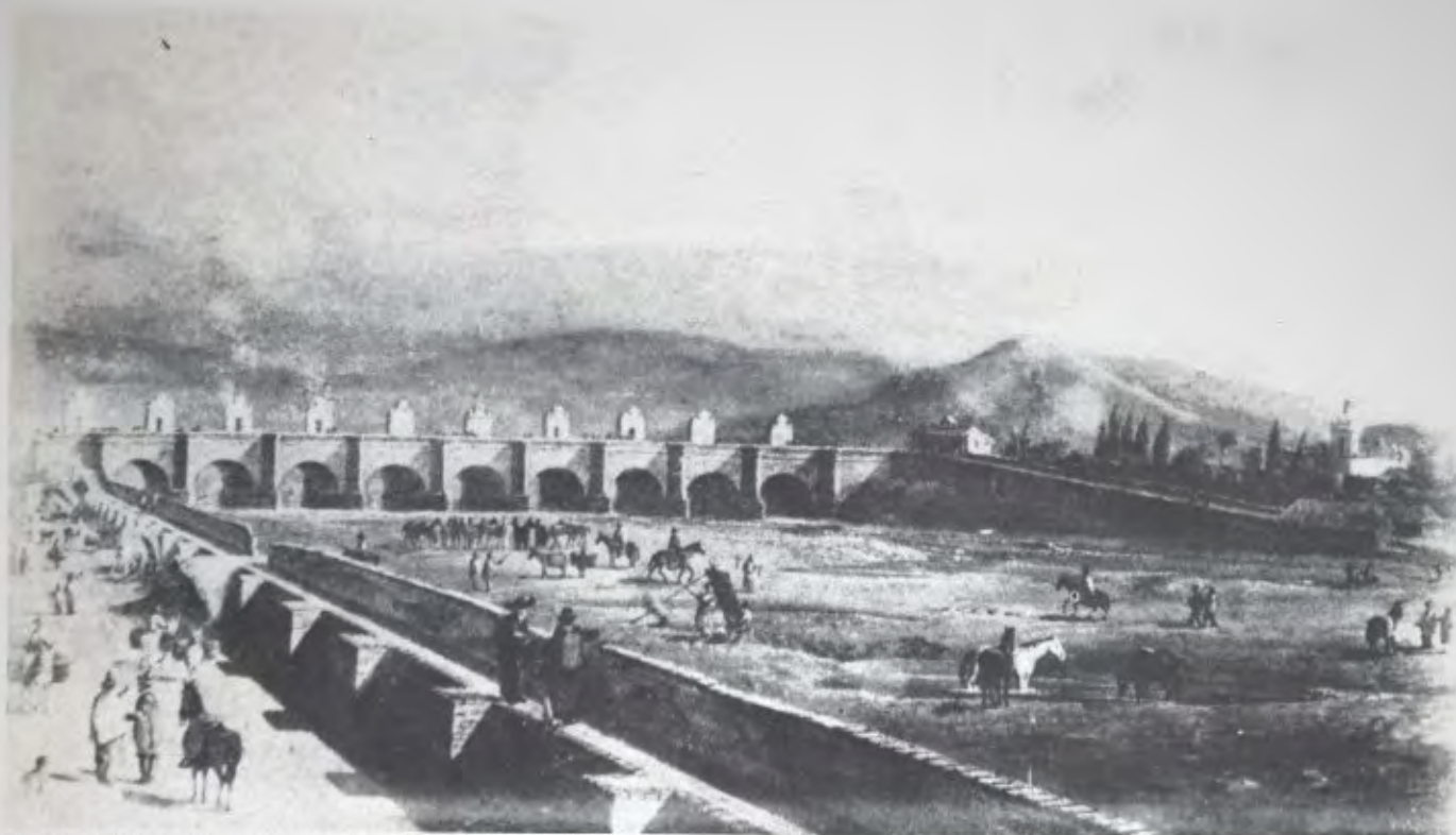
3. PUENTE DE CAL Y CANTO Y TAJAMAR, 1820.
