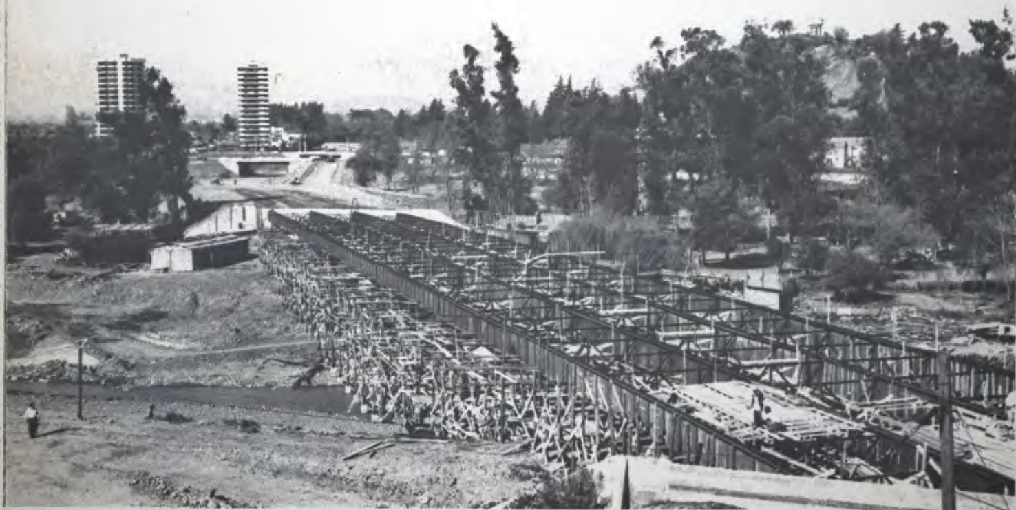
45a. CONSTRUCCION PUENTE LO SALDES, 1969.
