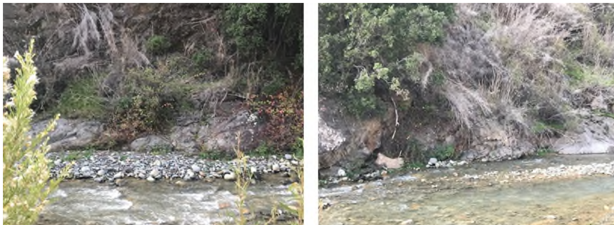
Figura N° 3-4: Zona plinto (estimado) estribo derecho Sitio 3
