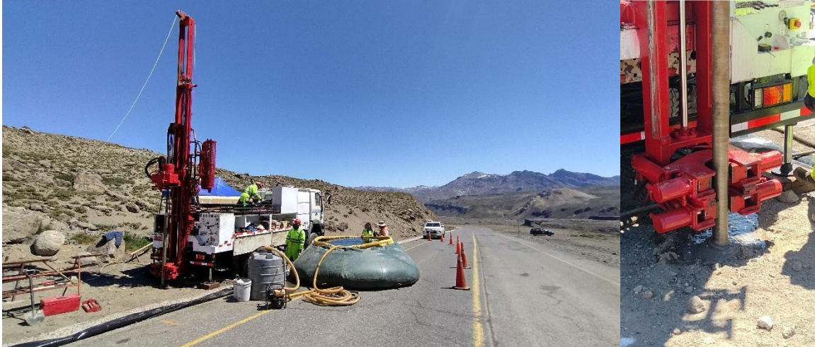
Figura 10 Fotografía de sonda Tecoinsa TP50 acoplada a camión 4x4 MAN realizando pozos en la ruta 115CH.
