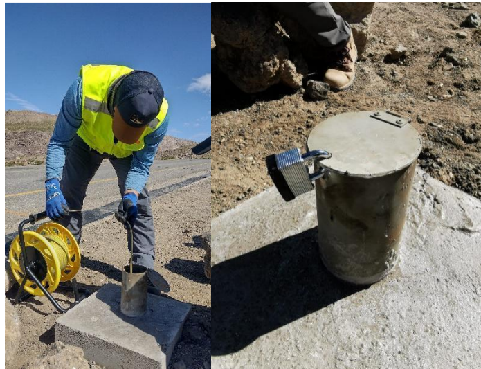
Figura 11 Piezómetro. A la izquierda se muestra el pozómetro utilizado en este estudio y registro de la toma de datos. A la derecha, se muestra el tapón, la funda metálica cerrada por candado y el collar de hormigón.
