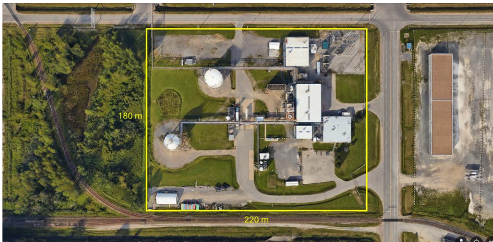
Figura 6-21: Dimensiones de la planta PEM de producción de hidrógeno, Air Liquide, Becancour, Québec, Canadá. Superficie de planta aproximada: 4 ha. Capacidad de producción: 20 MW, 8,2 toneladas diarias de hidrógeno.
