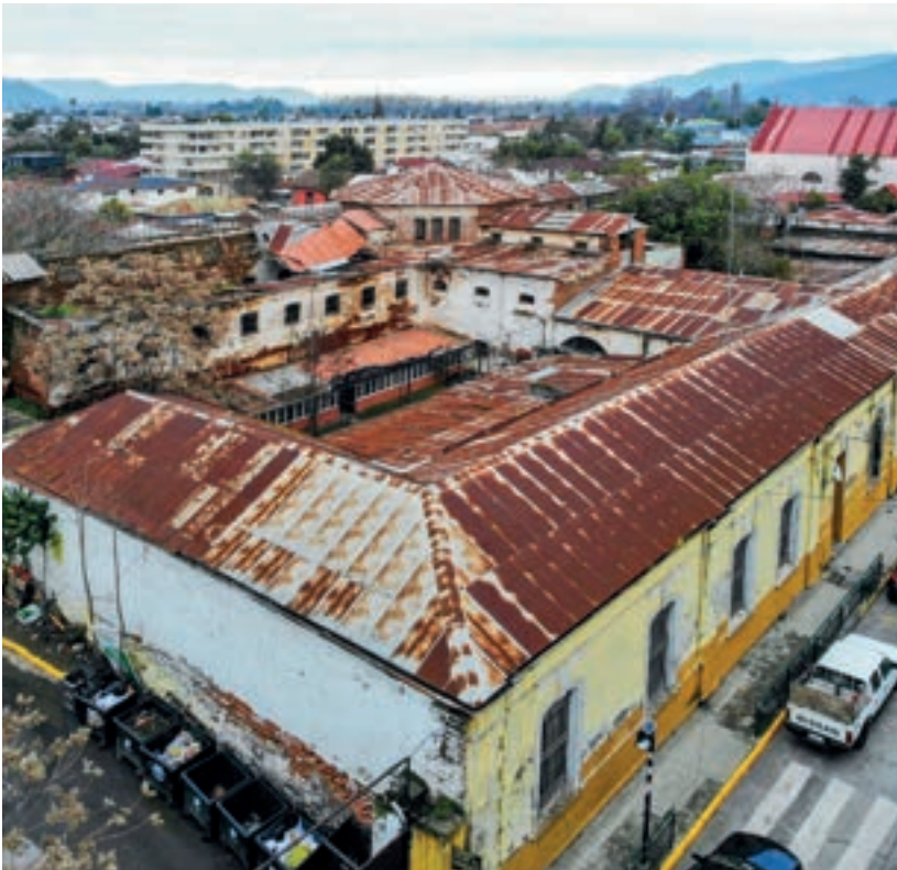
Vista aérea de la ex cárcel pública de San Fernando y su contexto.
