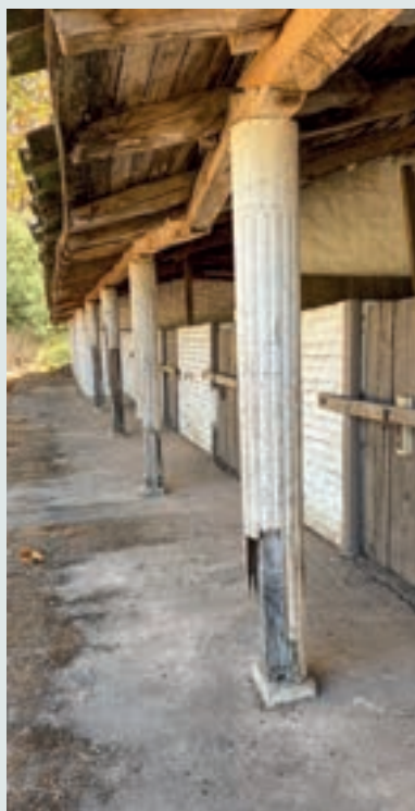
Vista del corredor exterior.
