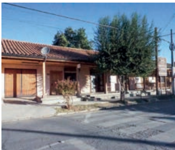
Vista de vivienda en avenida Óscar Gajardo.
