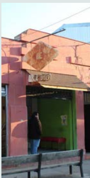
Detalle del ingreso del inmueble.
