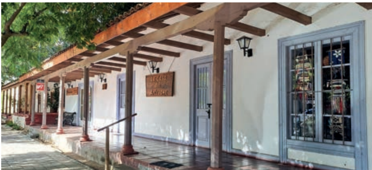
Vista de fachadas continuas del conjunto.
