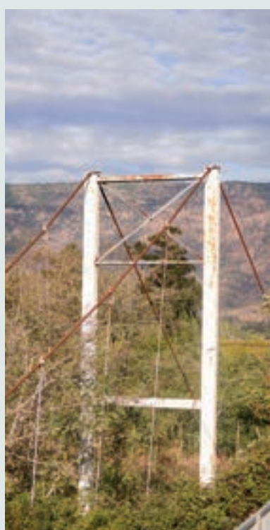
Detalle de pilares metálicos.
