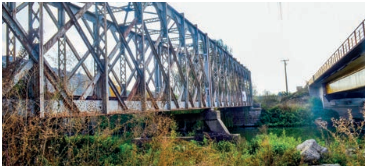
Vista del puente desde el nivel de suelo.
