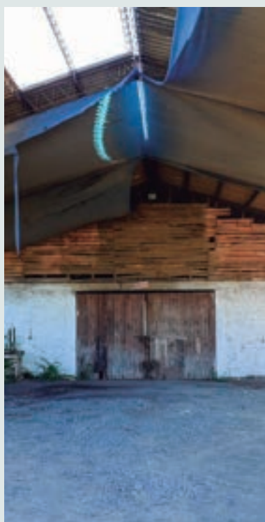
Detalle de portón de acceso.
