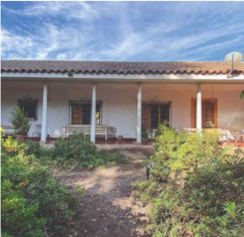
Vista de fachada principal de la casa patronal del fundo.
