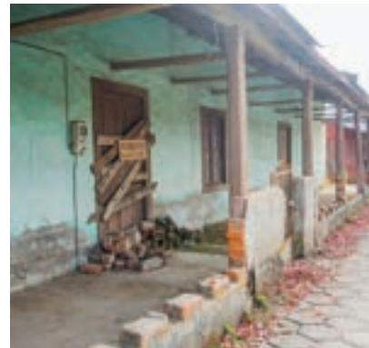
Vista de corredor exterior.
