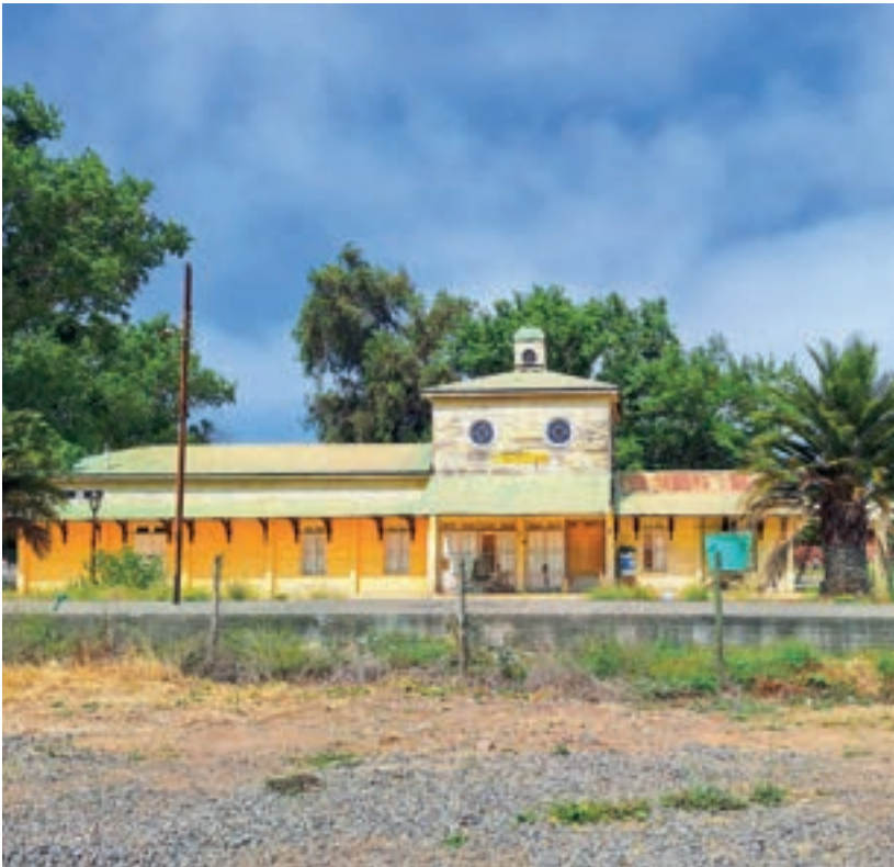
Vista de la fachada posterior de la estación.
