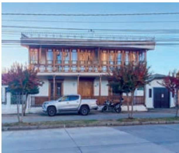
Vista de fachada de casa de dos pisos con corredor.
