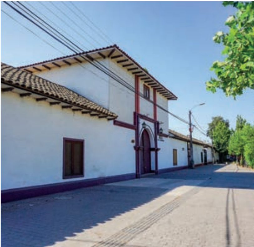
Vista de la fachada principal de la antigua casa patronal.
