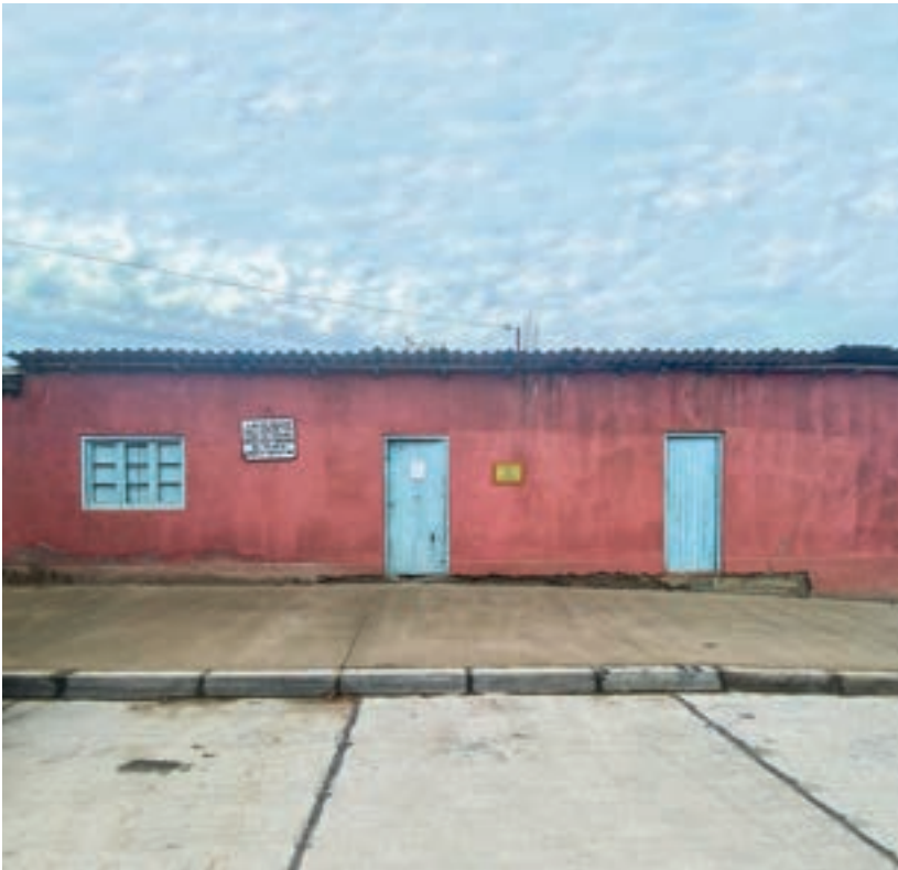
Vista de la fachada suroriental de la casa, desde calle Serrano.
