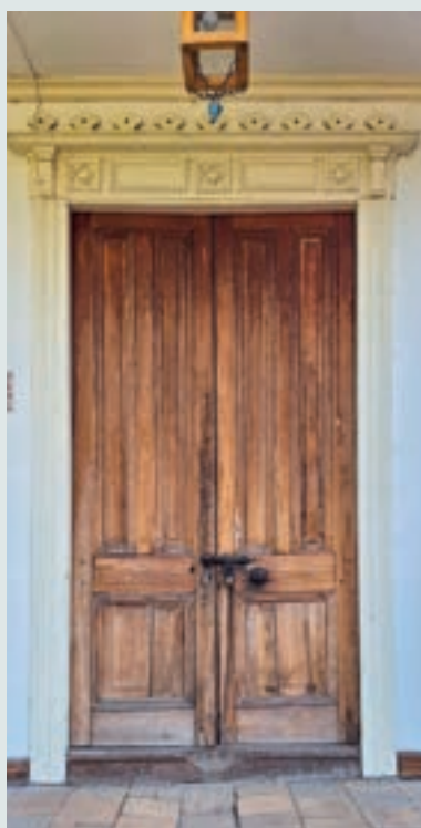
Detalle de carpinterías del acceso.
