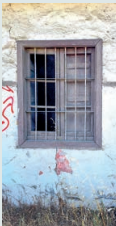
Detalle de vano de inmueble.
