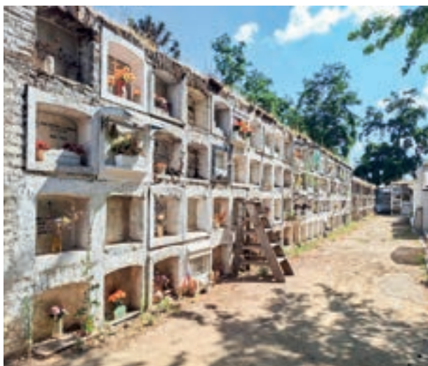
Vista de pasillo de nichos.
