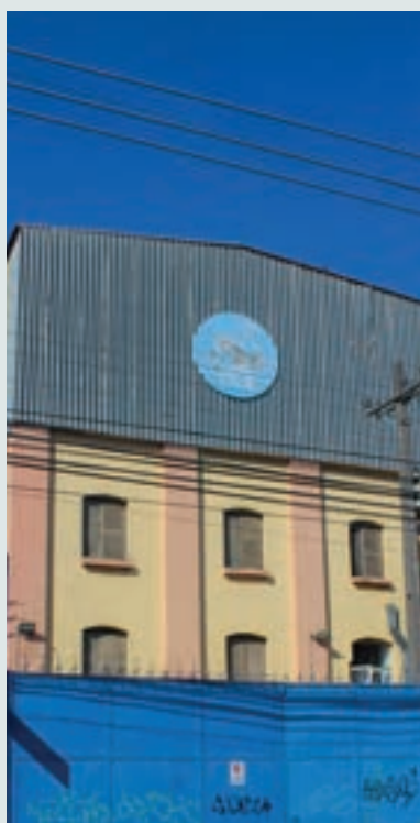
Detalle exterior del inmueble.
