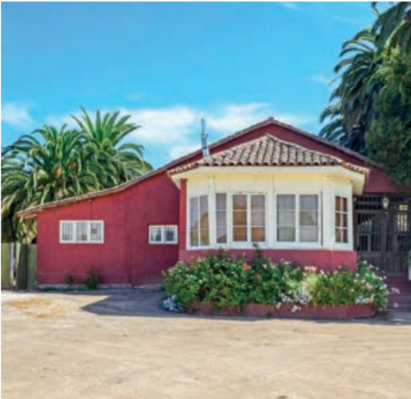
Vista a la fachada lateral del inmueble.
