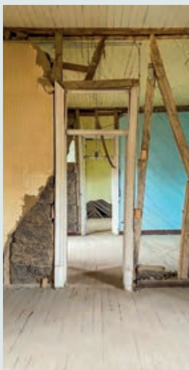
Detalle de tabiquería de madera rellena.
