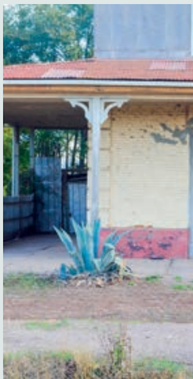
Detalle de pilar de madera con enjuta.
