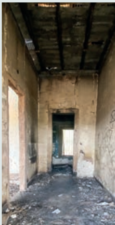
Vista del interior de la estación.
