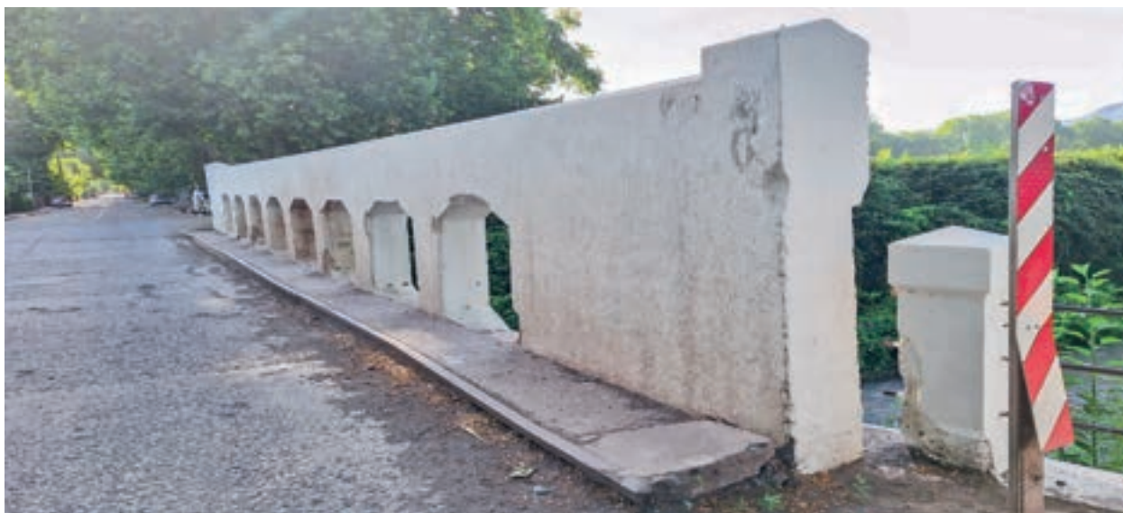
Detalle de baranda.
