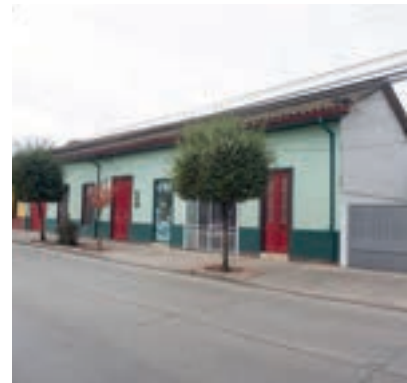
Vista de inmueble, desde calle Miraflores.
