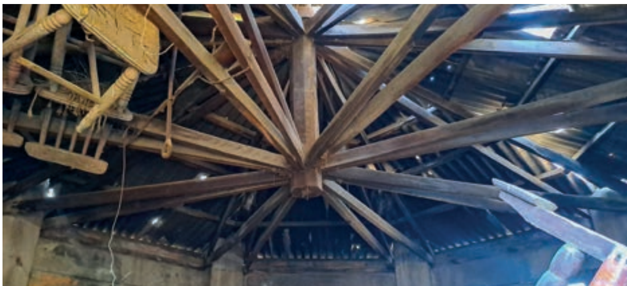
Detalle cubierta inferior de la copa de agua.
