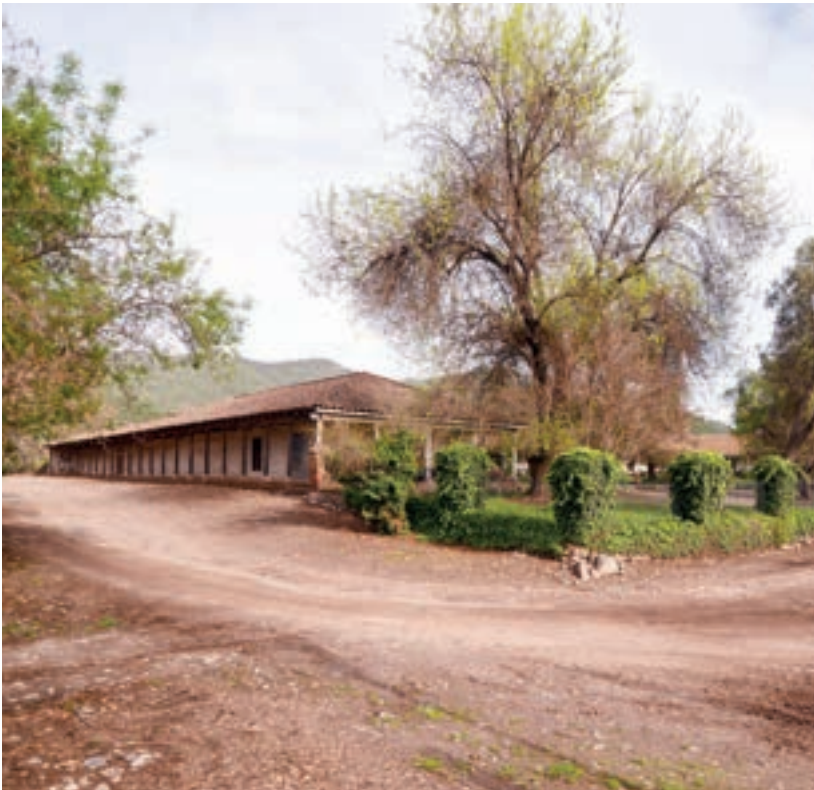
Vista lateral de la casona.
