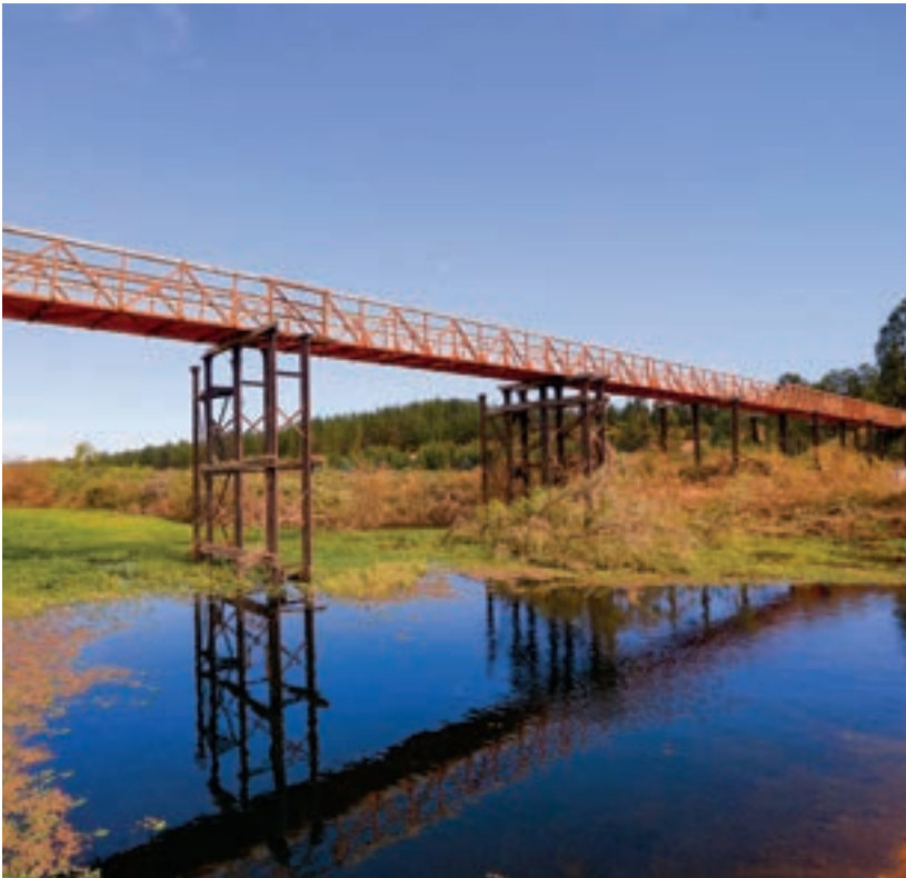
Vista general del puente.
