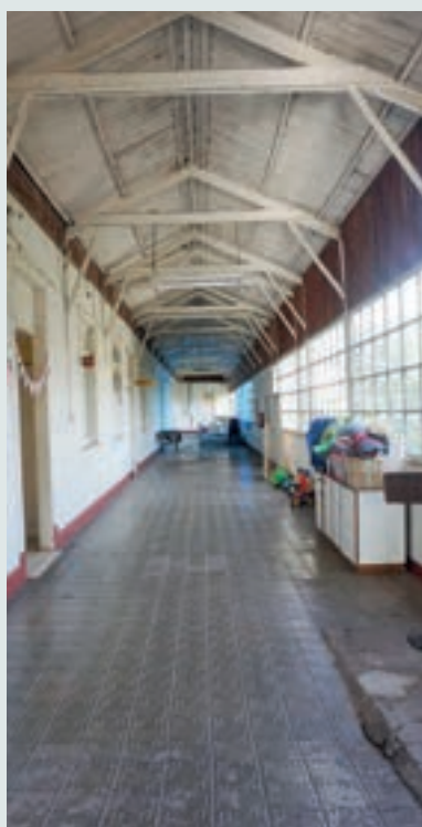
Detalle de la galería corredor.
