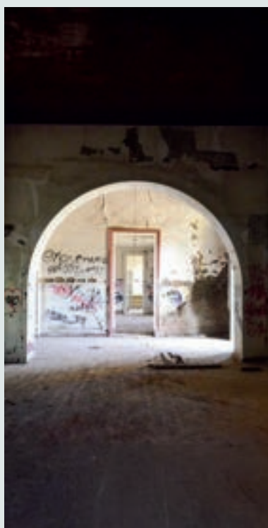
Vista interior de la vivienda.
