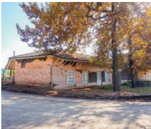
Vista de un inmueble emplazado en el área.
