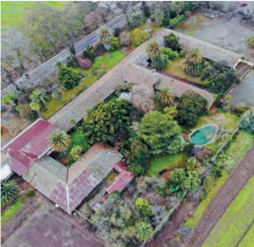
Vista aérea del fundo.
