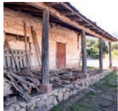
Vista de corredor exterior.
