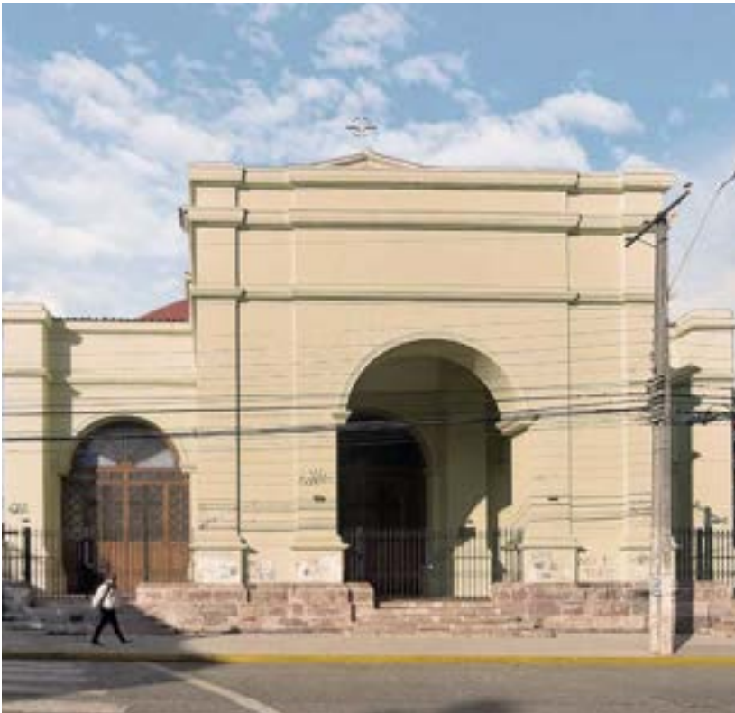
Vista de la fachada principal de la iglesia San Fernando Rey.
