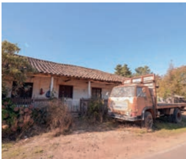
Vista de fachada de una de las viviendas.
