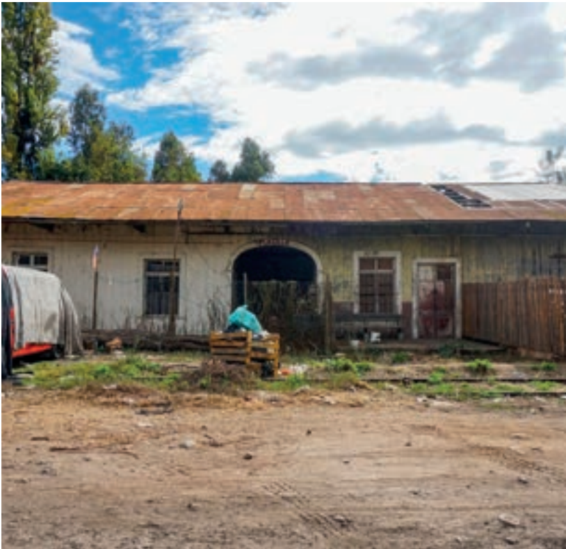
Vista de fachada principal de la estación de Placilla.
