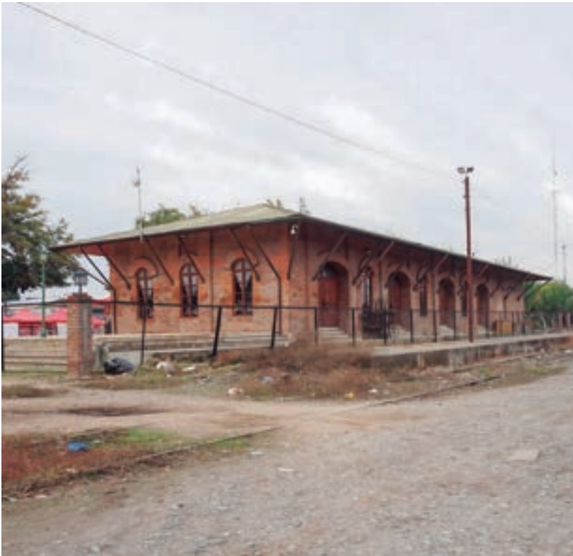
Vista general de la estación desde vía férrea.
