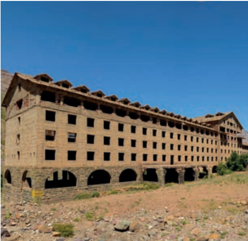
Vista del edificio mirando hacia el sur poniente.
