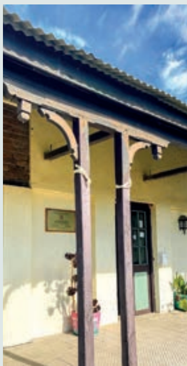
Detalle de los pilares del corredor.
