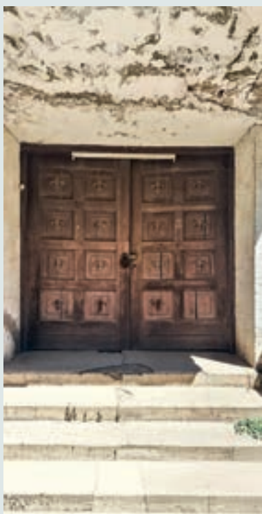
Detalle de puerta de acceso a la capilla.
