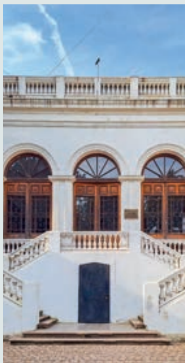
Detalle de escalera y balastrada.
