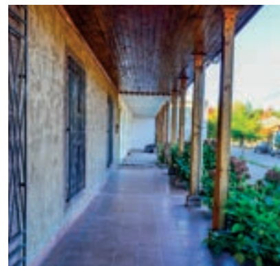
Detalle de corredor.
