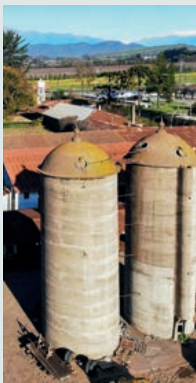
Vista de los silos.
