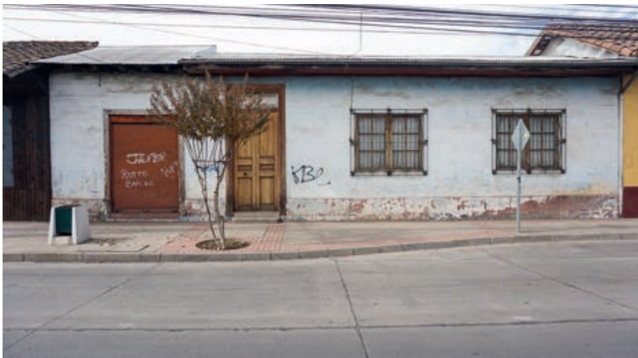
Vista de fachada de inmueble, desde calle Miraflores.
