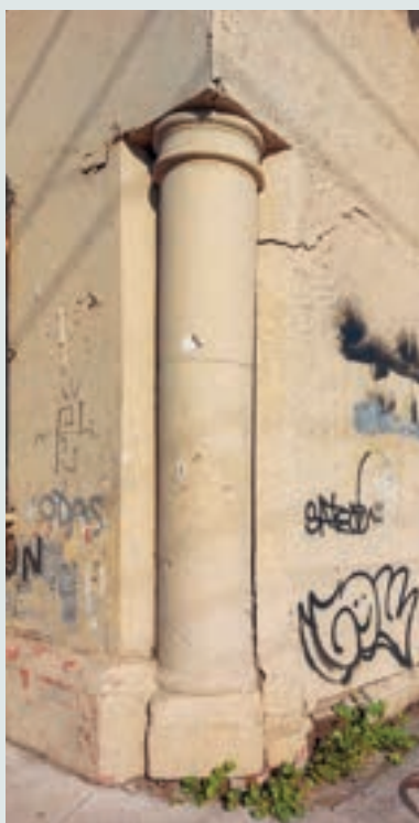
Detalle de pilar esquina.
