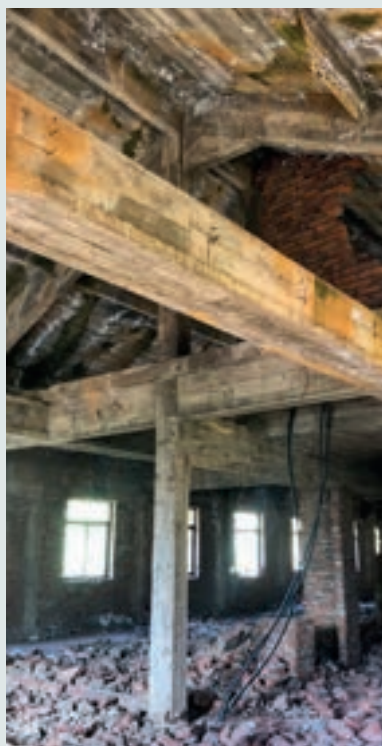
Vista interior del ex sanatorio.
