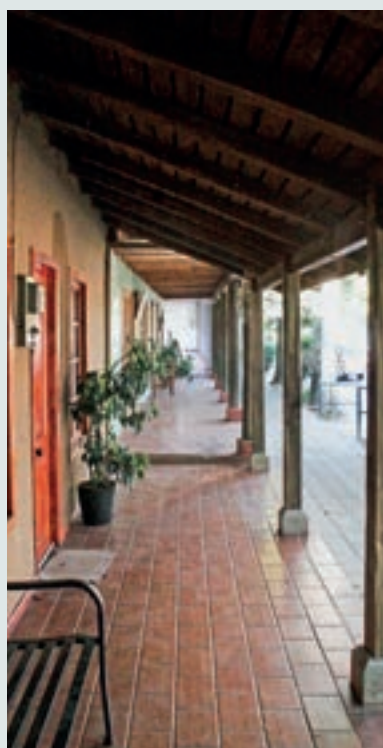
Vista del corredor exterior.
