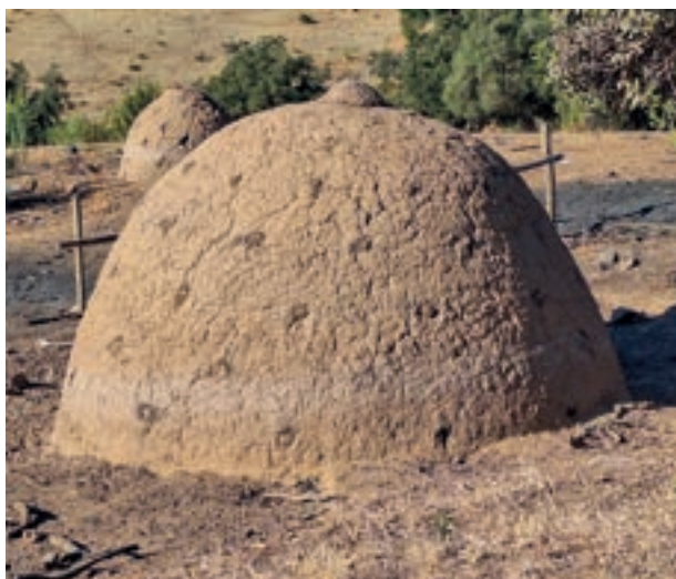
Detalle de perforaciones del horno.
