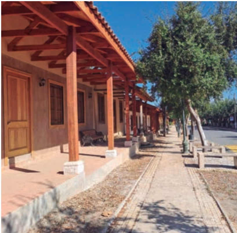
Vista de fachada continua con corredores.
