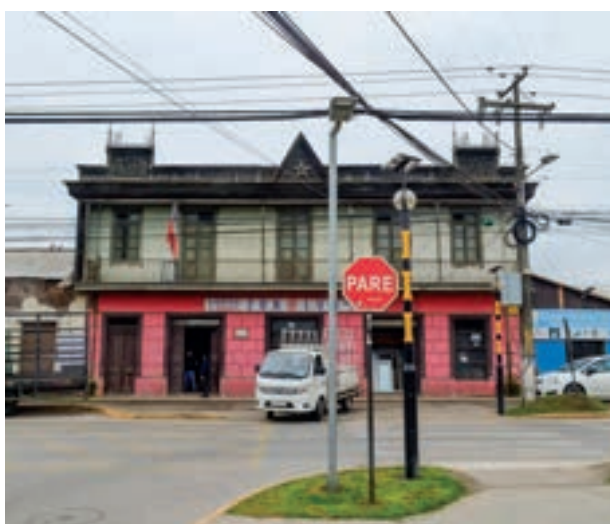
Vista frontal de la casa Gabarda.
