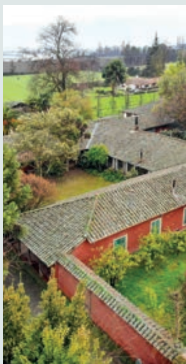
Vista aérea del fundo.
