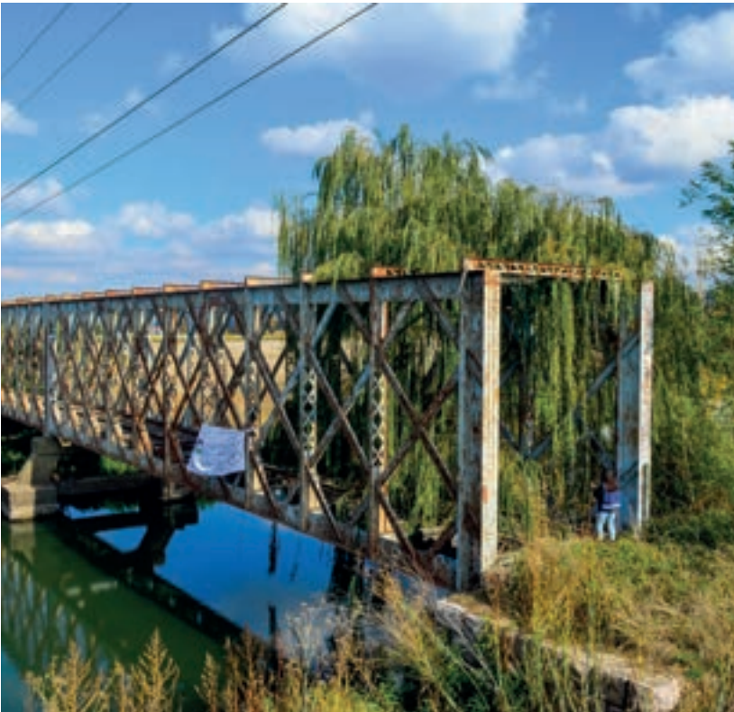
Vista general del puente ferroviario.
