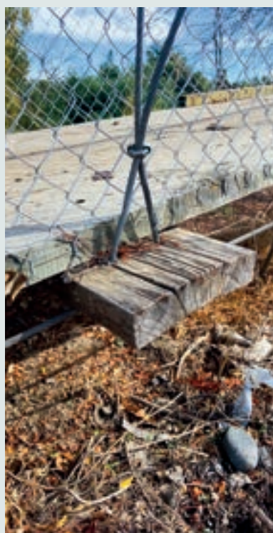
Detalle de estructura y unión del puente.
