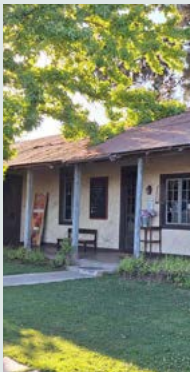
Vista del corredor exterior.
