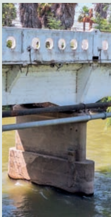
Detalle de pilar de hormigón armado.
