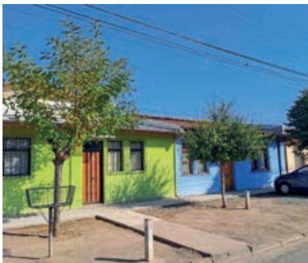
Vista de viviendas de fachada continua, desde calle Tres Montes.
