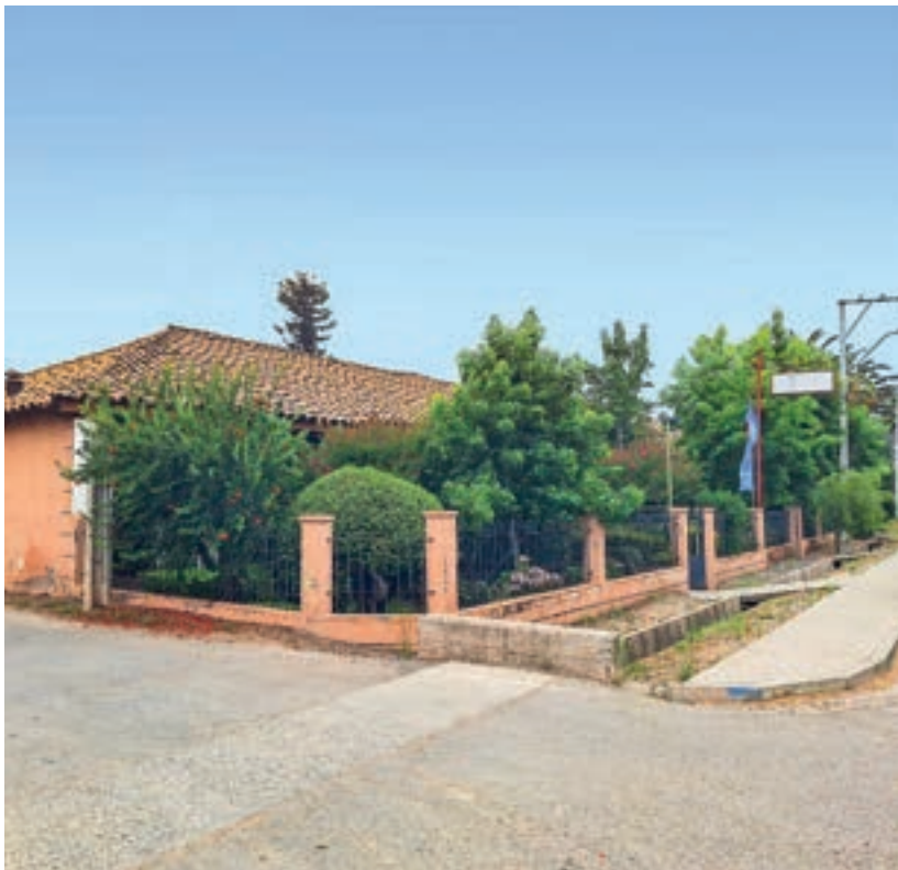
Vista del almacén y su contexto.
