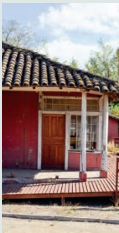
Vista del corredor exterior.
