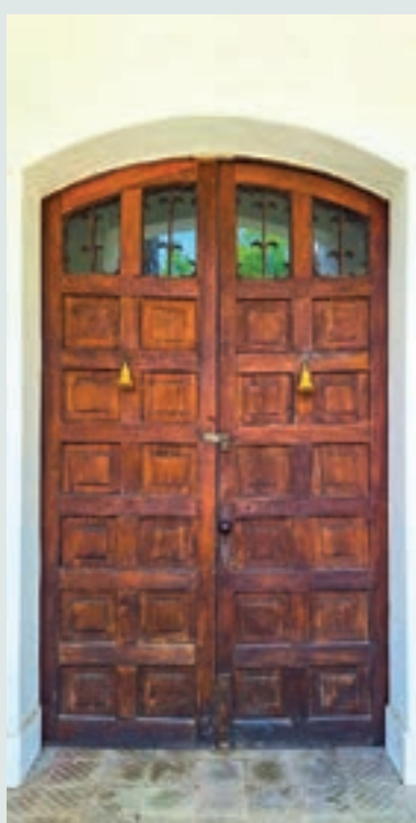
Detalle de la puerta de acceso a iglesia.
