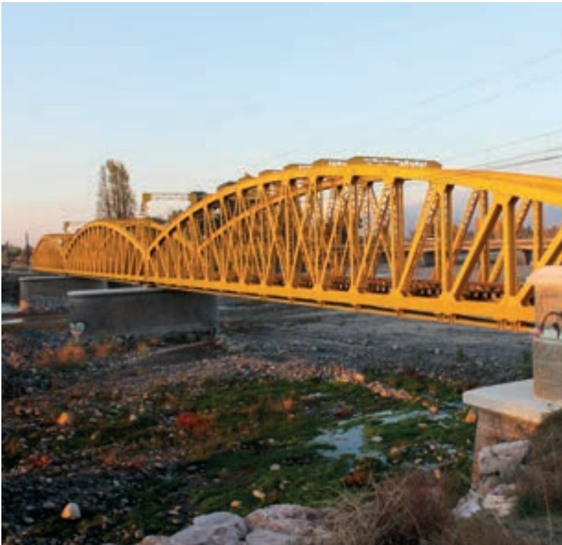
Vista general del puente ferroviario.
