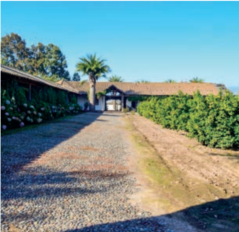
Vista general de la bodega desde su jardín interior.
