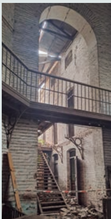
Vista del interior.
