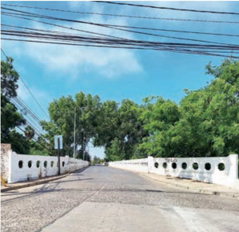
Vista del acceso al puente.
