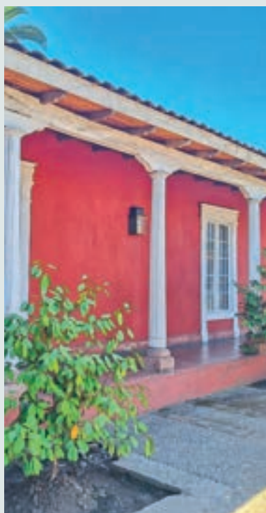
Detalle de pilares del corredor.
