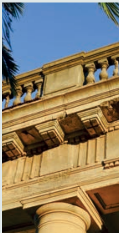
Detalle del entablamento de la fachada.
