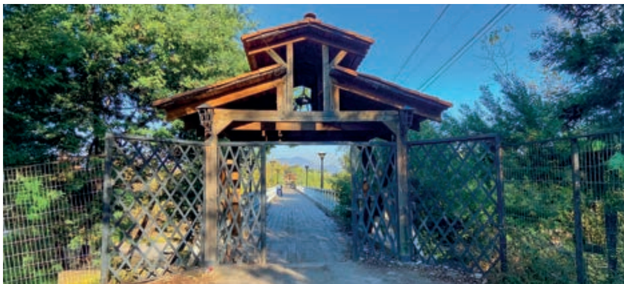
Vista del acceso.
