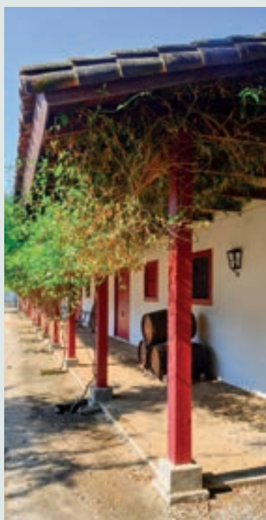
Vista del corredor con pilares de madera.
