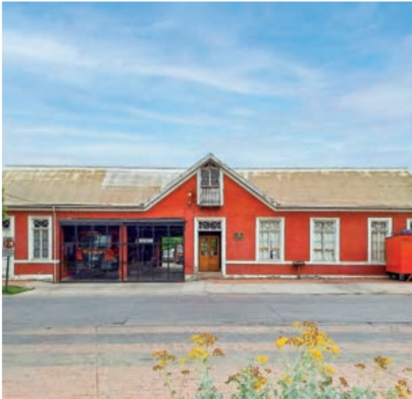
Vista a la fachada principal del cuartel de bomberos.
