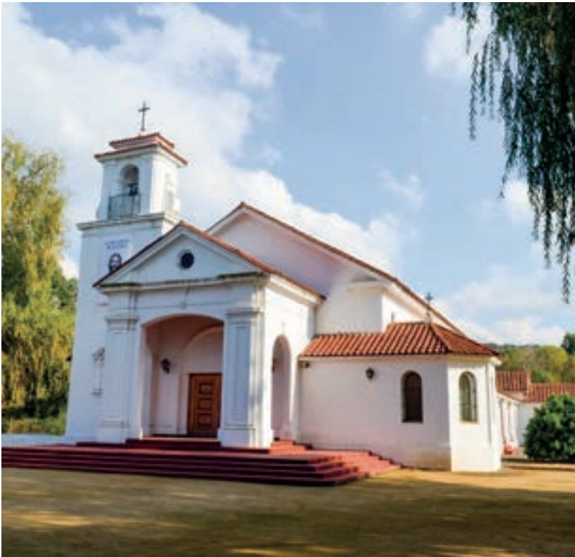
Vista general de la capilla.
