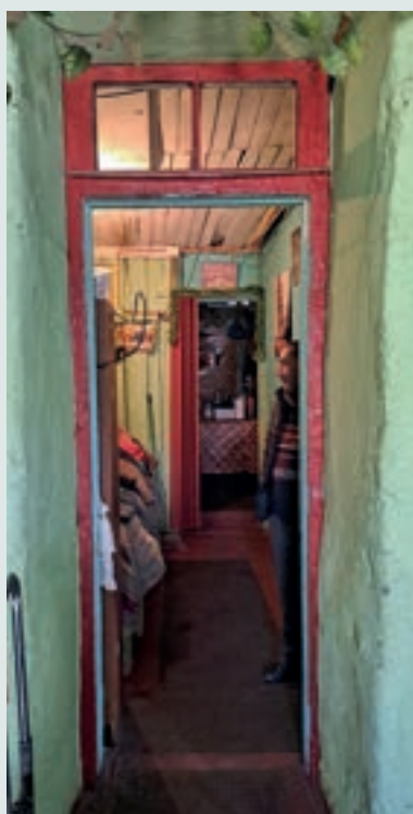
Detalle puerta interior.
