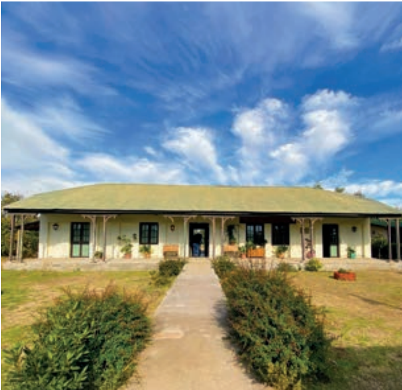
Vista de la fachada principal de la escuela y su jardín.
