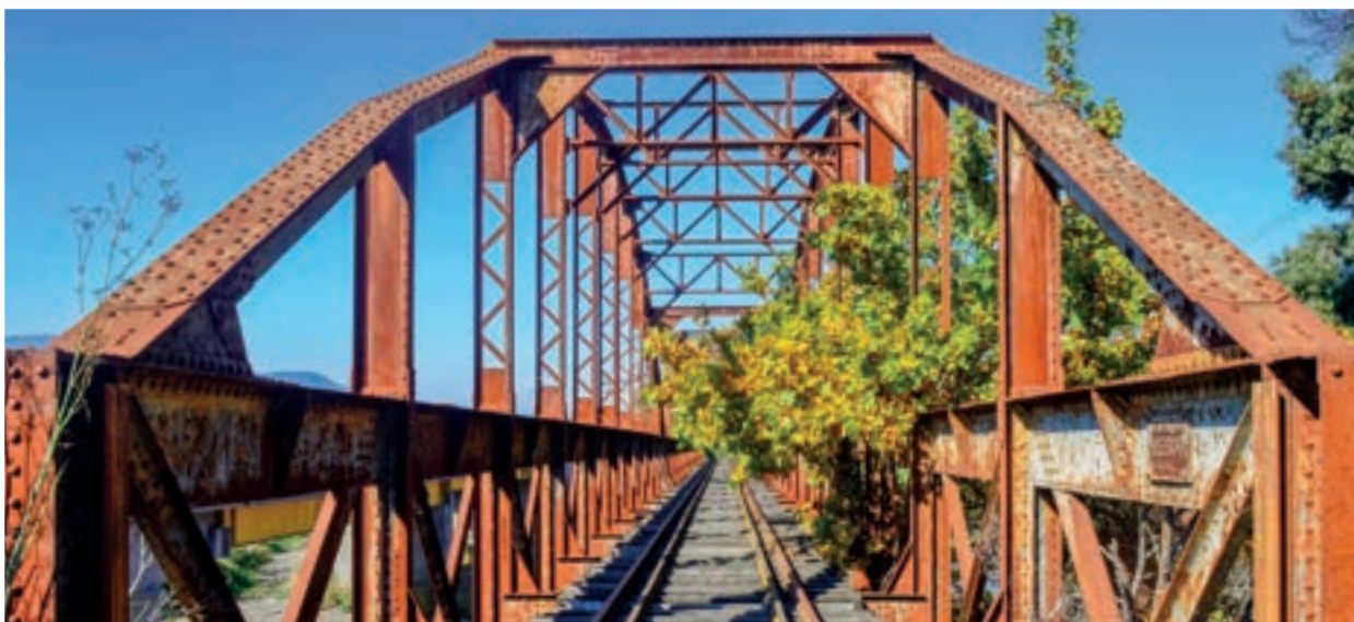
Vista del puente desde uno de sus extremos.
