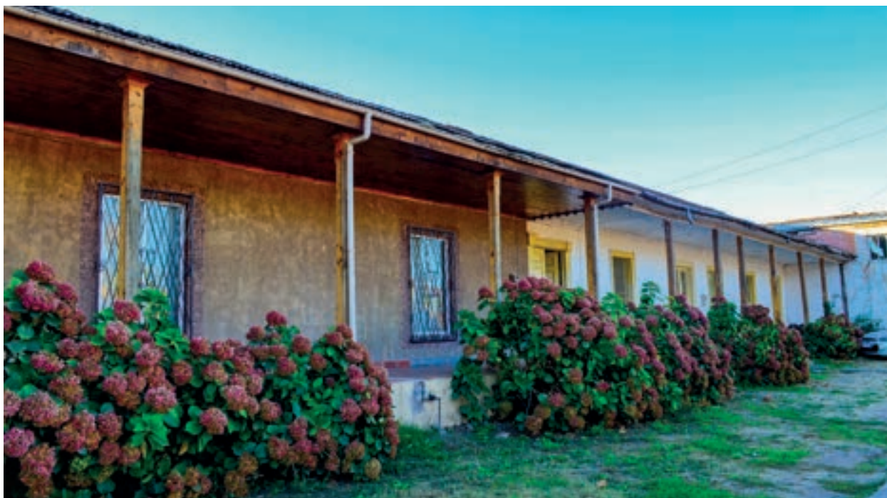
Vista de viviendas continuas con corredor exterior.
