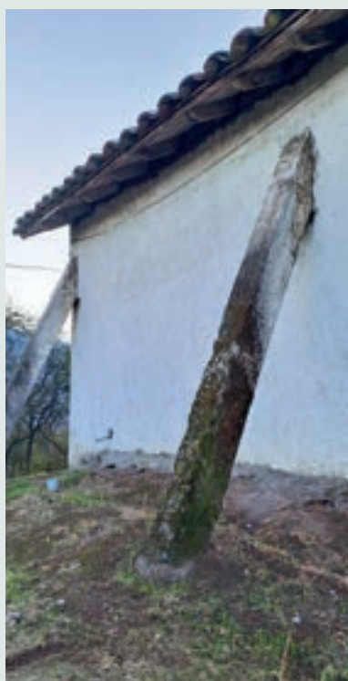
Detalle de los refuerzos exteriores.
