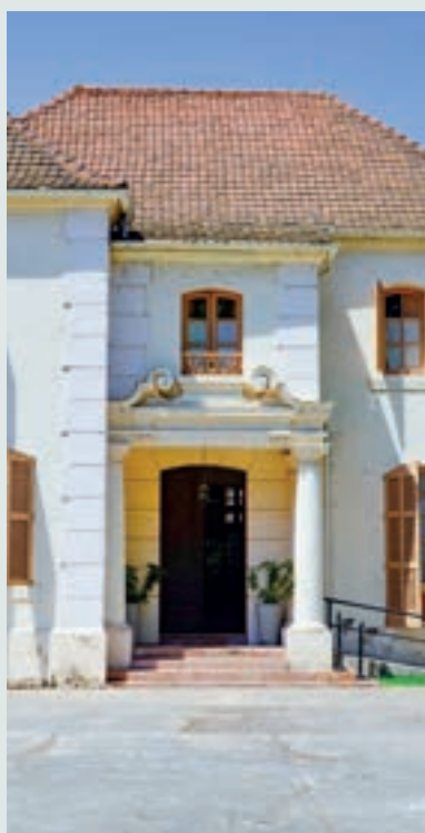
Detalle exterior del acceso.
