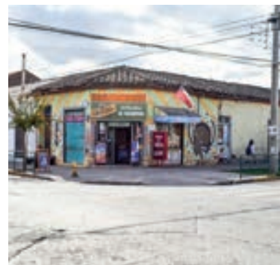
Vista de esquina ochavada.
