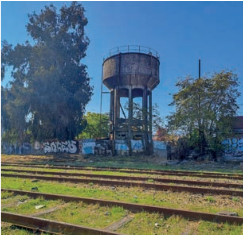
Vista general de la copa de agua desde la vía férrea.
