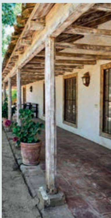
Detalle de pilar del corredor exterior.
