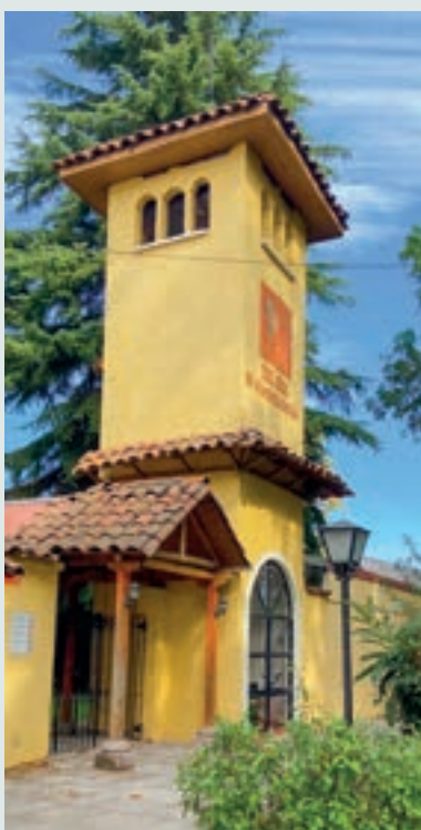
Detalle de torre campanario.
