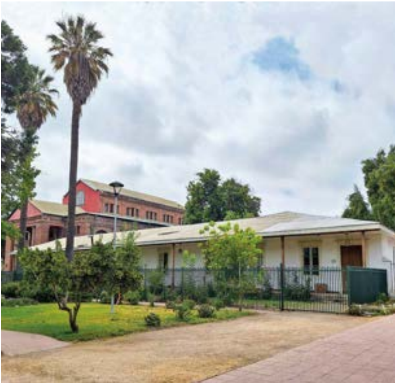
Vista general de la casa parroquial.
