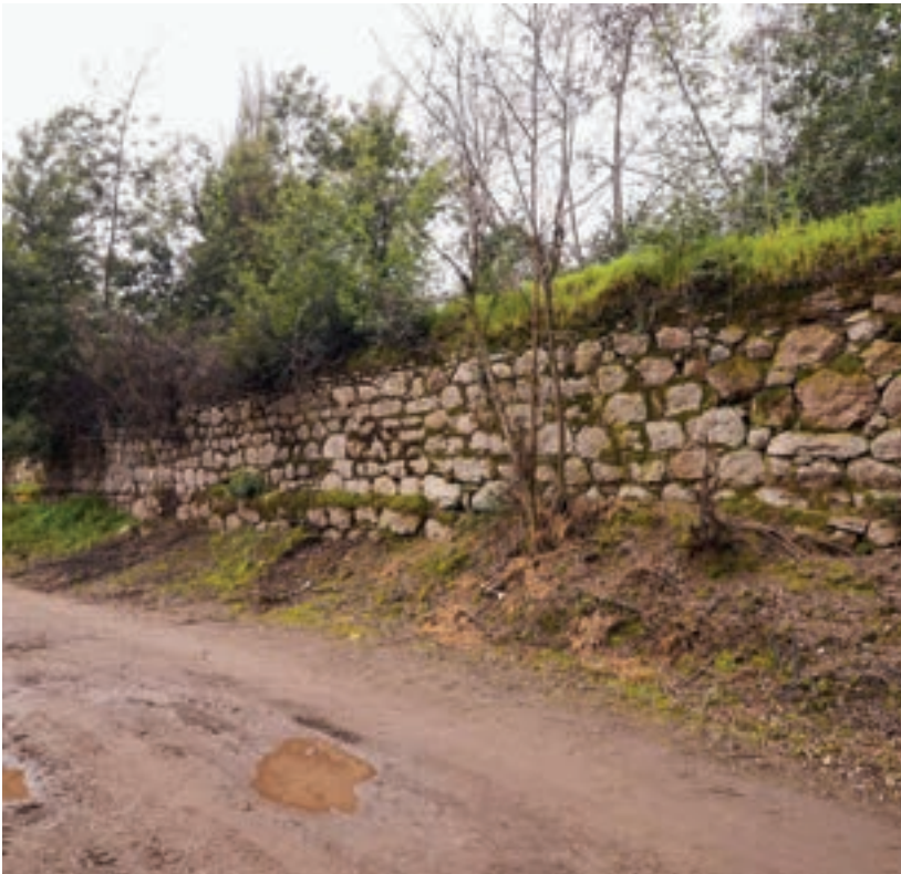
Vista general del acueducto.
