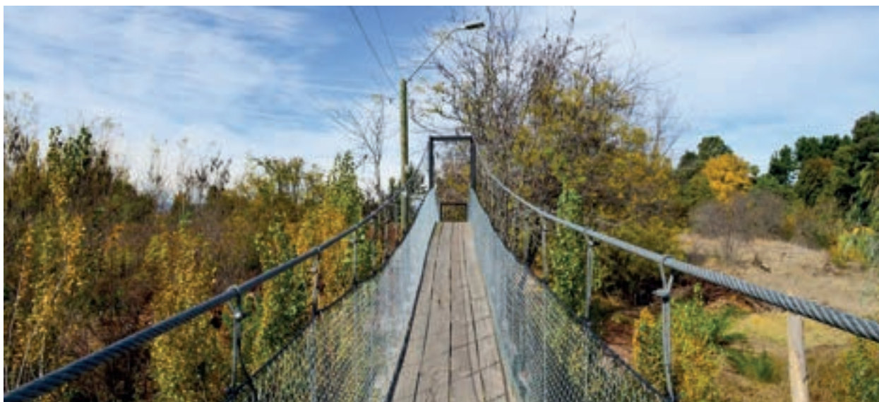
Vista superior del puente de cimbra.
