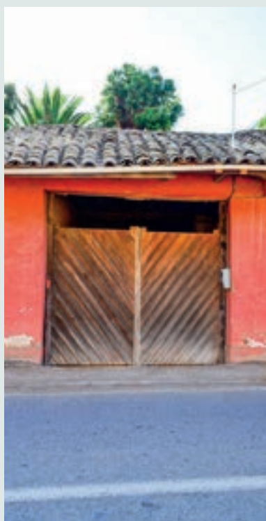
Detalle de portón de acceso.
