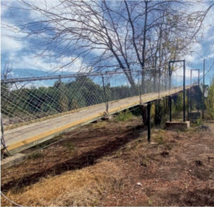
Vista general de puente de cimbra de Calleuque.
