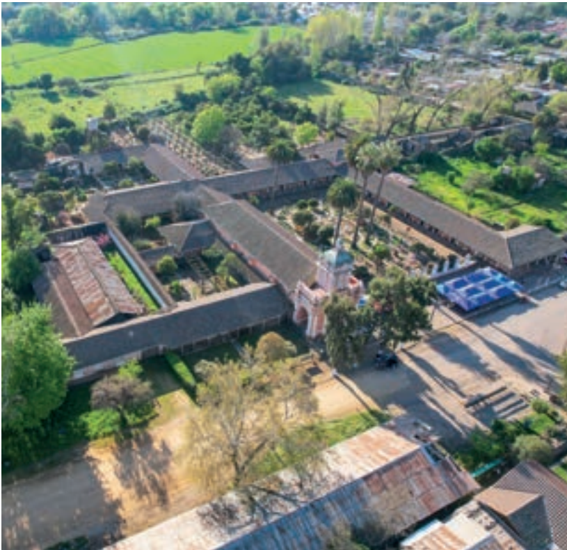
Vista del acceso principal de las dependencias.
