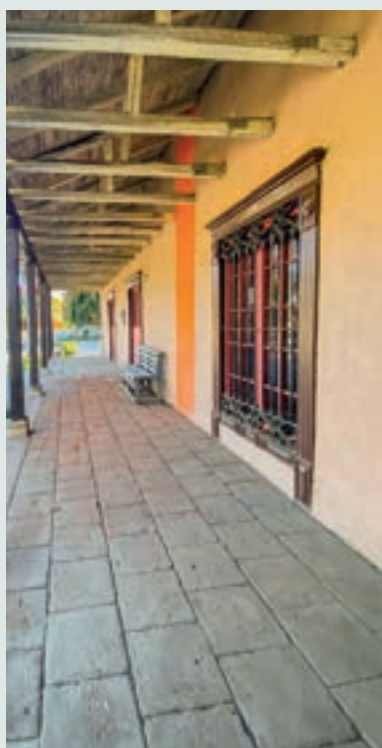
Detalle del corredor exterior.
