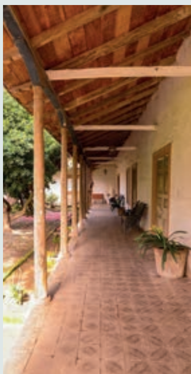
Vista del corredor interior.
