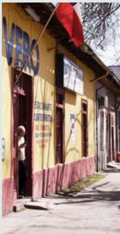
Detalle exterior del inmueble.
