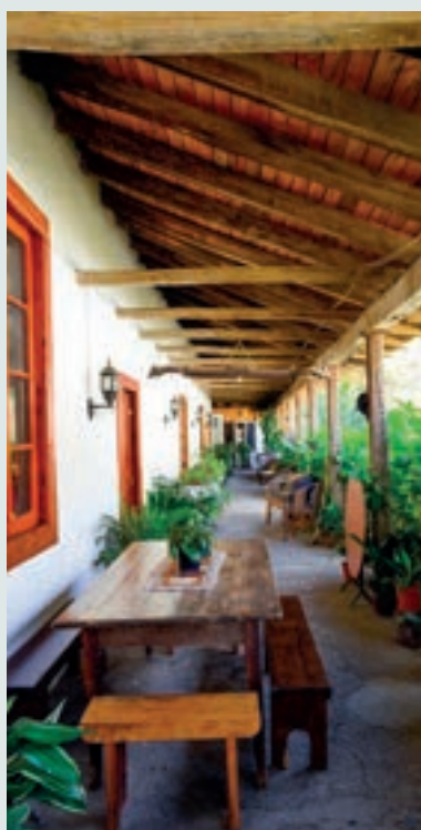
Detalle del corredor exterior.
