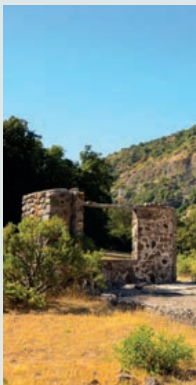
Vista de los restos de la oficina.
