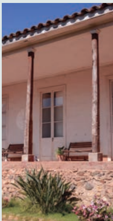
Detalle de corredor y pilares.
