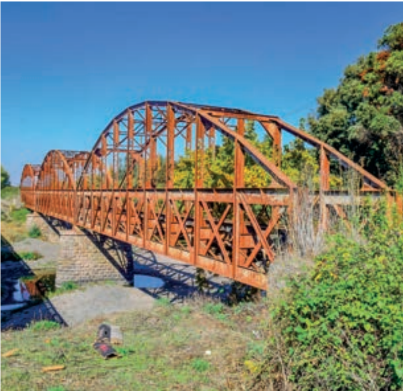
Vista general del puente ferroviario.
