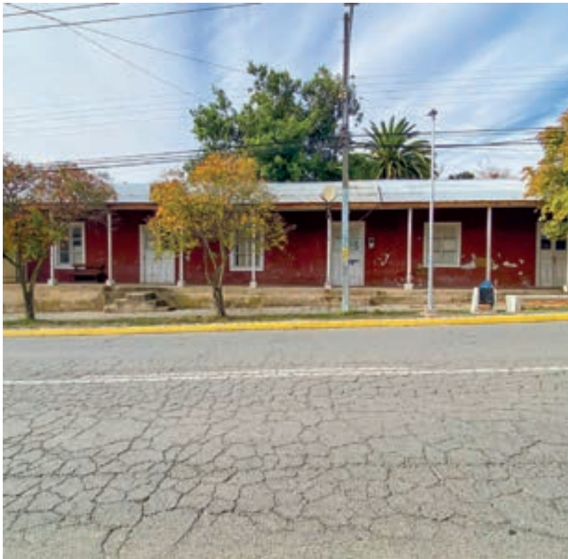
Vista de fachada de vivienda con corredor, desde ruta I-60.
