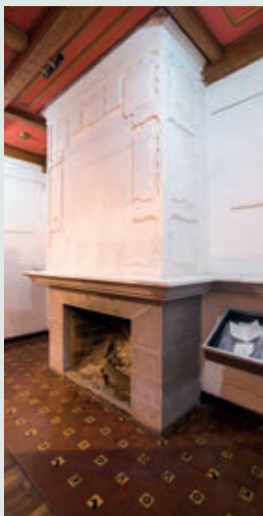
Detalle de chimenea.
