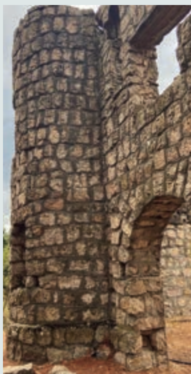
Detalle de mampostería de piedra.
