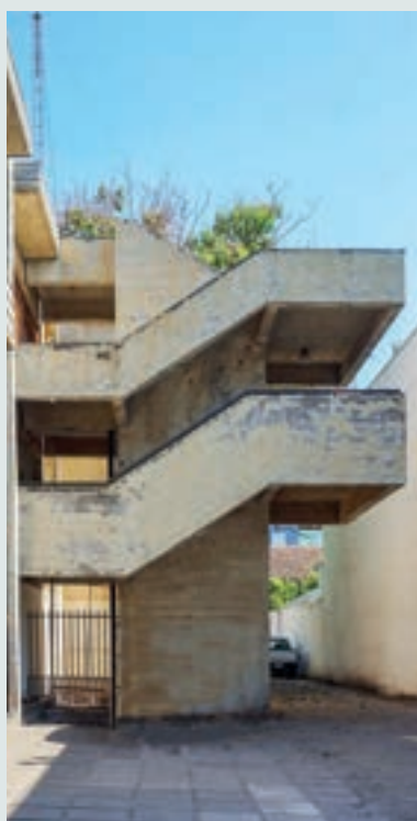
Detalle escalera exterior del edificio.
