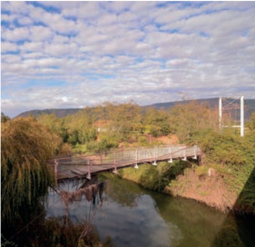
Vista general del puente colgante La Cabaña, desde ruta I-72.
