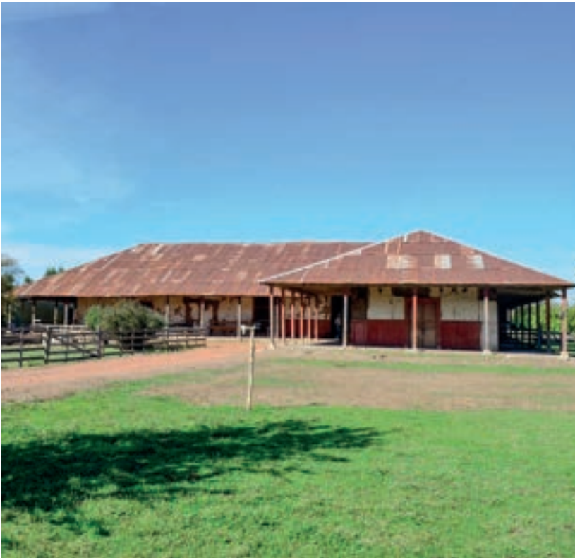
Vista de la fachada principal del ex fundo Chimbarongo.
