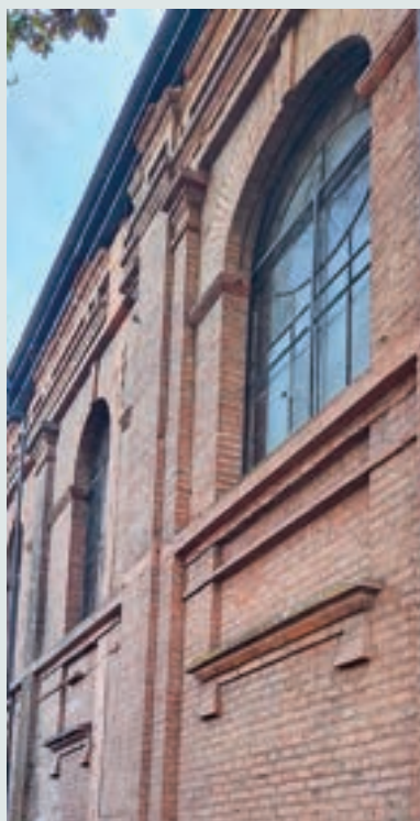
Detalle de muro exterior.
