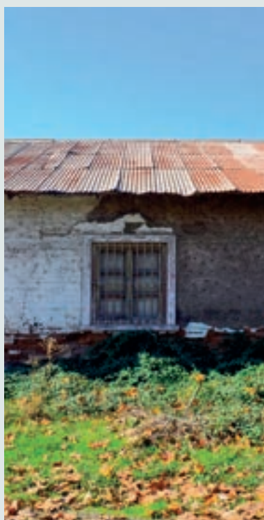
Vista de detalle exterior de la cochera.
