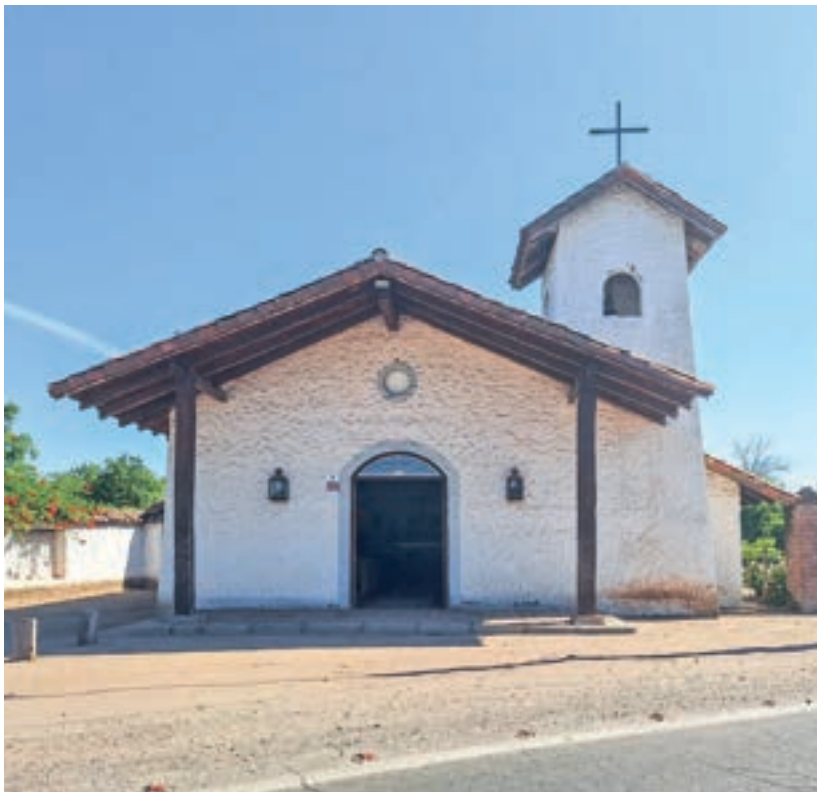
Vista de fachada principal de la capilla.
