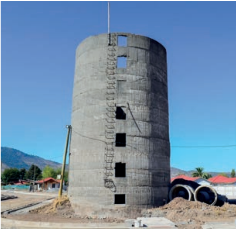
Vista frontal del silo.
