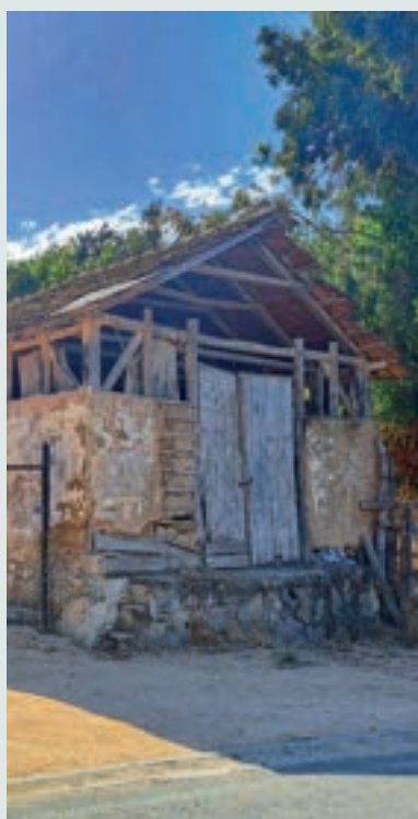
Vista lateral de uno de los inmuebles.
