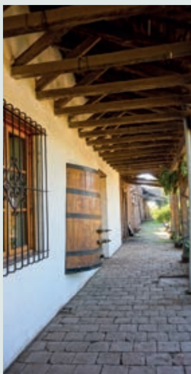
Vista del corredor con pilares y tornapuntas.
