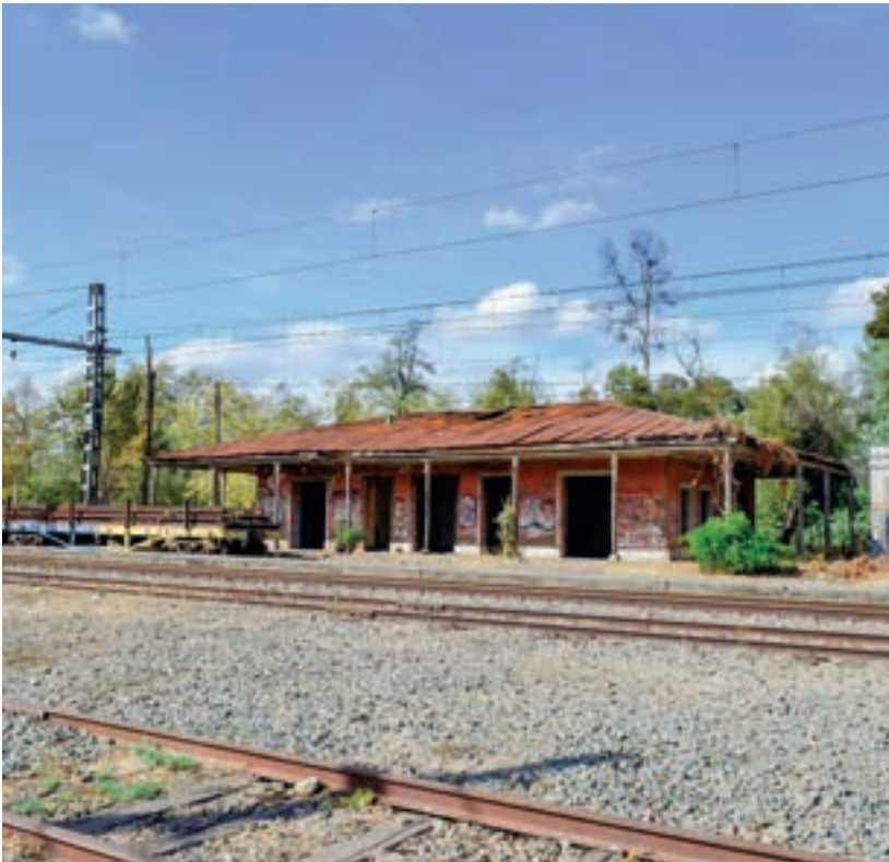
Vista de la estación de ferrocarriles de Chimbarongo, desde línea férrea.
