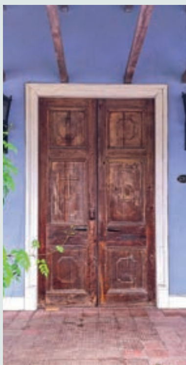
Detalle de carpinterías de la puerta.
