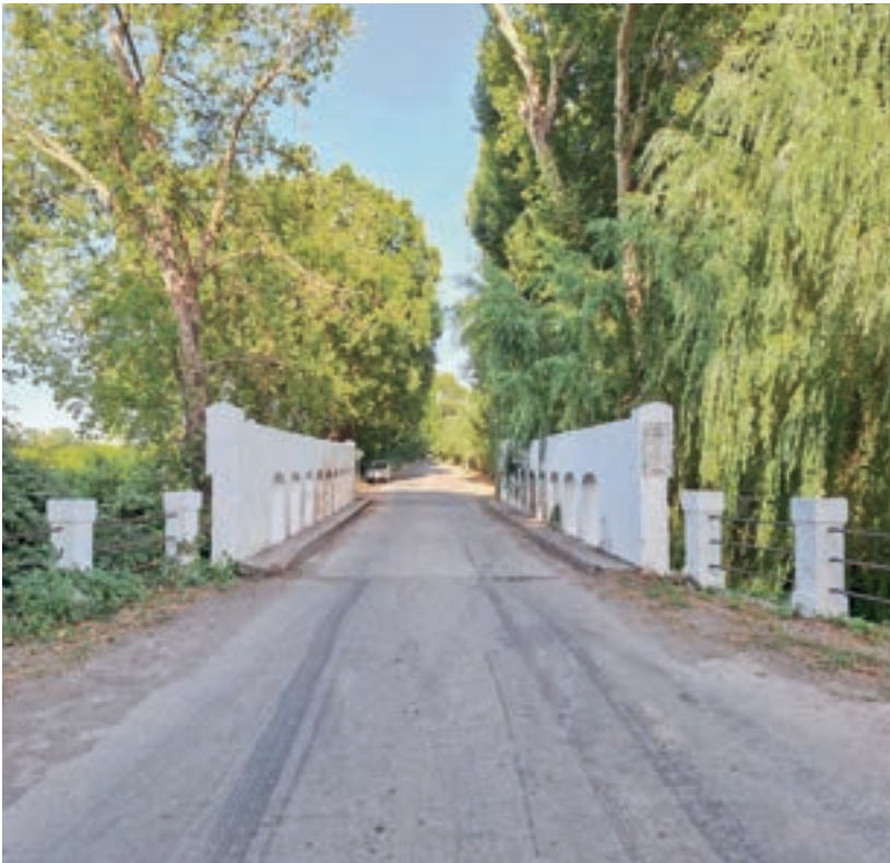
Vista del puente El Cardal y su contexto.
