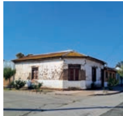
Vista de fachada ochavada.
