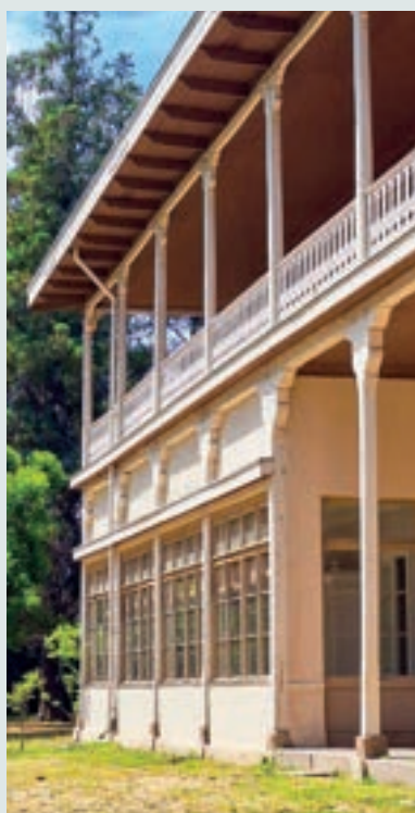
Detalle de carpinterías de pilares y balcón.
