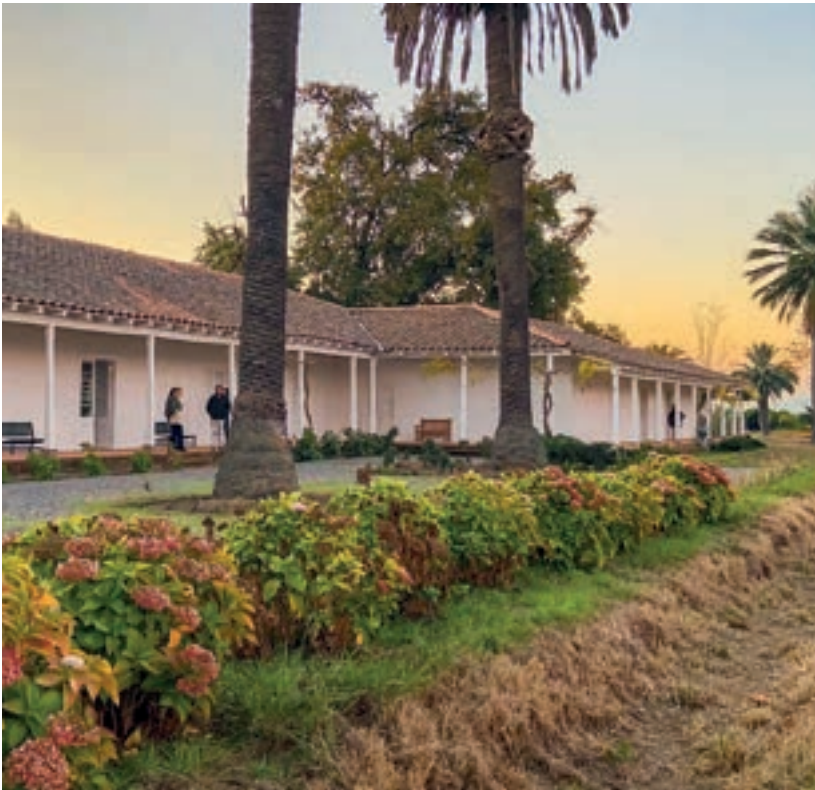
Vista general de la casa patronal del fundo Los Maquis de Colchagua.
