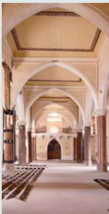
Vista interior de la iglesia.
