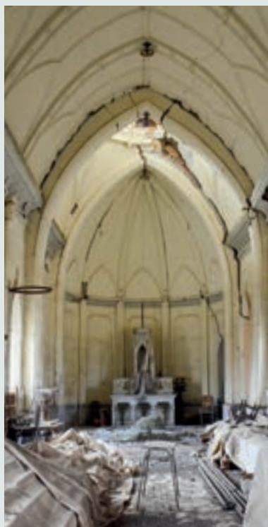
Vista del interior de la nave central.
