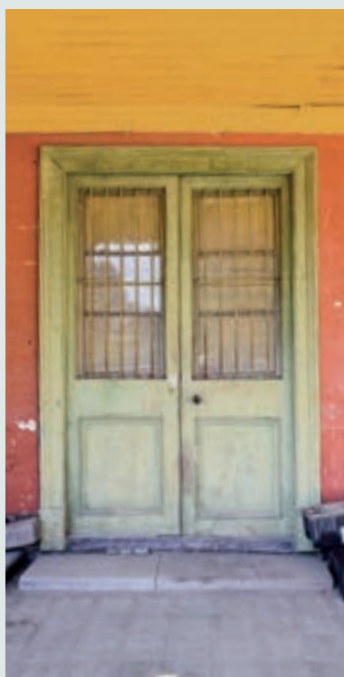
Detalle de puerta de acceso.
