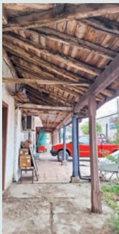
Detalle de corredor.
