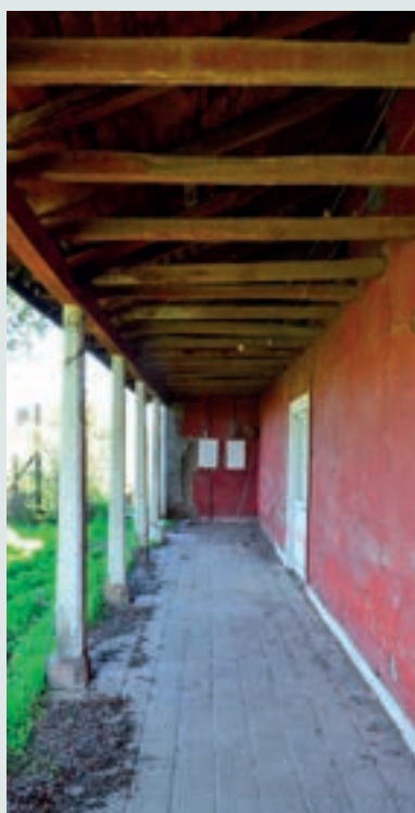
Detalle del corredor exterior.
