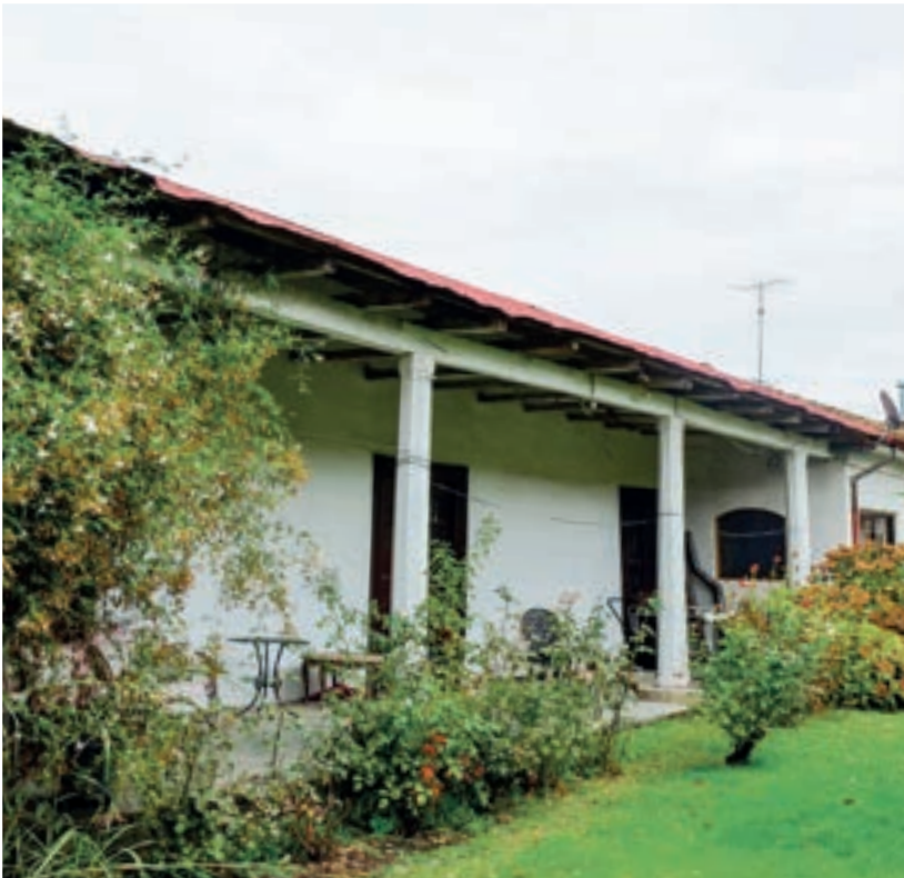
Vista general de la casa patronal viña Macaya Conde.
