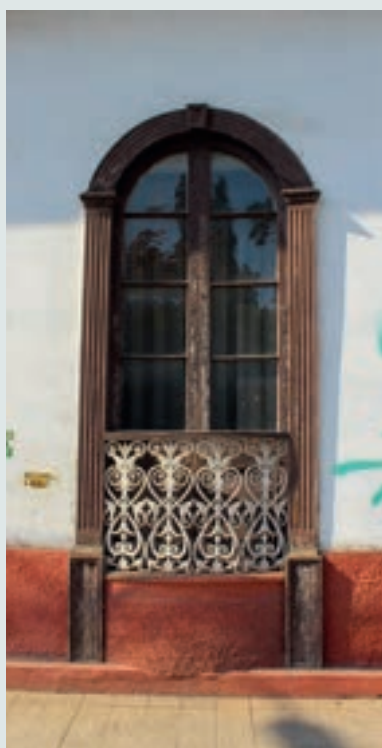
Detalle de carpinterías en ventana.
