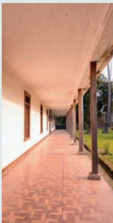
Vista del corredor exterior.
