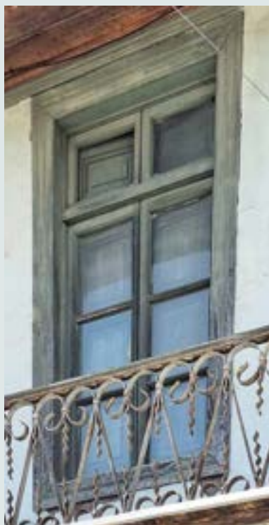
Detalle del balcón del segundo piso.
