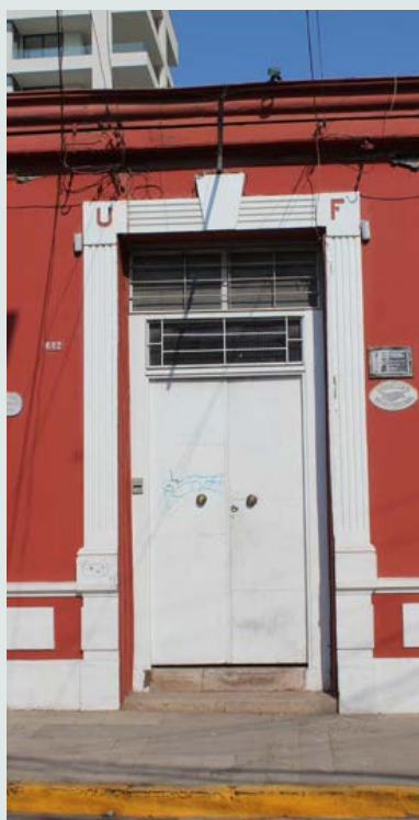
Detalle de puerta de acceso.
