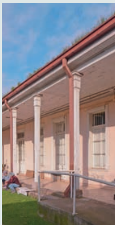
Detalle pilares del corredor.
