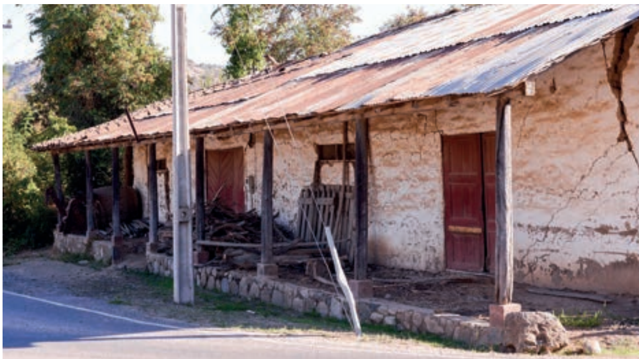
Vista de fachada de una de las viviendas.
