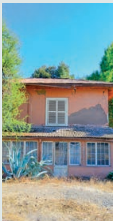
Detalle de ventanas de la estación.
