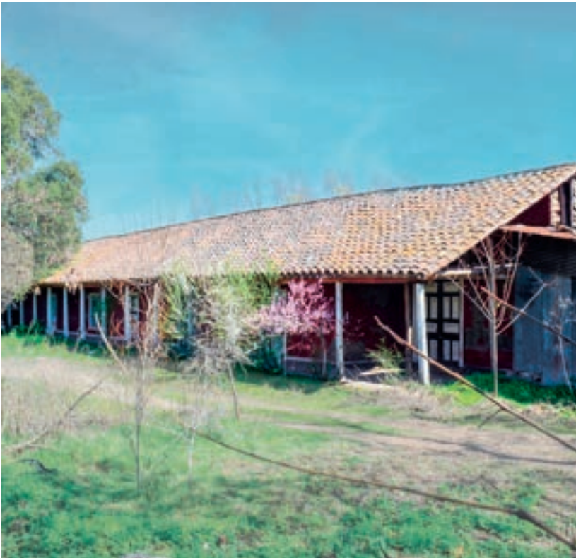
Vista general de la casa patronal ex fundo Santa Gertrudis.
