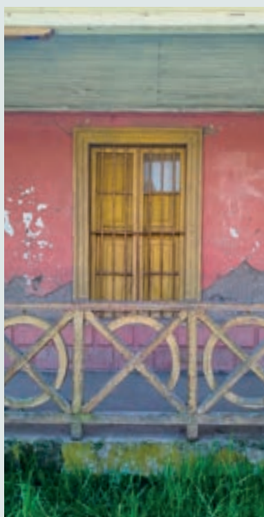
Detalle de ventana y carpinterías de madera.
