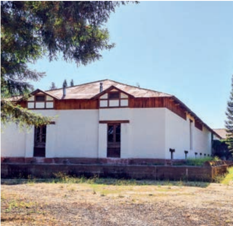
Vista lateral de la ex lechería.
