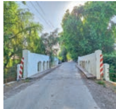
Vista del puente El Cardal.
