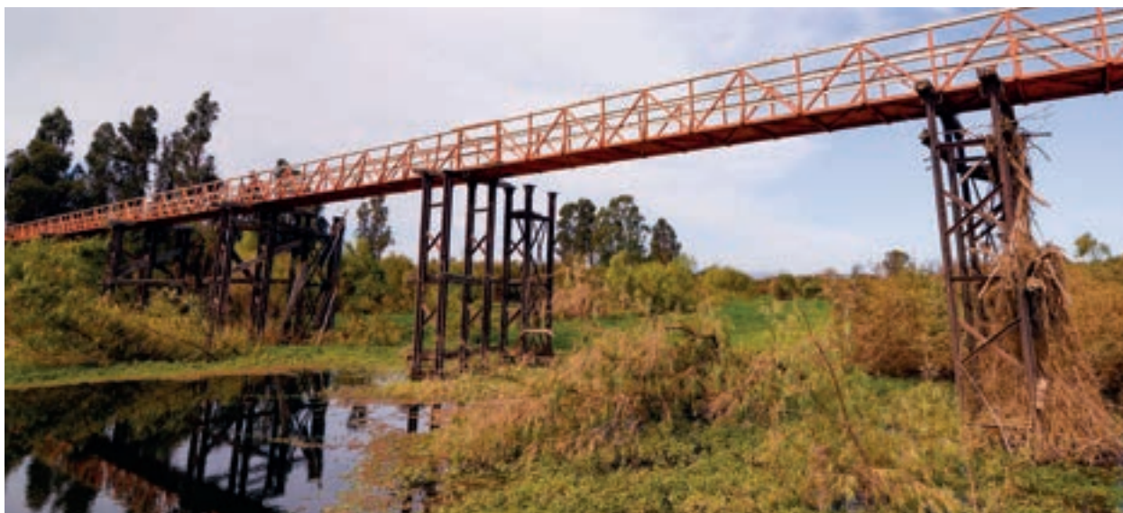
Vista del puente.
