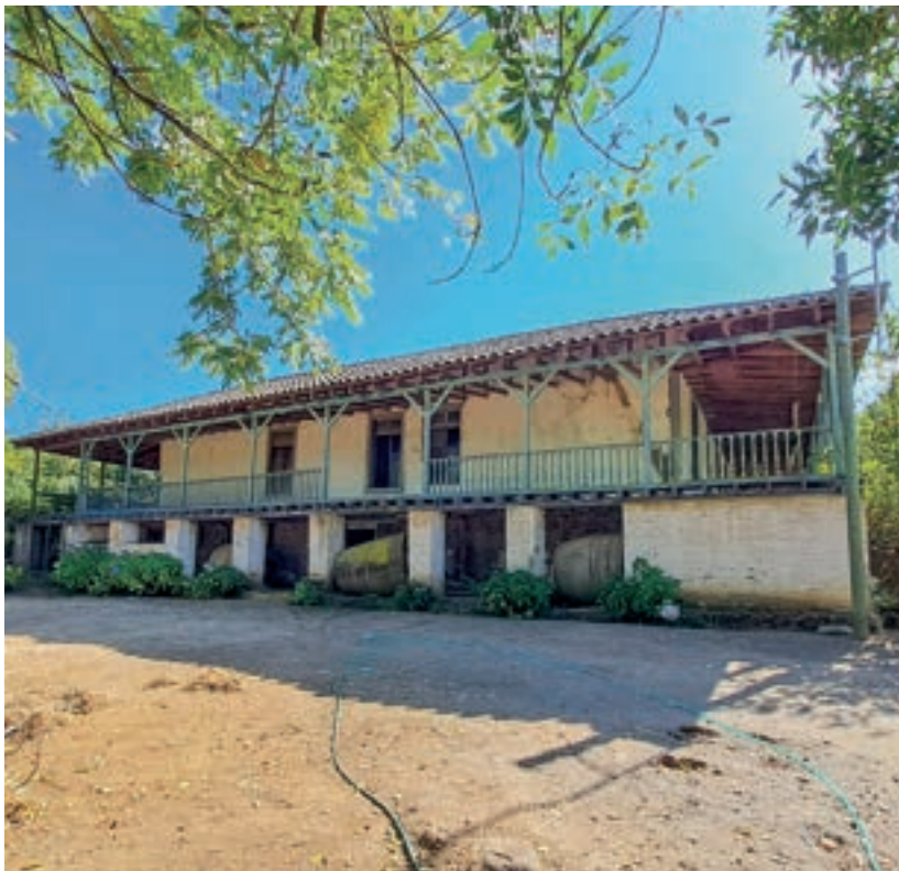
Vista lateral del inmueble.
