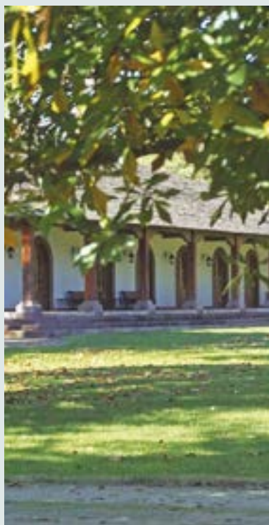
Vista de corredor y patio.
