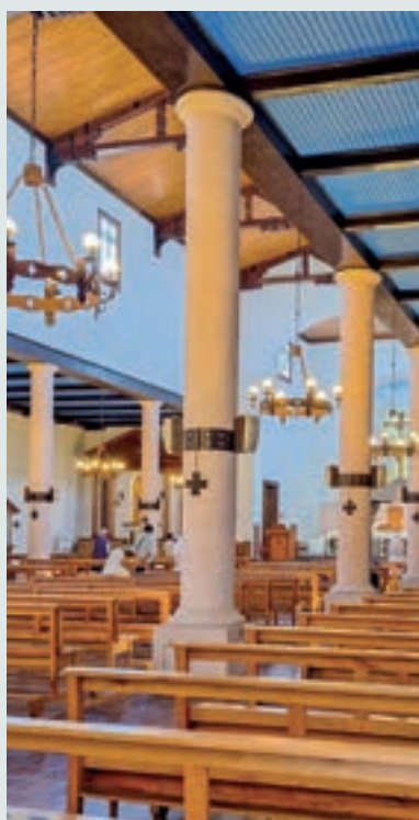
Detalles de pilares interiores de la iglesia.
