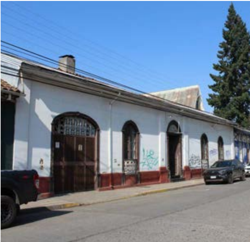
Vista de la fachada principal de la casa familia Amesti.
