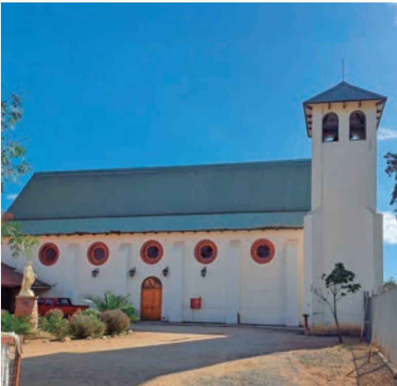
Vista fachada lateral de la iglesia.
