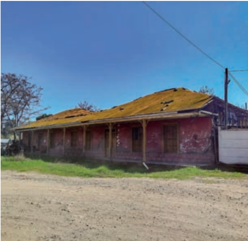
Vista general de la casa del jefe de estación Placilla, desde calle Covadonga.
