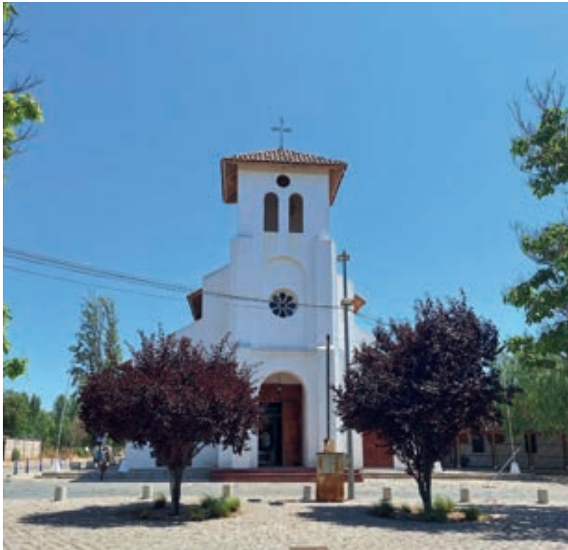
Vista de la fachada de la iglesia.
