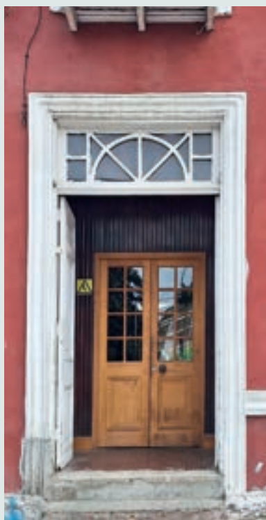
Detalle de carpinterías del acceso.
