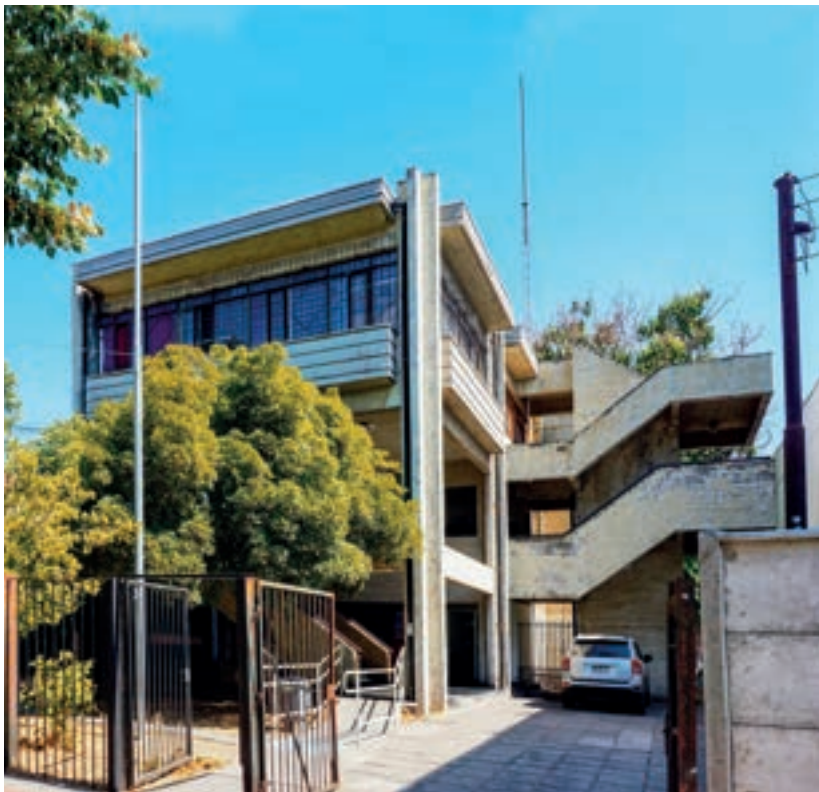
Vista de la fachada principal del edificio registro civil.
