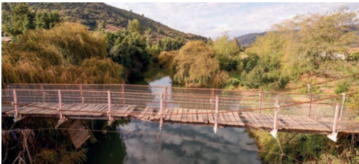
Vista general de la estructura sobre estero Nerquihue.
