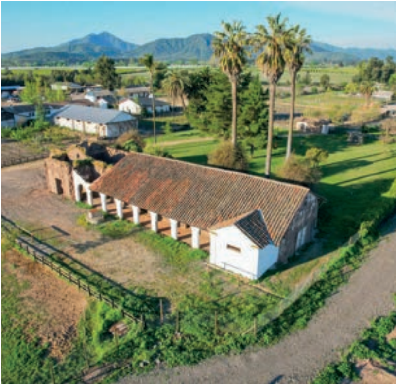
Vista aérea del fundo y su entorno.
