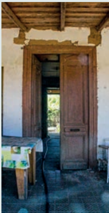
Detalle de carpinterías del acceso.
