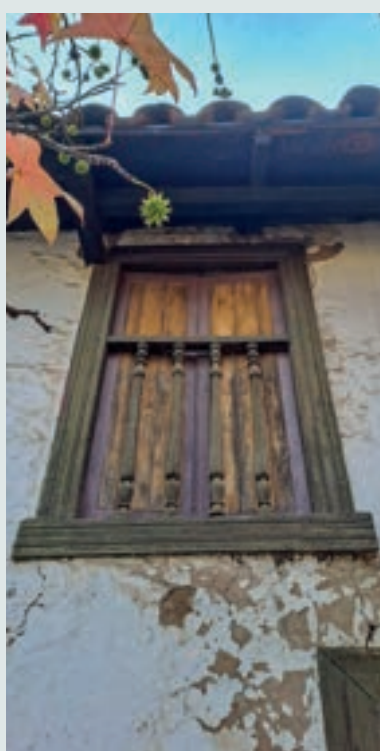
Detalles de las carpinterías de la ventana.
