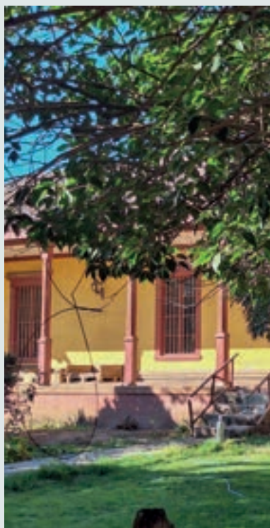
Vista del corredor exterior.
