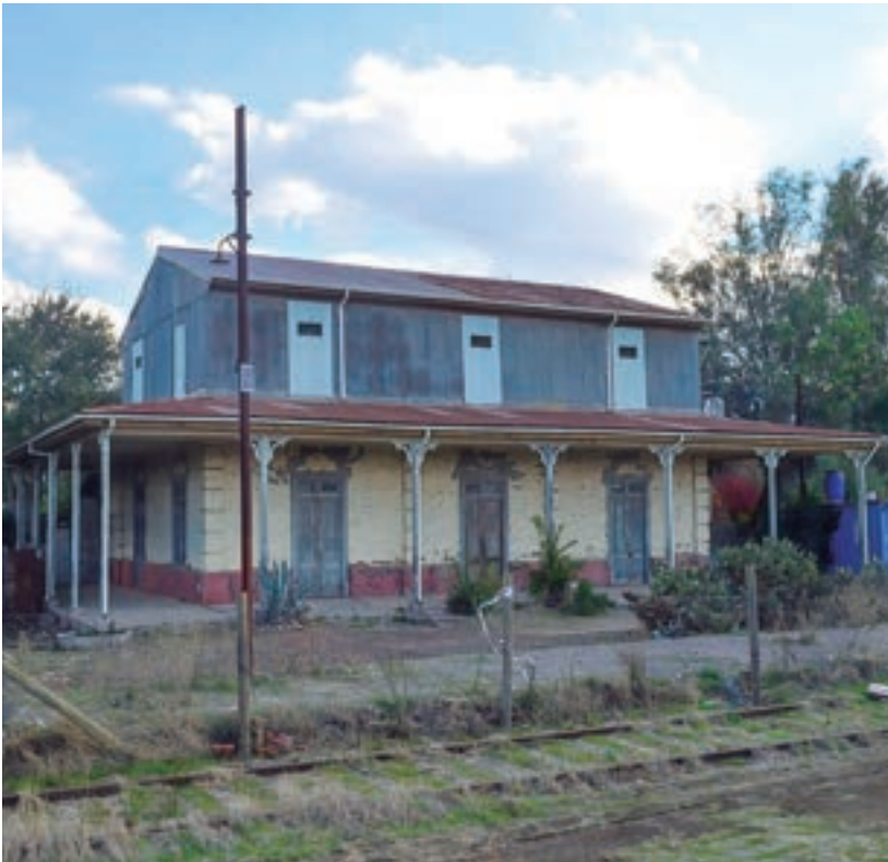
Vista general de la estación y su entorno.
