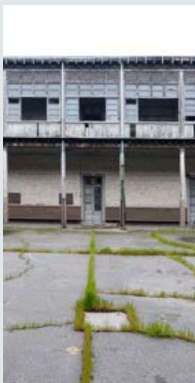
Vista patio y corredor interior del liceo.
