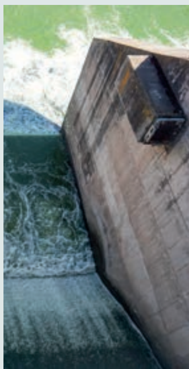
Detalle de compuerta.
