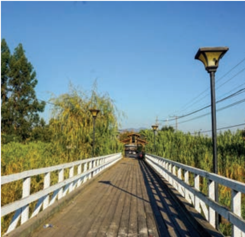
Vista desde el interior del puente.
