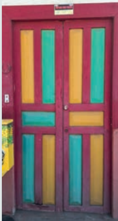
Detalle carpintería de puerta.
