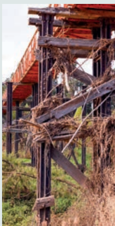
Detalle de la estructura del puente.
