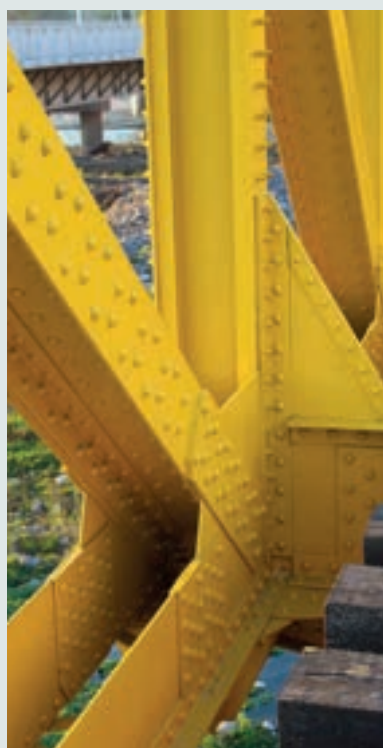
Detalle de la unión metálica.
