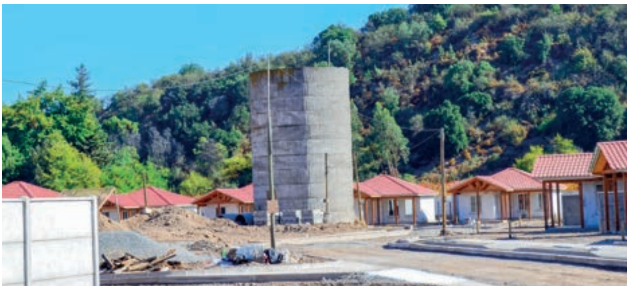
Vista general del silo y villa Manantial.
