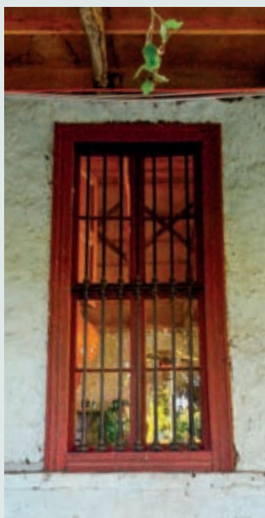
Detalle de ventana.
