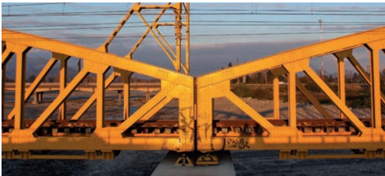
Vista frontal del puente ferroviario.
