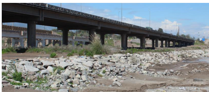
Figura 2-7: Fotografía del muro guardaradier construido.
