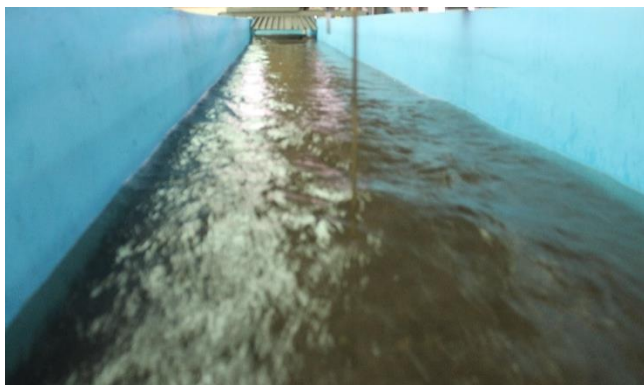
Figura 5-1: Flujo aguas arriba del muro guardaradier.
