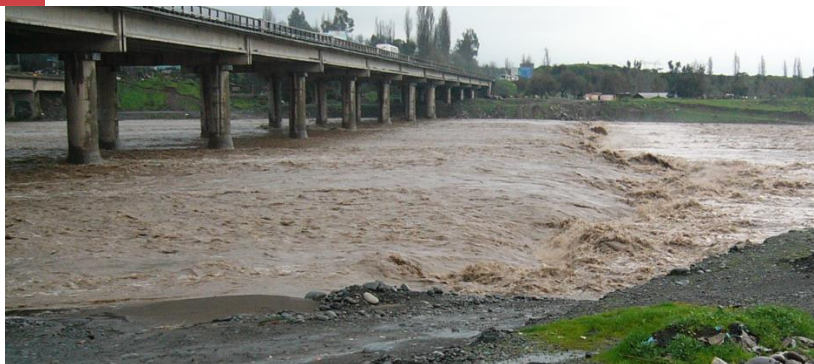
Figura 1-2: Muro guardaradier en funcionamiento (16/08/2008).
