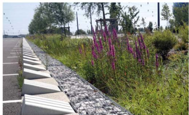
Imagen 6-18: Imágenes de referencia de biofiltros. Fuente: Aguas Consultores.
