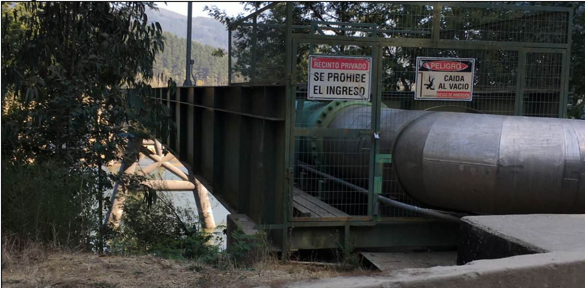
Fotografía N° 4.1: Cruce de tubería terrestre, CFI Nueva Aldea.
