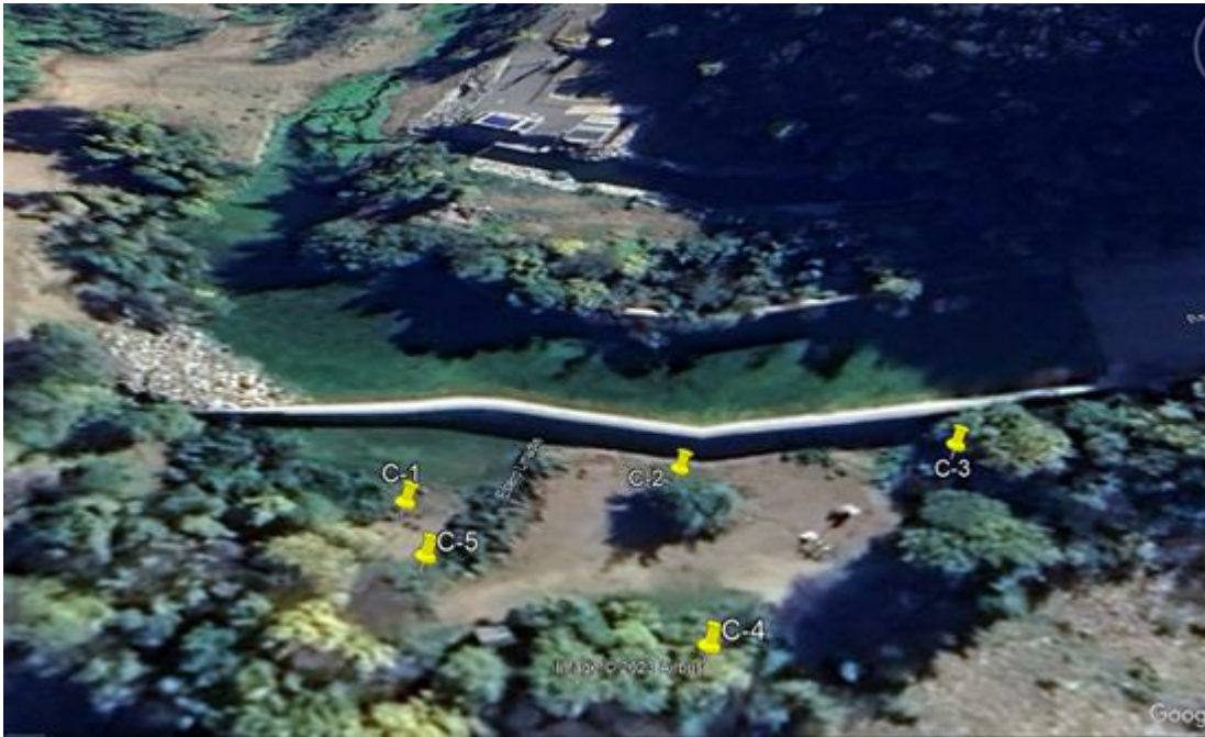
Figura 5.1 – Ubicación de calicatas
