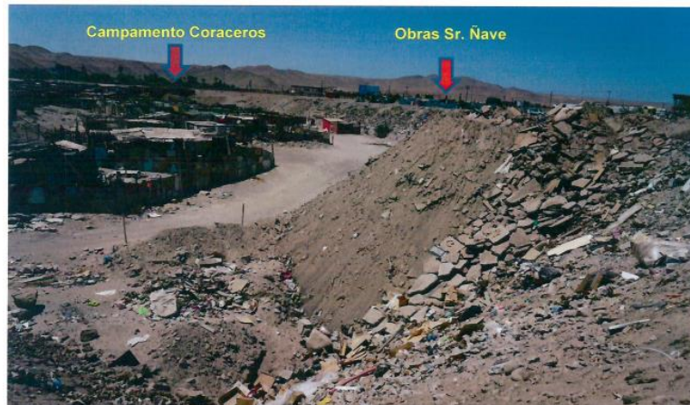
Figura 1-26. Vista actual de obras en cauce y sector habitado, registro del 01 de diciembre de 2017.
