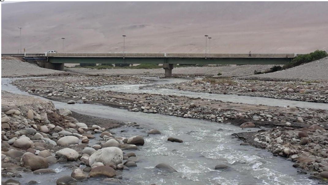
Figura 1-66. Procesos mecánico fluviales característicos en río Lluta. Puente Chacabuco.
