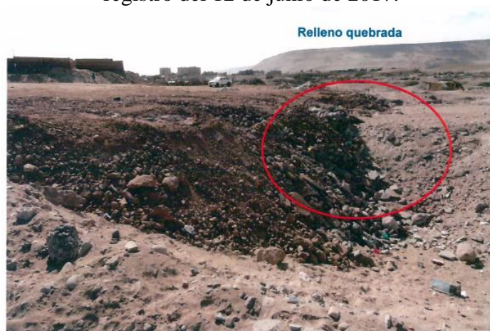
Figura 1-23. Acumulación y compactación de material no consolidado en parte baja de la quebrada, registro del 12 de junio de 2017.
