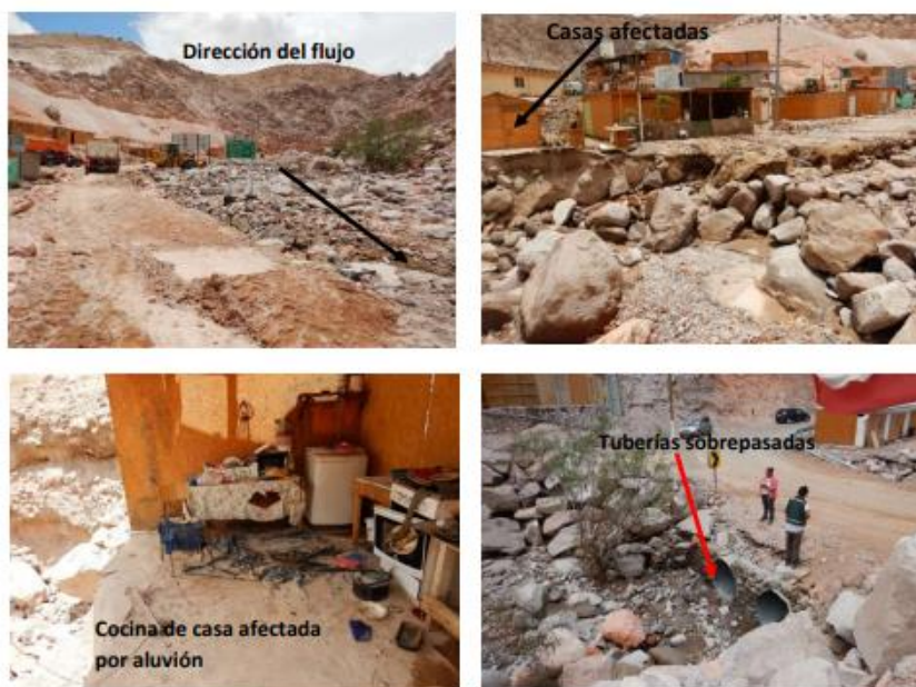
Figura 1-18. Daños en infraestructuras en la quebrada Escalera. La flecha roja muestra las tuberías que fueron sobrepasadas por el aluvión.
