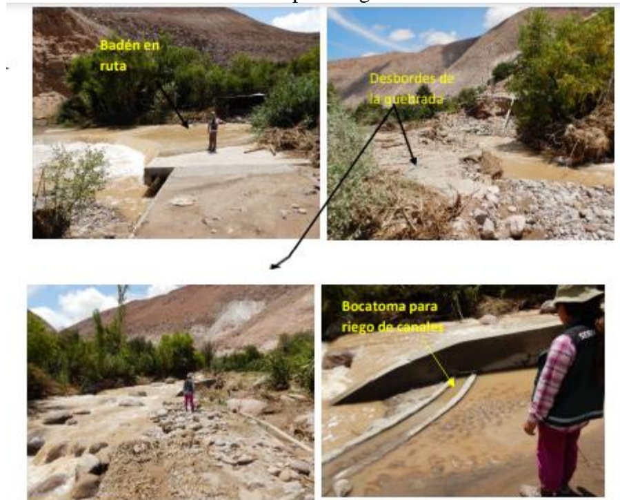
Figura 1-19. Desborde de quebrada Sibitaya, sector Guañacahua, la flecha amarilla indica el sector de la bocatoma para riego en la zona.
