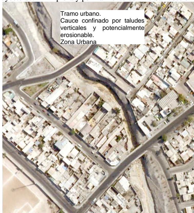
Figura 1-99. Proyecto SJ.A Limpieza y perfilamiento del Río San José en el tramo urbano.
