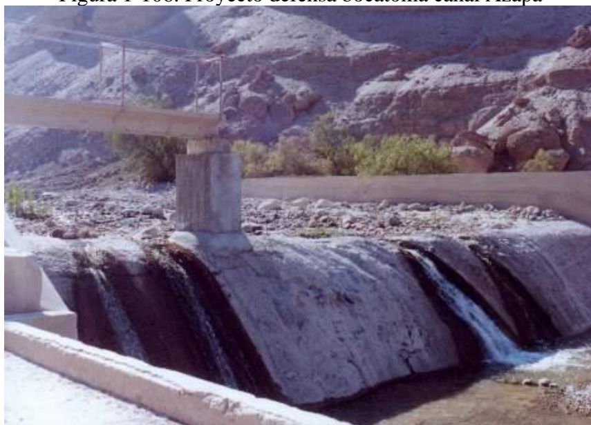
Figura 1-106. Proyecto defensa bocATOMA canal Azapa
