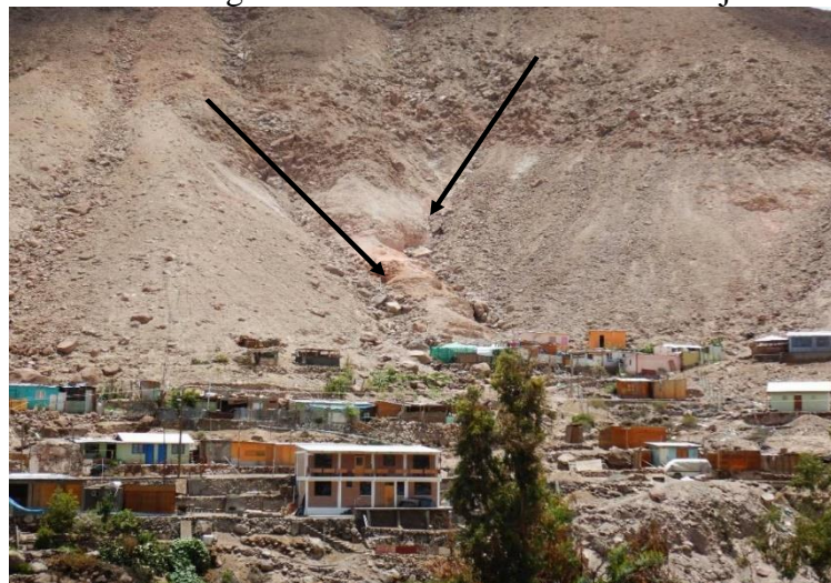
Figura 1-20. Casas en zonas de alcance por remociones en masa en el sector de Guañacahua, con flecha negra se indica la dirección del drenaje.
