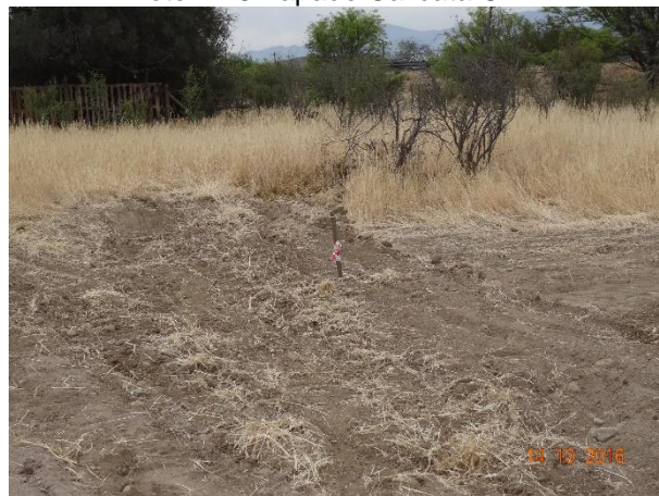
Foto N° 8 Tapado Calicata CA-2
