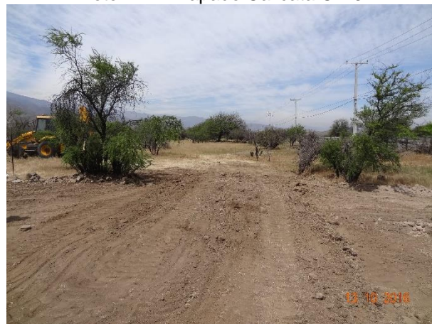
Foto N° 12 Tapado Calicata CA-3
