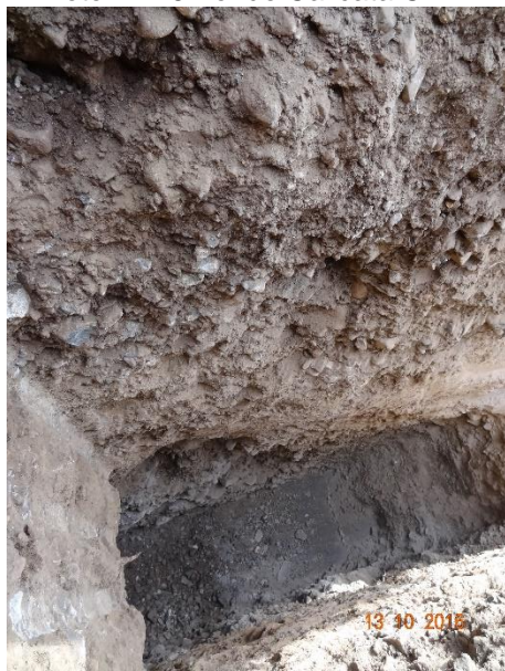
Foto N° 15 Fondo Calicata CA-4
