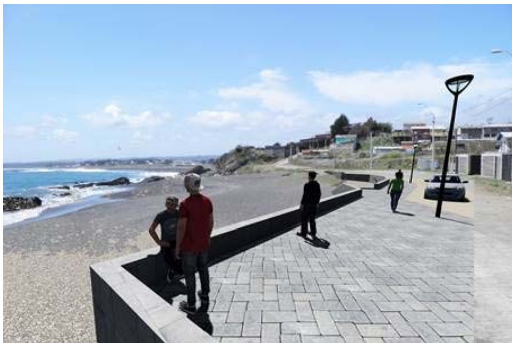
PELLUHUE TRAMO 3 VISTA HACIA EL NORTE
