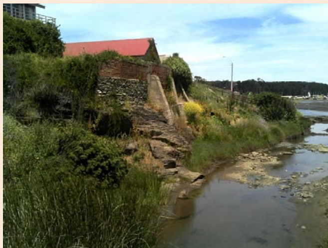
Fotografía 1. Afloramiento de roca sector pasarela peatonal – Riberas río Curanipe
