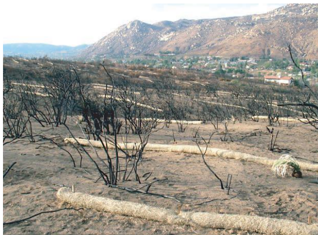
Figura N° 4-1 Straw wattles instalados para el control de erosión (Fuente: USDA)
