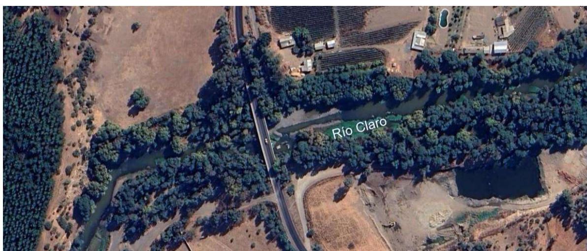
Imagen 4.1: detalle de ubicación del puente Maitenhuapi. Fuente Google Earth.
