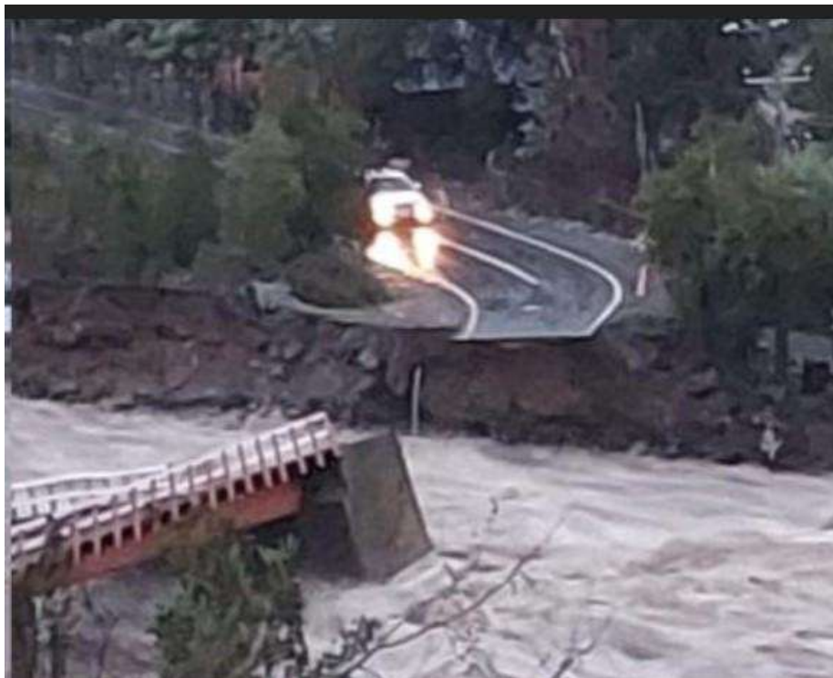
Imagen 4.6: Detalle del Puente Chupallar luego de las crecidas del año 2023. Fuente: adaptado de https://www.t13.cl/noticia/nacional/rio-ancoa-destruyo-puente-acceso-al-sector-chupallar-linares-senapred-solicita-24-6-2023
