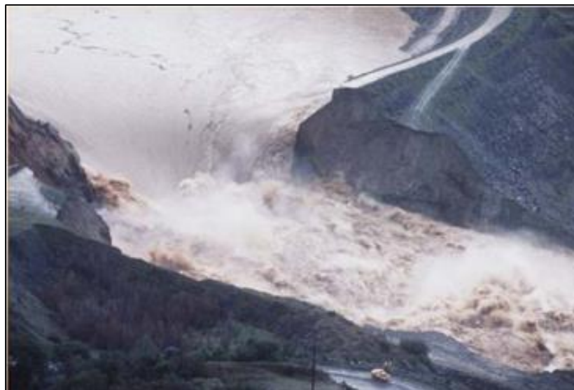
Figura 2.4 Falla por sobre-vertimiento, presa Auburn, California (USBR, 2012).
