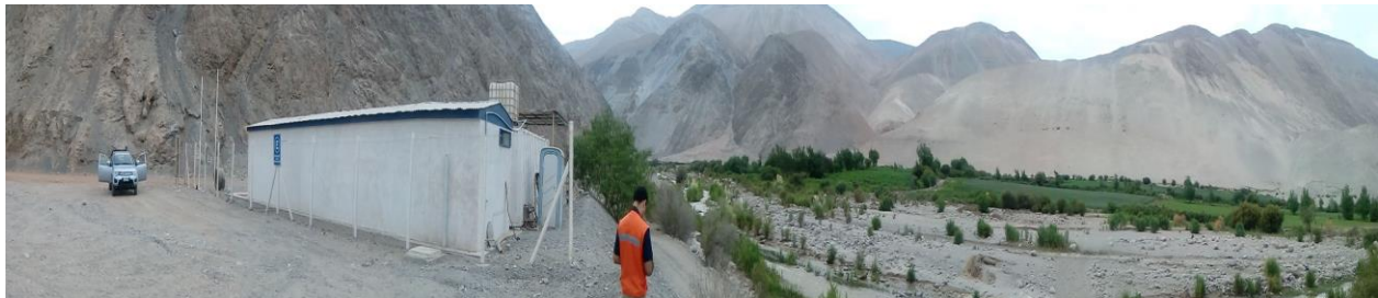
Figura 3.8 Acceso instalaciones mina Belén localidad de Taltape.
