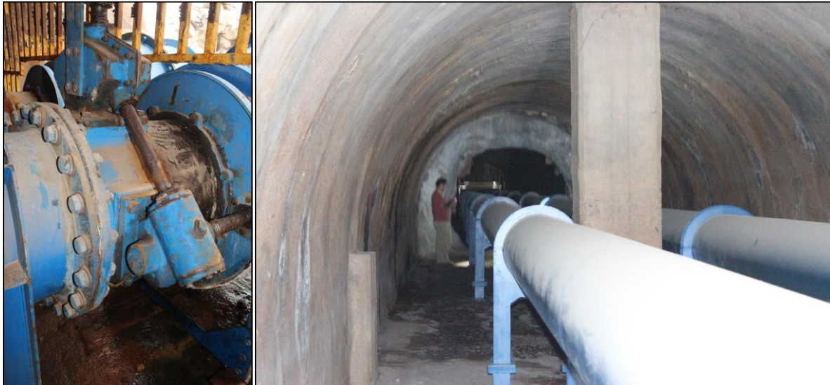
Figura 3.5 Estado de obras de entrega y regulación.
