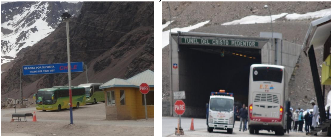
Ilustración 11: Aduana y Túnel del Cristo Redentor
