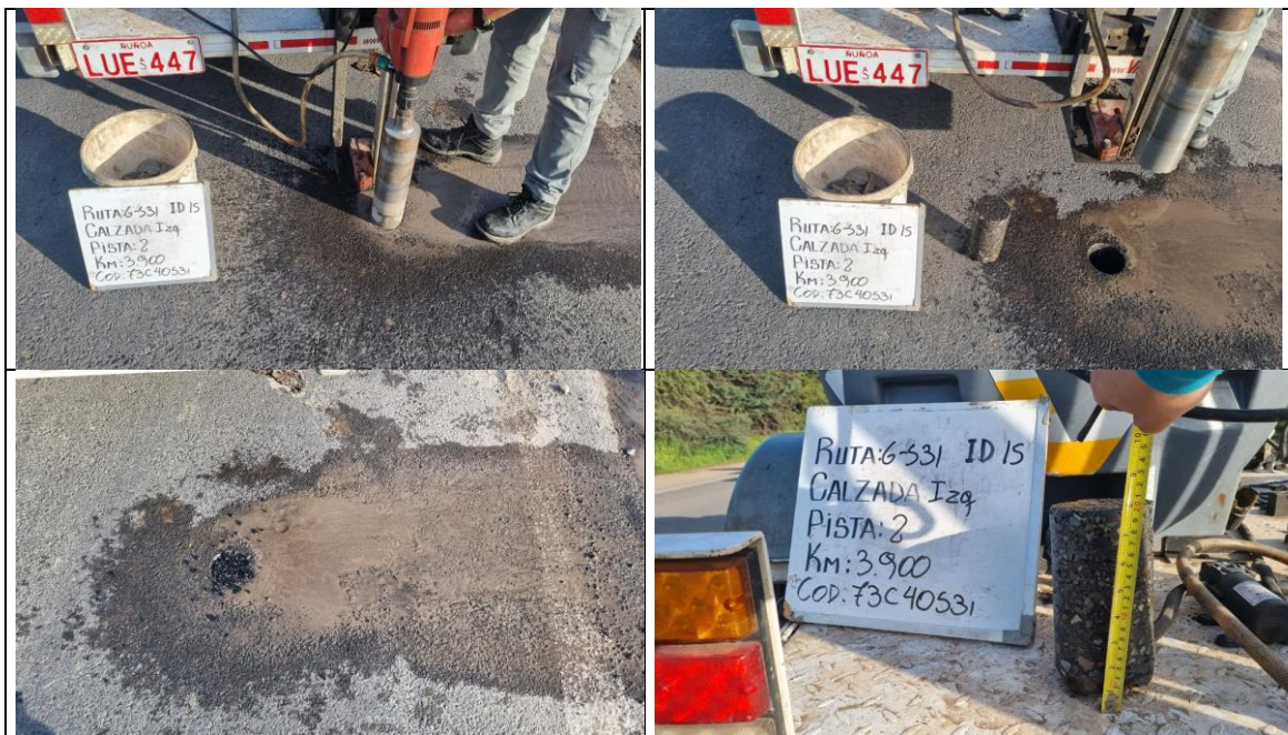
Figura 7-2: Proceso de extracción de Testigos – Ruta G-531
