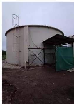
Figura 8-24: Sedimentador
