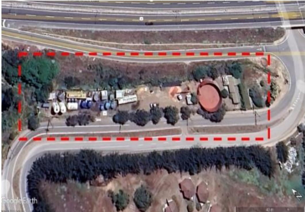
Figura 5-2: Planta potabilizadora Molles
