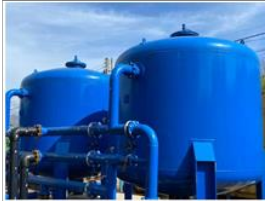
Figura 8-12: Filtros Greensand
