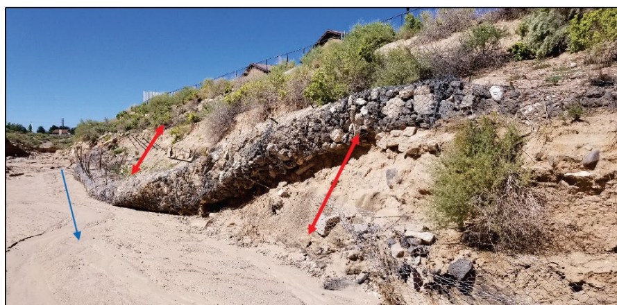
Figura C8. 28. Se observa la socavación de la orilla del cauce por debajo del pie de la canasta de gaviones. Fuente: Harring et al. 2023. Sustainable Bank and Channel Stabilization Techniques in Arid Southwest Streams. Wetlands Regulatory Assistance Program
