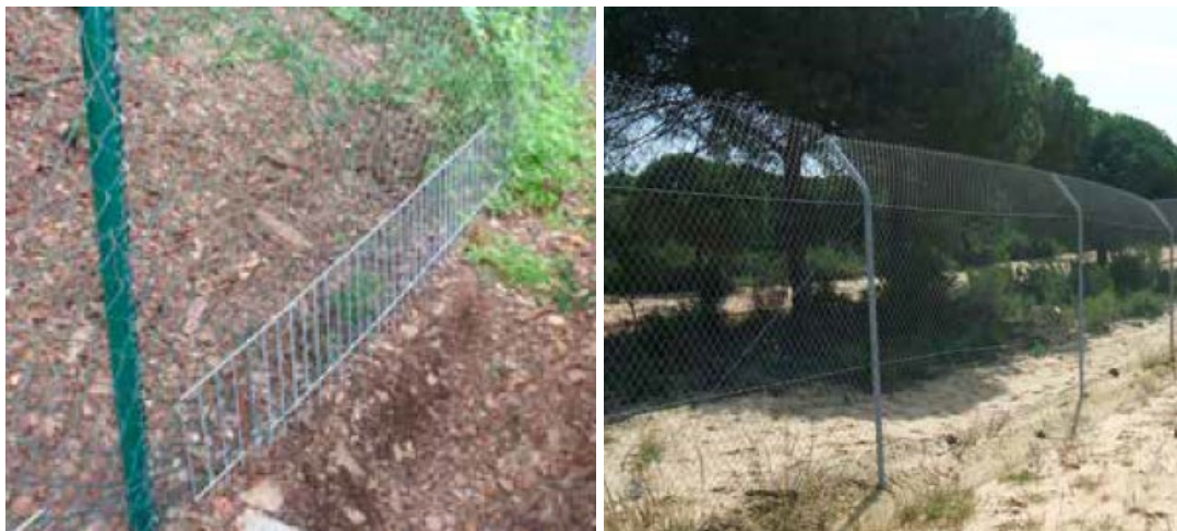
Figura C8. 58. Referencia real de enrejado perimetral con adaptaciones para jabalí, evitando que su actividad de excavación modifique la permeabilidad del enrejado (izquierda); referencia real de enrejado perimetral con adaptaciones para lince ibérico, evitando que al escalar o saltar pueda sortear dicho enrejado (izquierda). Fuente: Ministerio de Agricultura, Alimentación y Medio Ambiente – España (2015).
