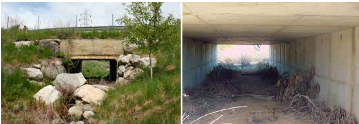
Figura C8. 55. Referencia real pasos bajo nivel para pequeños vertebrados con incorporación de rocas como elementos naturalizantes (izquierda) y ramas secas para facilitar refugio a animales de pequeño tamaño (derecha). Fuente: Ministerio de Agricultura, Alimentación y Medio Ambiente – España (2015).
