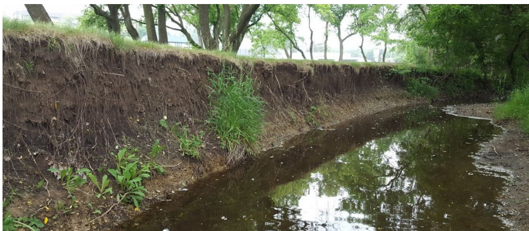
Figura C8. 25. Riberas desprotegidas debido a una estabilización inadecuada. Fuente: https://www.ruekertmielke.com/blog/2018/6/26/how-to-protect-urban-stream-and-river-banks .
