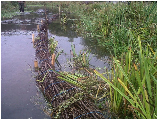
Figura C8. 43. Aplicación de paquetes de rastrojo afirmados con estacas de madera. Fuente: https://www.wildtrout.org/content/upper-itchen
