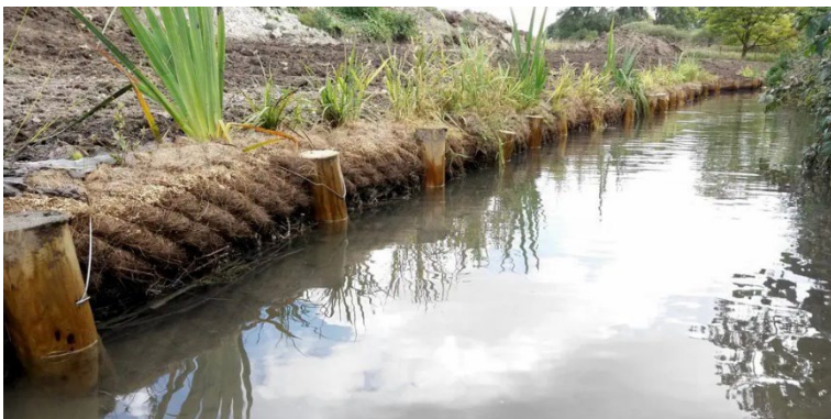
Figura C8. 42. Combinación de rollos de fibra de coco con vegetación, sujetos por estacas de madera: Fuente: https://terraqua.co.uk/lakes-and-ponds/erosion-control/
