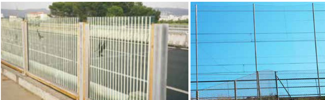
Figura C8. 61. Referencia real de enrejado perimetral pintado de color amarillo contrastante (izquierda) y Cerramiento anticolidión para murciélagos de 5 m de altura y malla de simple torsión en una línea de alta velocidad (derecha). Fuente: Ministerio de Agricultura, Alimentación y Medio Ambiente – España (2015).
