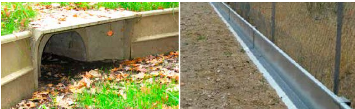
Figura C8. 56. Referencia real de un paso bajo nivel para anfibios (izquierda); referencia real de estructura opaca de metal que cumple rol de cerramiento perimetral y guía a los anfibios hacia el paso bajo nivel (derecha). Fuente: Ministerio de Agricultura, Alimentación y Medio Ambiente – España (2015).
