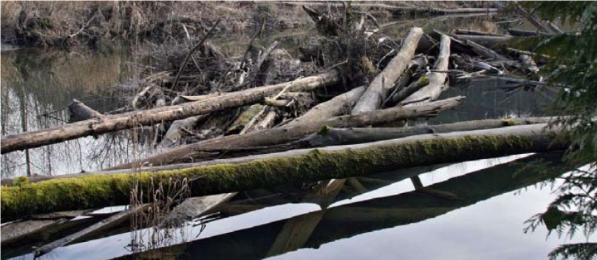
Figura C8. 47. Introducción de troncos, ramas y raíces al interior del lecho del río. Fuente: FEMA, https://www.fema.gov/pdf/about/regions/regionx/Engineering_With_Nature_Web.pdf
