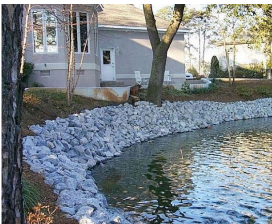
Figura C8. 44. Enrocado conservando árboles principales, sin agregar vegetación adicional. Fuente: https://www.fema.gov/pdf/about/regions/regionx/Engineering_With_Nature_Web.pdf
