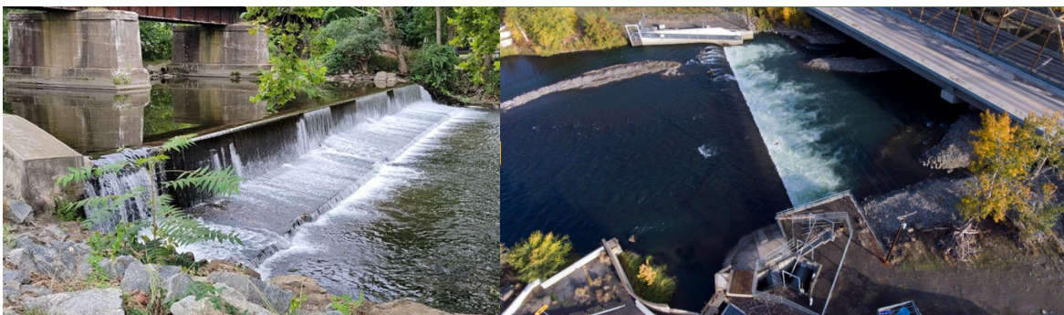
Figura C8. 29. Ejemplos de barreras transversales que interrumpen la conectividad longitudinal (a lo largo del cauce). Se sugiere evitar en la etapa de diseño del proyecto. A la izquierda una barrera generada por una represa y a la derecha la barrera la constituye la alcantarilla desconectada del lecho fluvial. Fuente: Derecha – https://www.nature.org/ ; Izquierda - https://hewlett.org/openriversfund/
