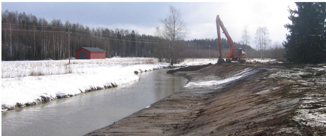
Figura C8. 24. Compactación del lecho, remoción de piedras y bolones, emparejamiento de orillas. Fuente: https://www.ecrr.org/River-Restoration/Why-restore-rivers
