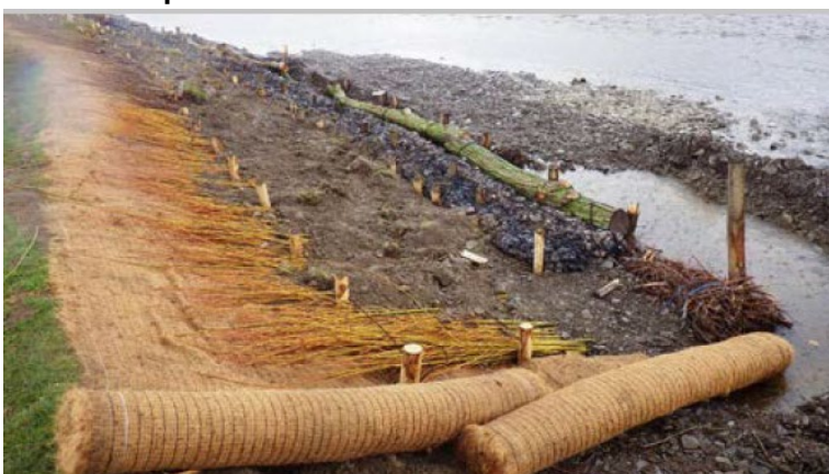
Figura C8. 41. Combinación de colchones de fibra de coco, estacas y paquetes de rastrojo. Fuente: Frisch & Severi. "Manual of River Restoration Techniques."
