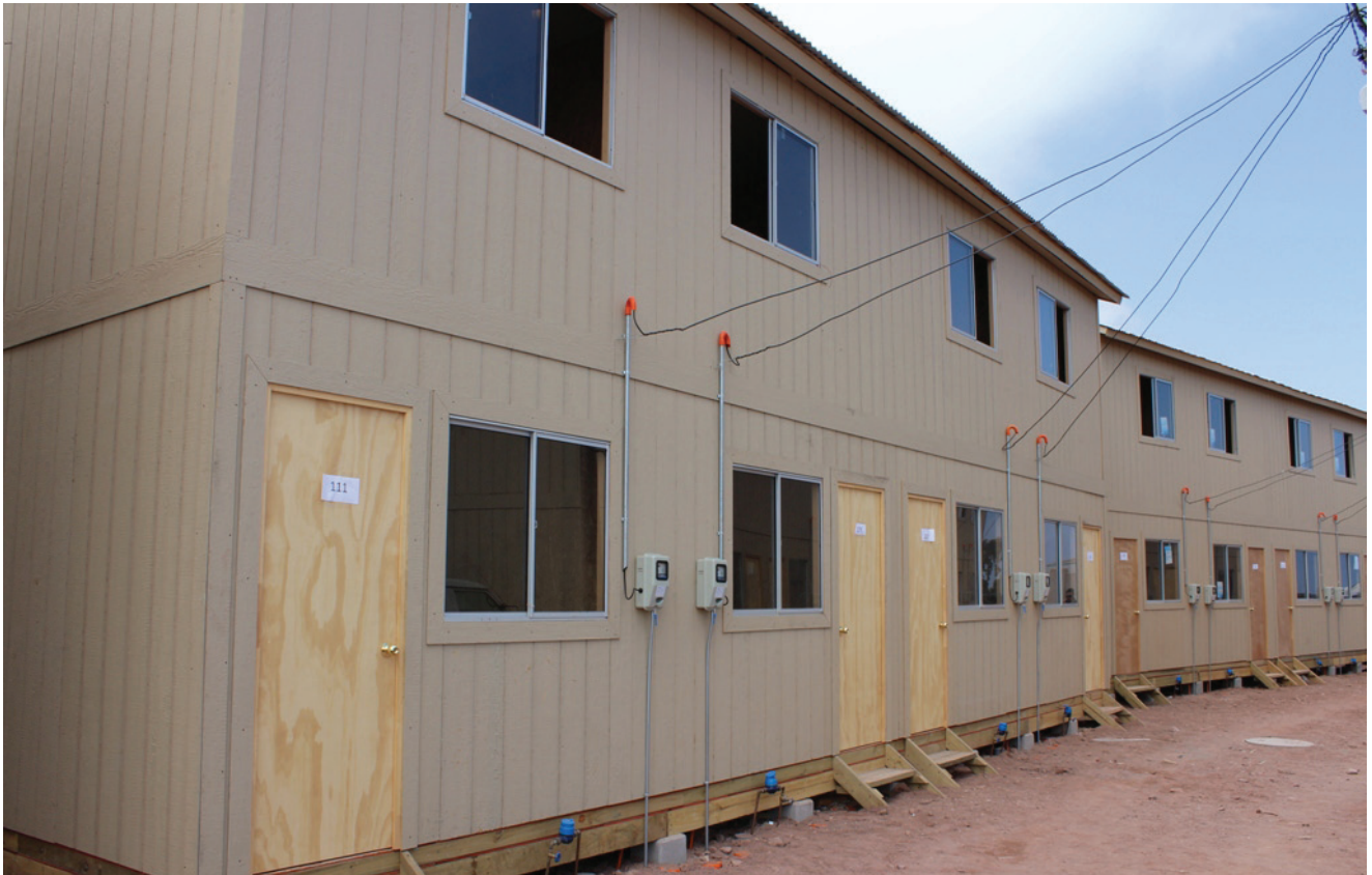
Imagen: Vivienda Emergencia donadas por Minera Collahuasi. Terremoto Iquique Abril 2014
