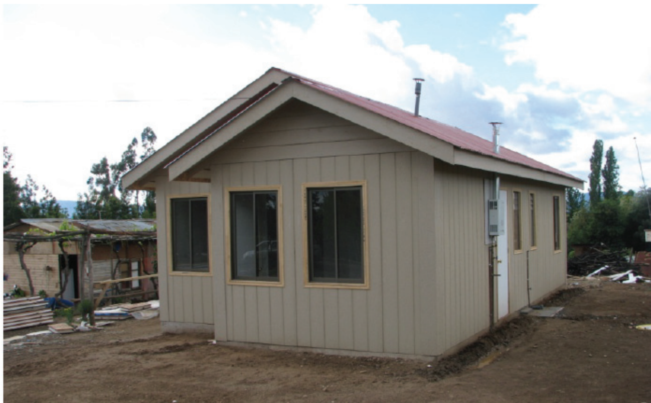
Imagen: Vivienda Emergencia, Estudio CIGIDEN
