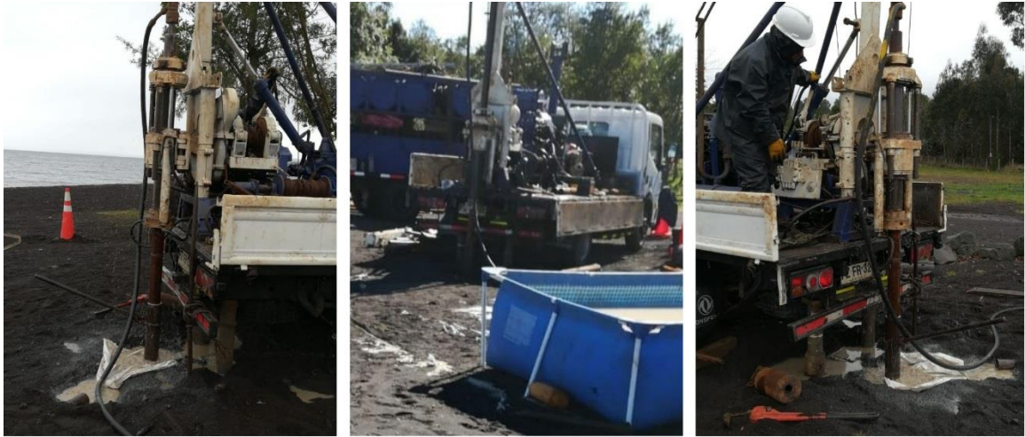
Figura 4-8 Fotografías Sondaje ST-1
