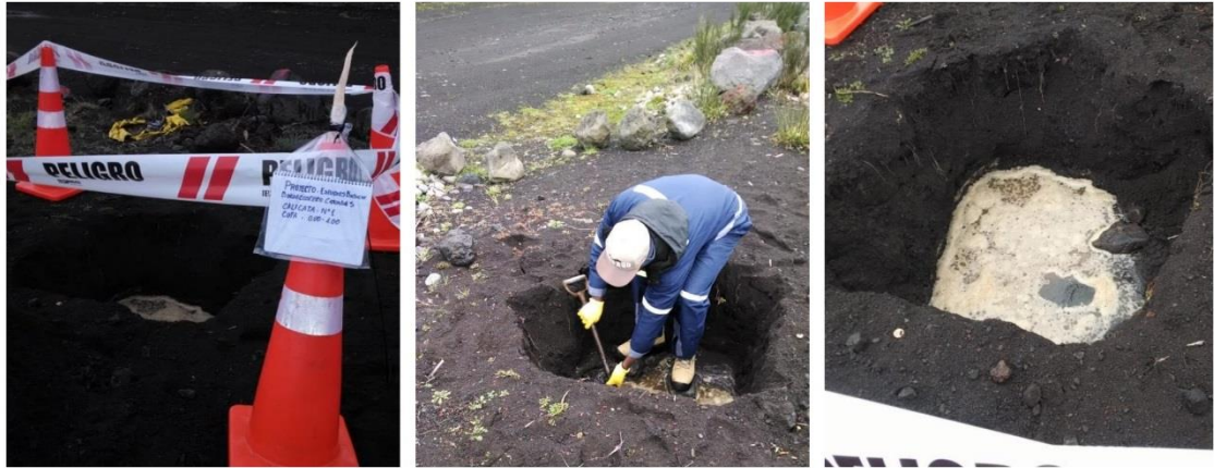
Figura 4-3 Fotografías Calicata C-2
