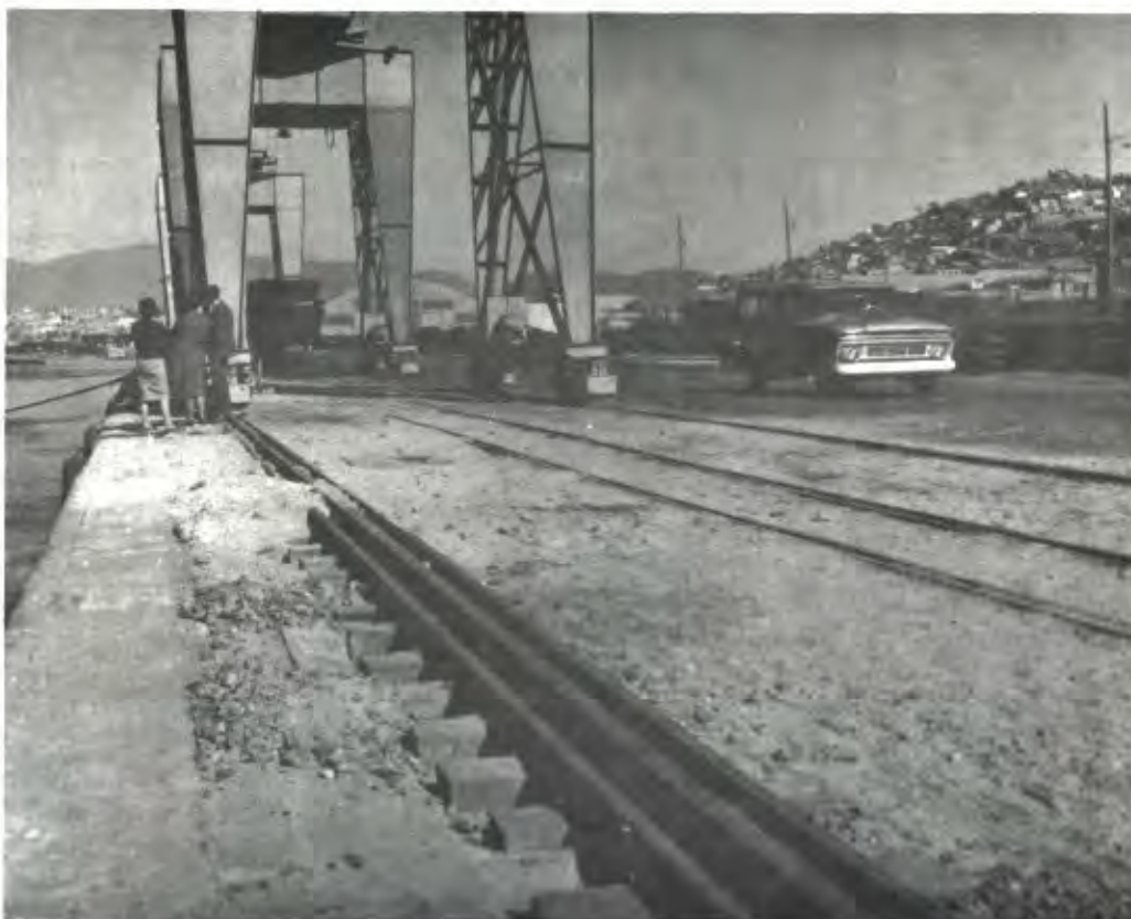
Explanada del Puerto de Coquimbo
