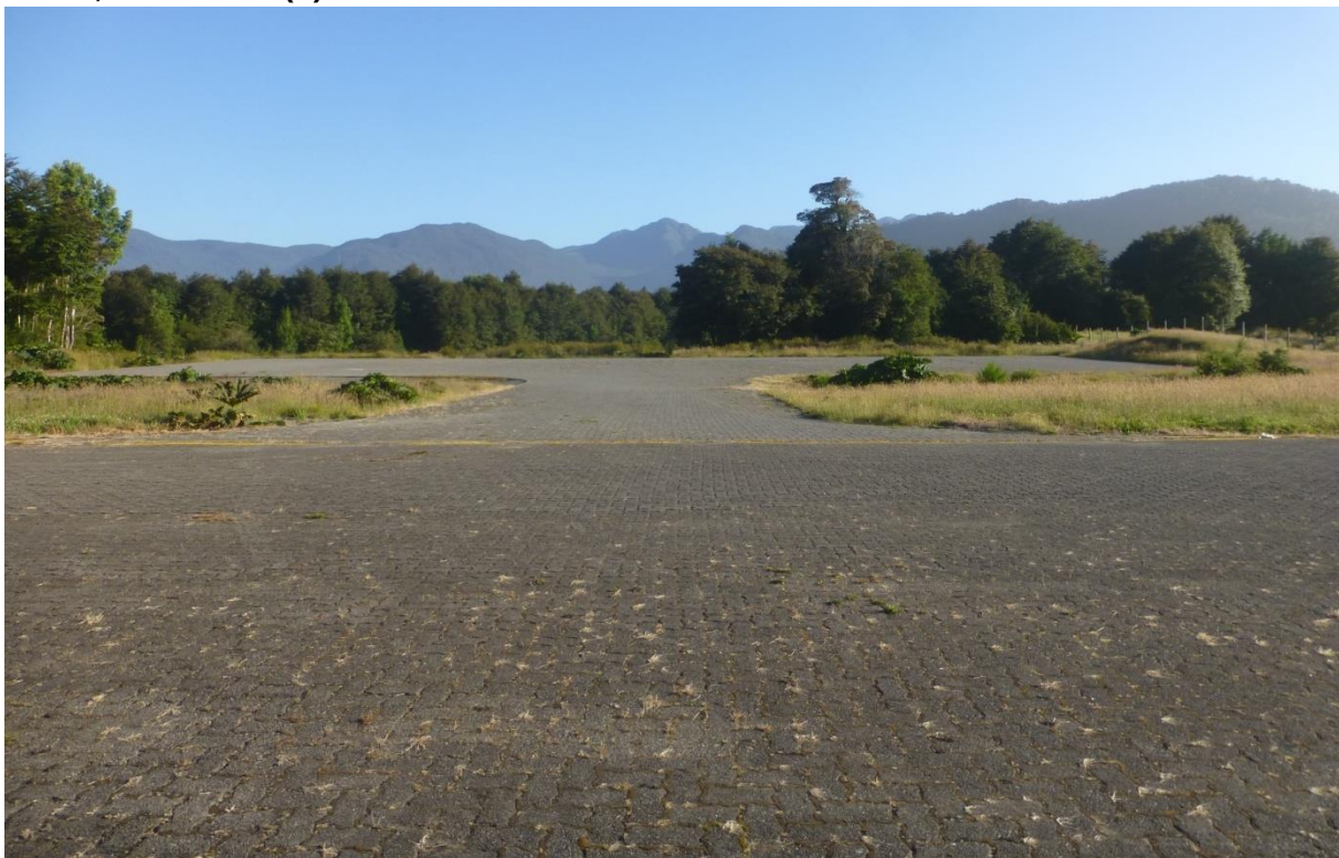
Figura 5.2-H. Vista de plataforma de estacionamiento, y calle de rodaje de acceso a pista de vuelos, hacia el Sur (S). Aeródromo Puerto Marín Balmaceda
