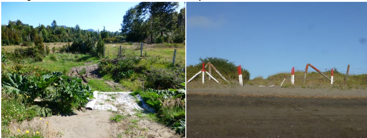
Figura 5.4-A. Vista de discontinuidades cerco perimetral. AD. Puerto Marín Balmaceda
