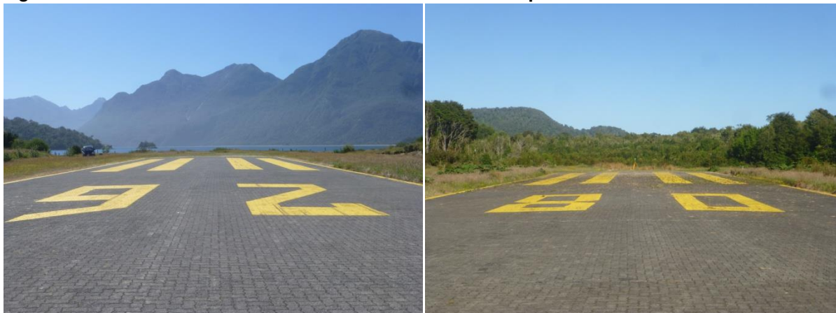
Figura 5.3-B. Vista de señalización horizontal de umbral de pista. AD Puerto Marín Balmaceda
