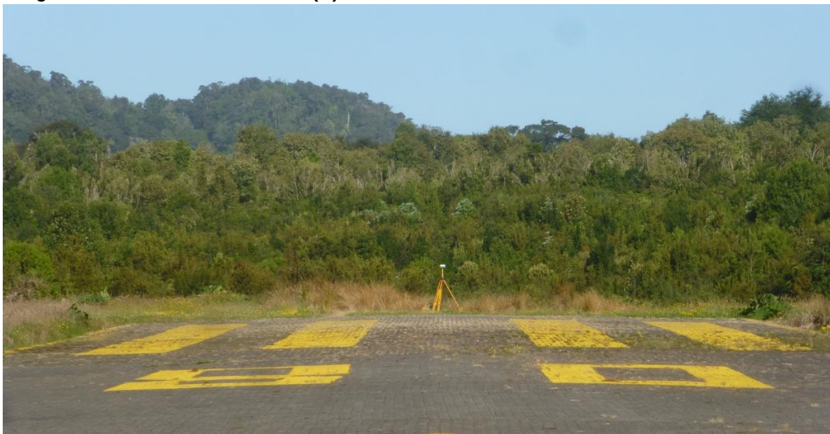
Figura 5.4-B. Vista hacia el Oeste (O) desde umbral 08. Aeródromo Puerto Marín Balmaceda
