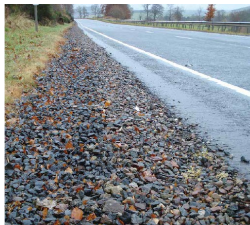
Zanja de infiltración. The SuDS Manual (Ciria, 2015)
