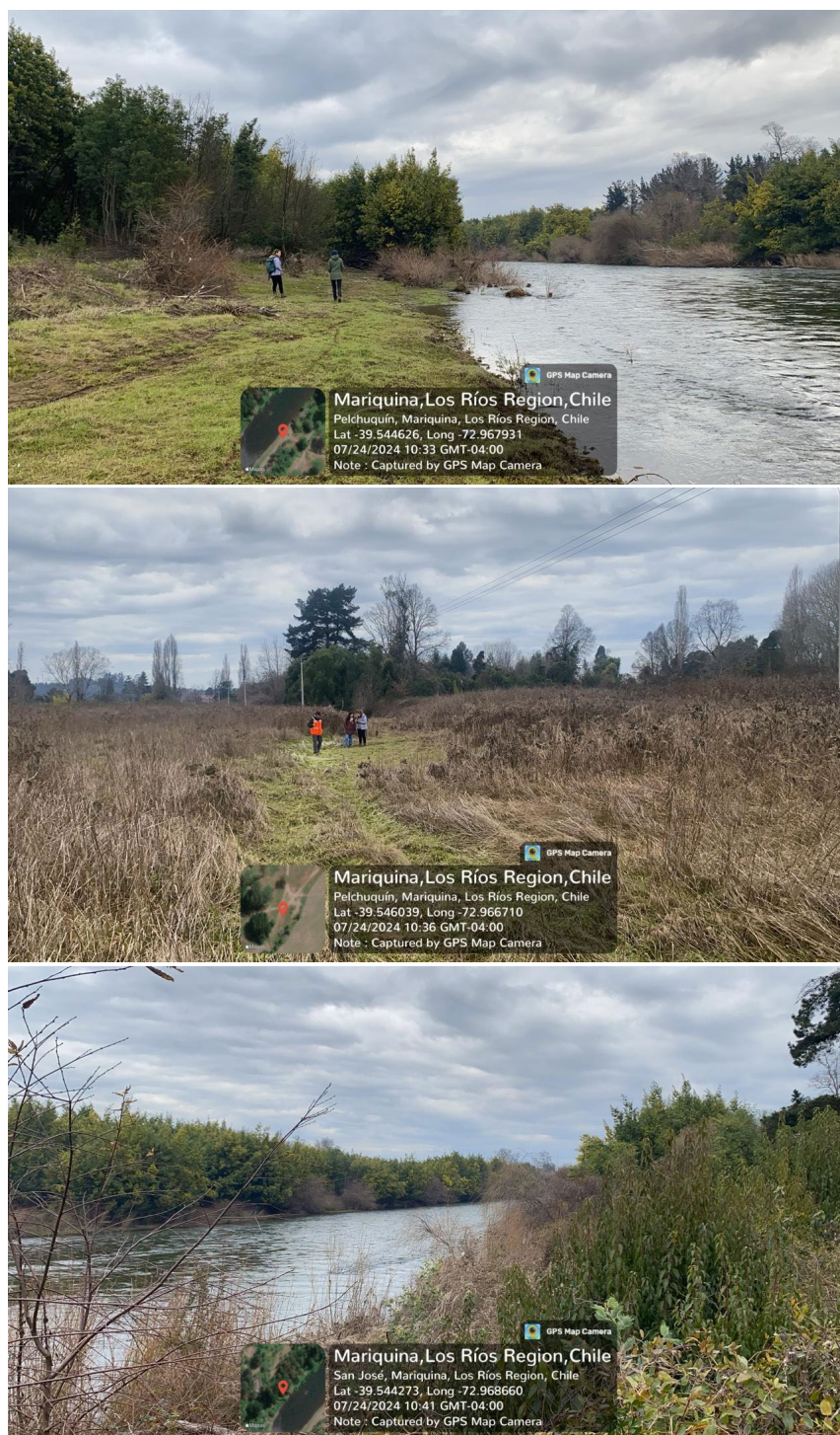
Figura 3. Referencias fotográficas del sitio de obra del puente segundo acceso a San José de la Mariquina, en el Río Cruces en la ribera sur (arriba), un área de la ribera sur que presenta indicios de inundación reciente (centro) y de la ribera norte (abajo).
