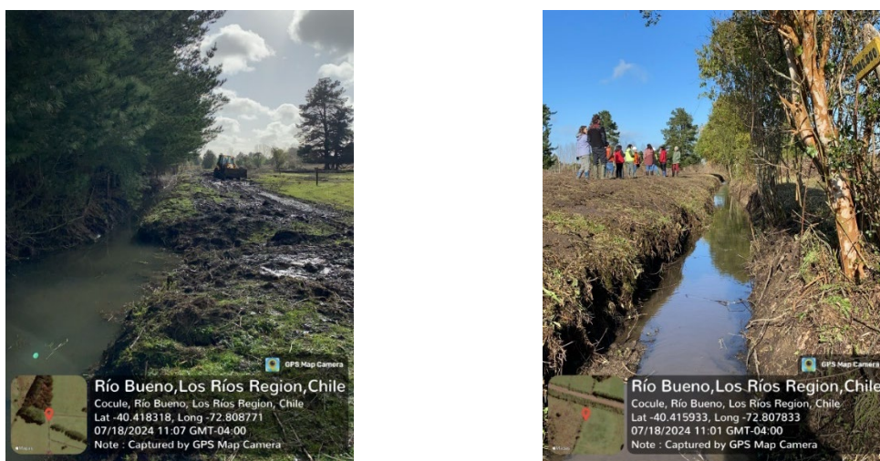
Figura C7. 14. La Imagen de la izquierda muestra el trabajo con maquinaria en aquellos sectores en que no fue posible realizar la limpieza de manera manual. Fuente: Elaboración propia.
