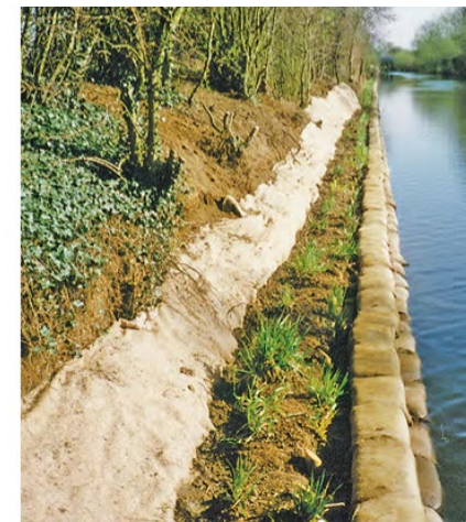
Uso de rollos de fibra y plantación de especies hidrófilas. Fuente: Manual of River Restoration Techniques. The River Restoration Center (2020).
