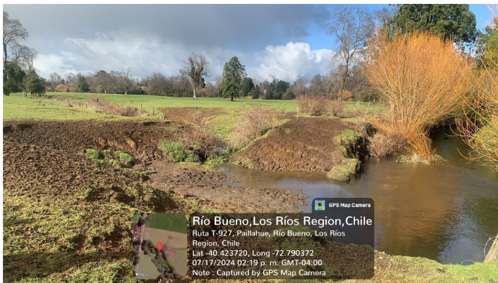
Figura C7. 15. Fotografías en sector de enrocado proyectado en la confluencia de Estero Sin Nombre 1 y Río Currileufú. Fuente: Elaboración propia.
