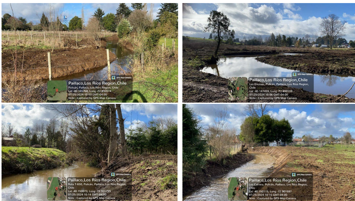
Figura C7. 30. Imágenes visita a terreno que muestran el avance de los trabajos de limpieza de cauce con roce y limpieza de cauce y perfilado con maquinaria en Estero Percán. Fuente: Elaboración propia.
