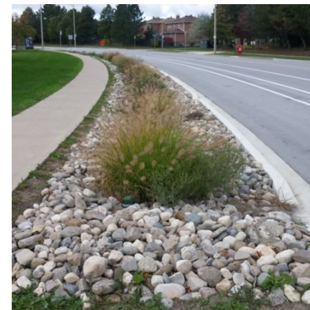
Solera discontinua. Fuente: wiki.sustainabletechnologies.ca/wiki/Swales
