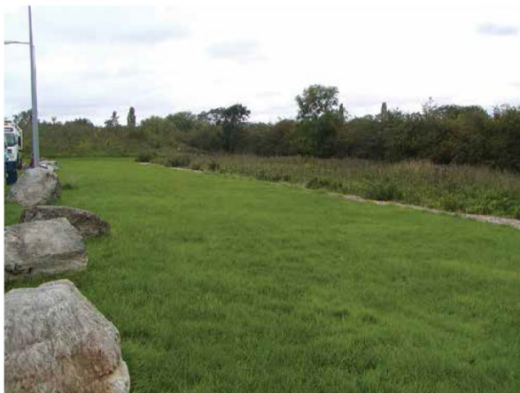
Franja Filtrante. Fuente: The SuDS Manual (Ciria, 2015)
