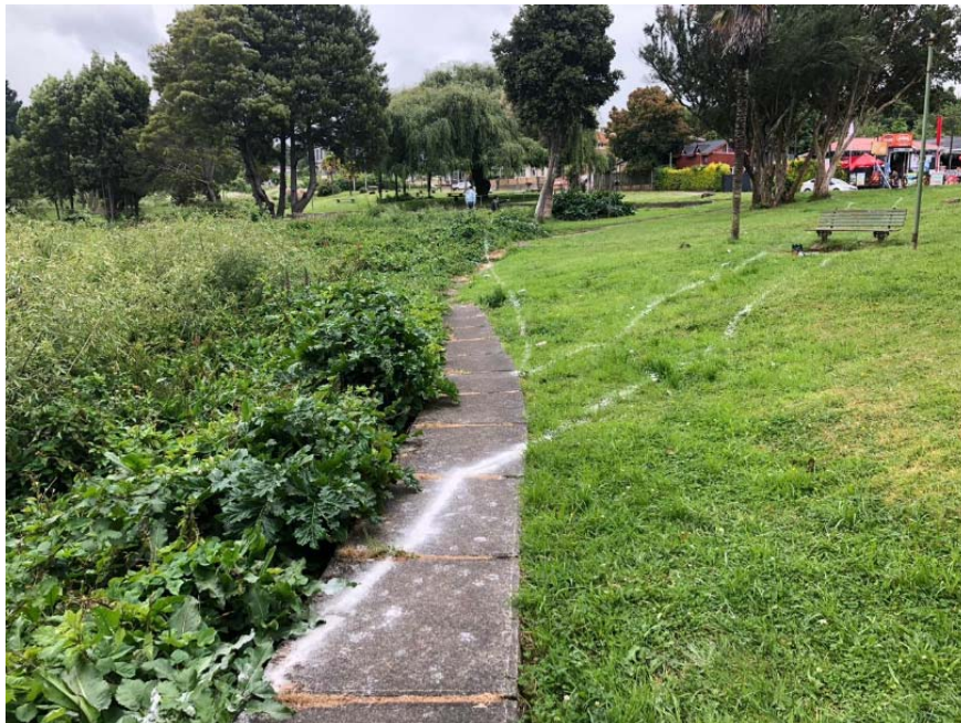
Sector nuevo muro de gaviones
