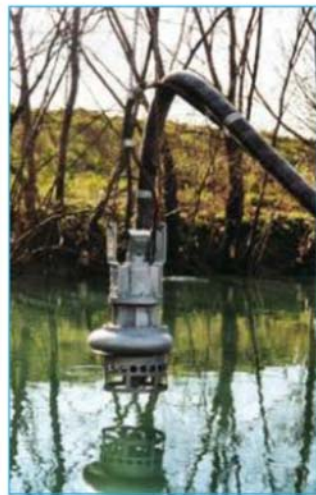
HY85A: operación de dragado de canales (Italia).
