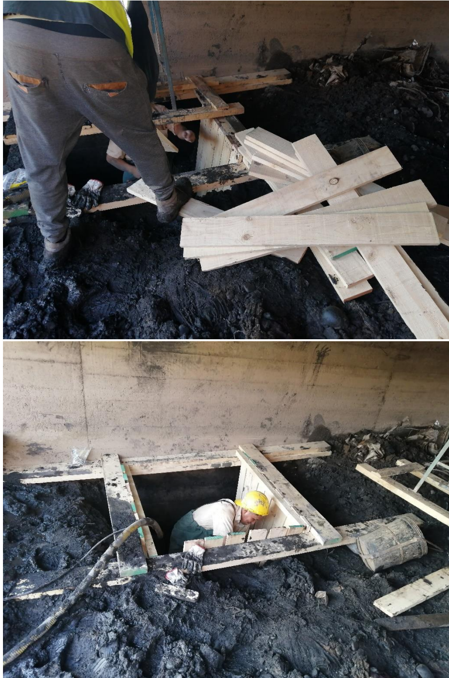
Figura 10: Construcción y disposición de entibaciones
