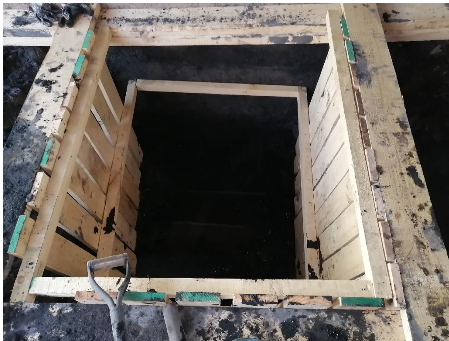
Figura 11: Entibación instalada
