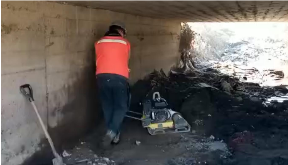
Figura 22: Compactación mecánica
