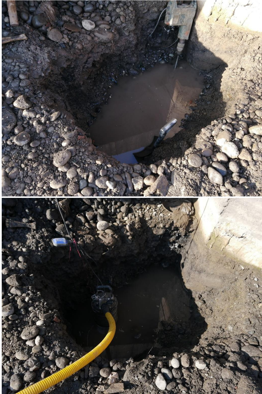
Figura 4: Agotamiento de Excavación
