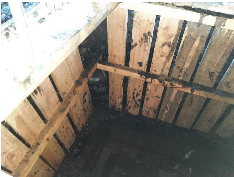
Figura 16: Pozo exploración
