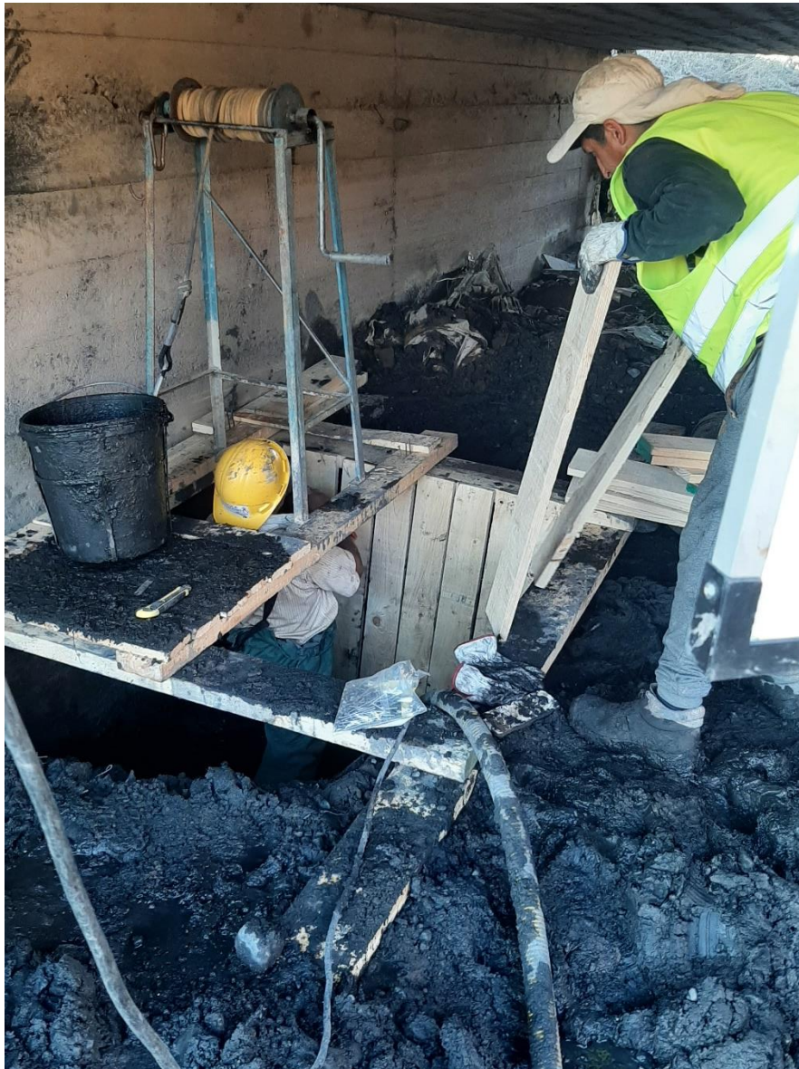
Figura 9: Polea para extracción de material
