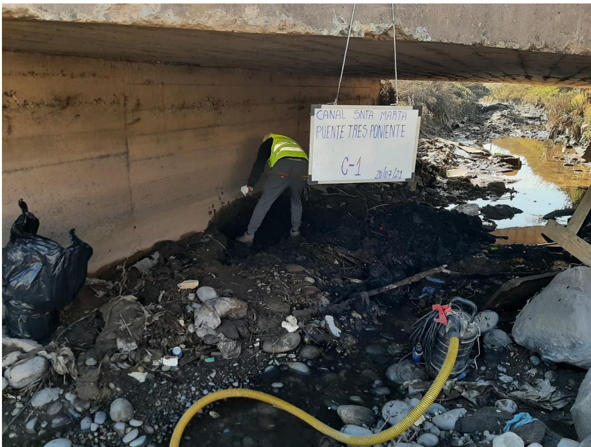
Figura 7: Inicio Trabajo Puesto Tres Poniente
