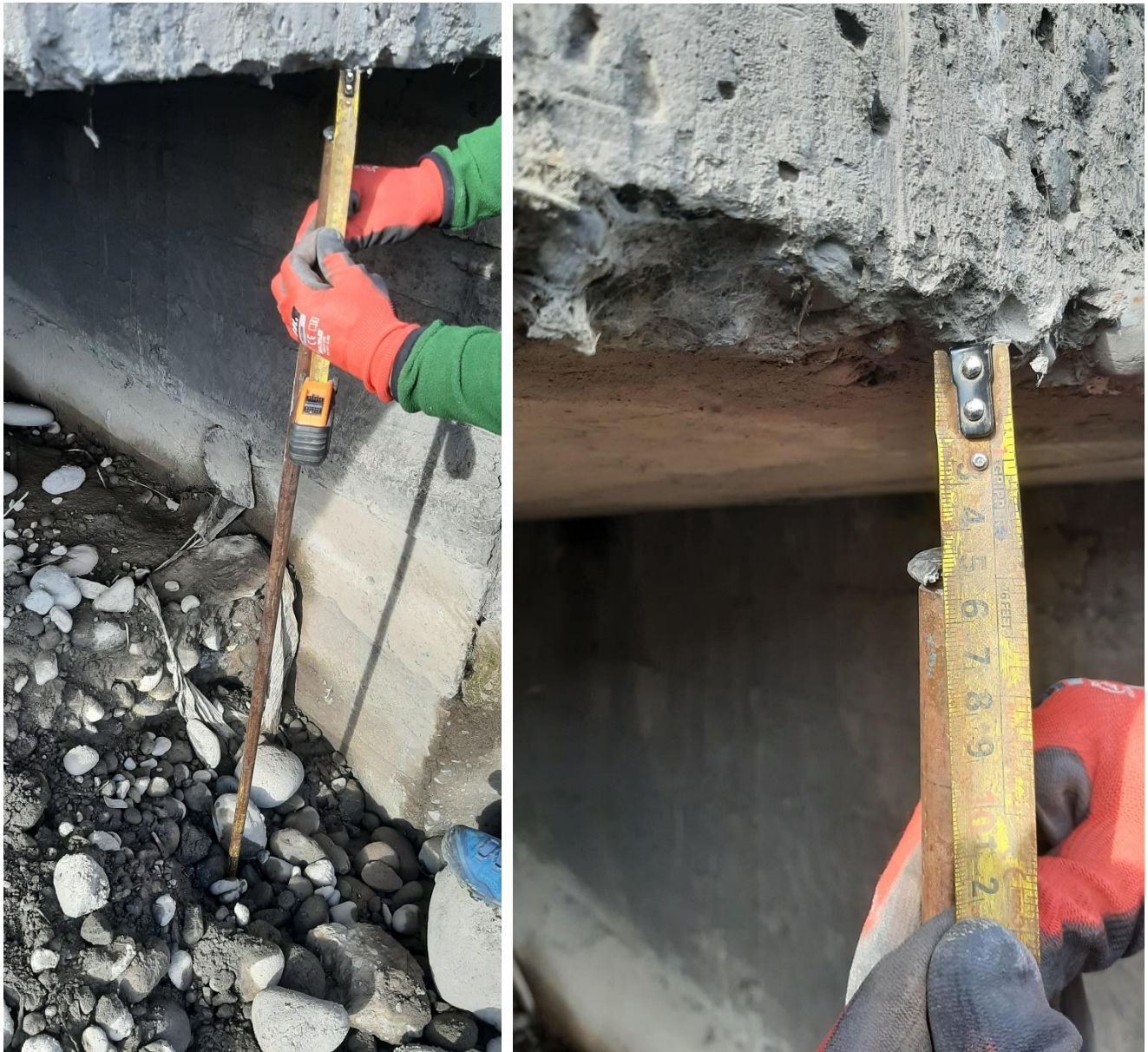
Figura 5: Varillaje Camino a Melipilla
