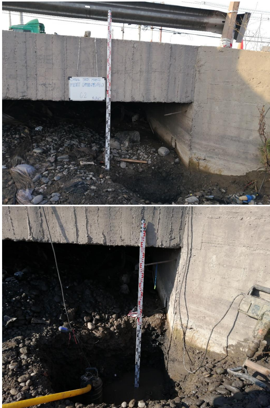
Figura 3: Profundidad Excavación Camino a Melipilla
