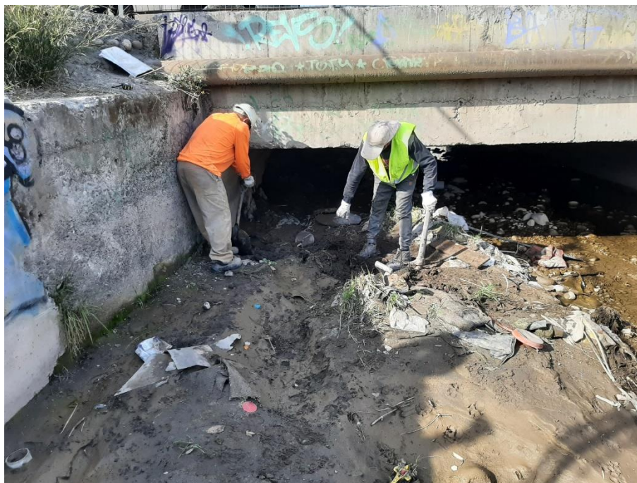
Figura 24: Retiro de escombros
