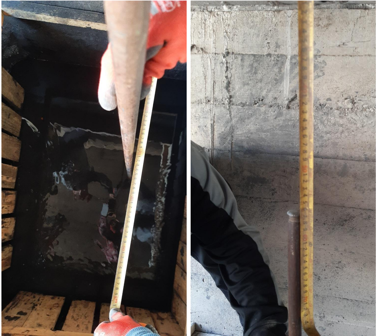
Figura 20: Varillaje Puente Tres Poniente punto n°2
