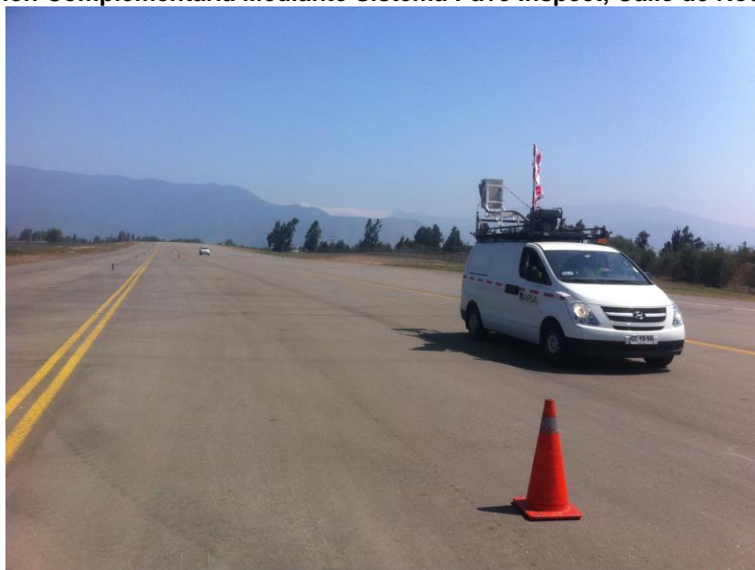
Figura N° 3-4 Auscultación Complementaria Mediante Sistema Pave Inspect, Calle de Rodaje Tango.
