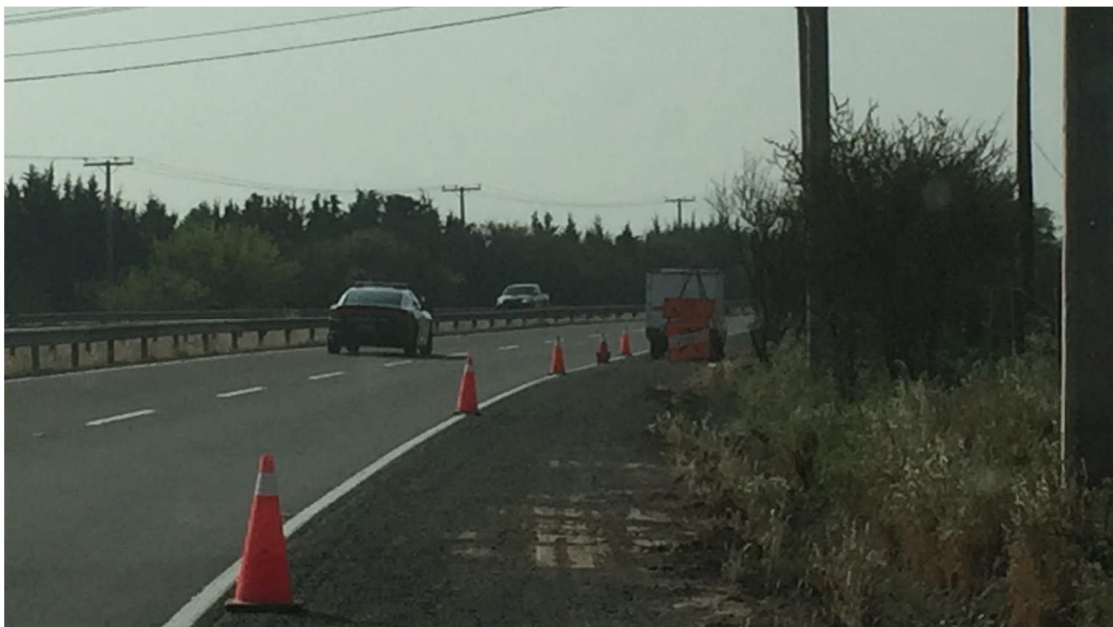
Figura 5.6 Señalética de seguridad para intervención en Ruta 57 CH
