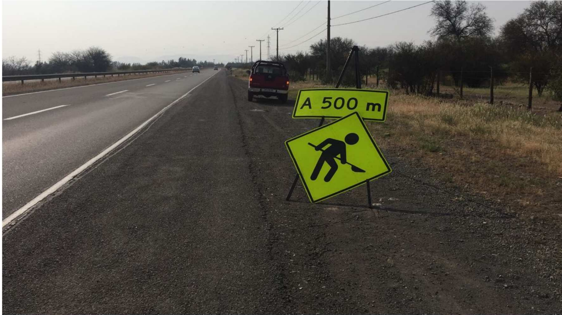
Figura 5.3 Señalética de seguridad para intervención en Ruta 57 CH
