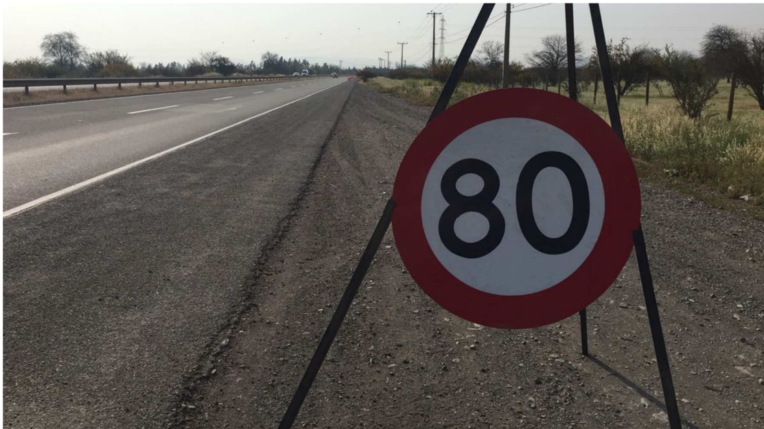
Figura 5.4 Señalética de seguridad para intervención en Ruta 57 CH
