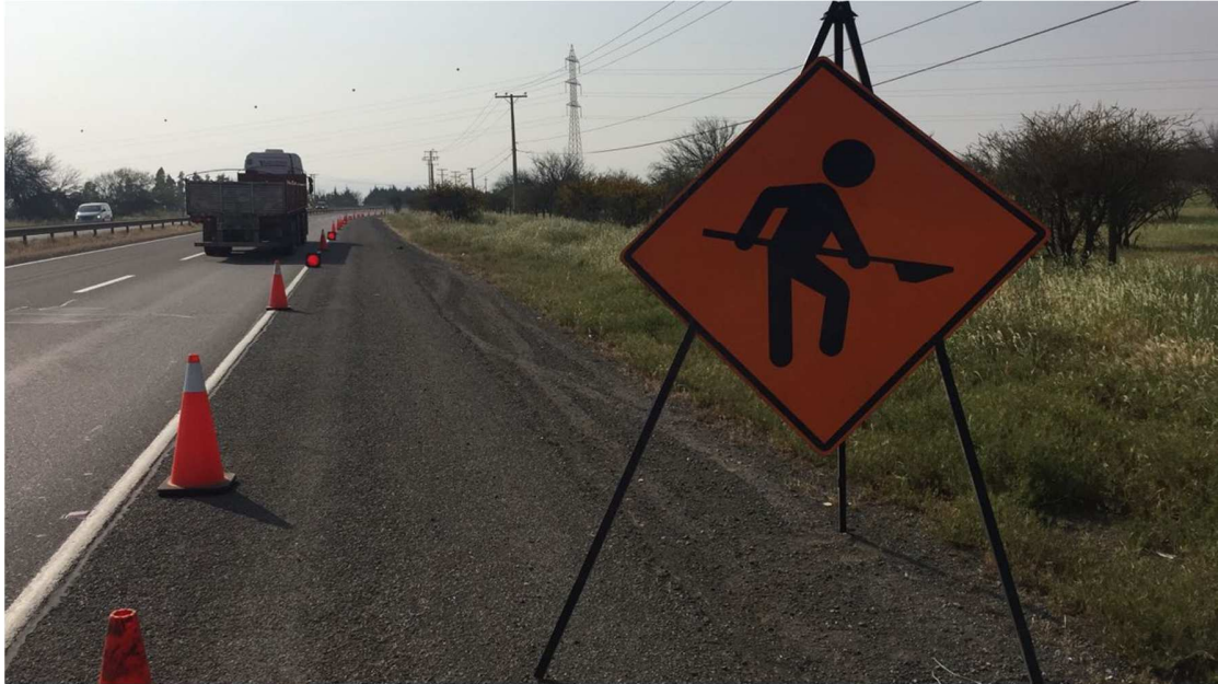
Figura 5.5 Señalética de seguridad para intervención en Ruta 57 CH
