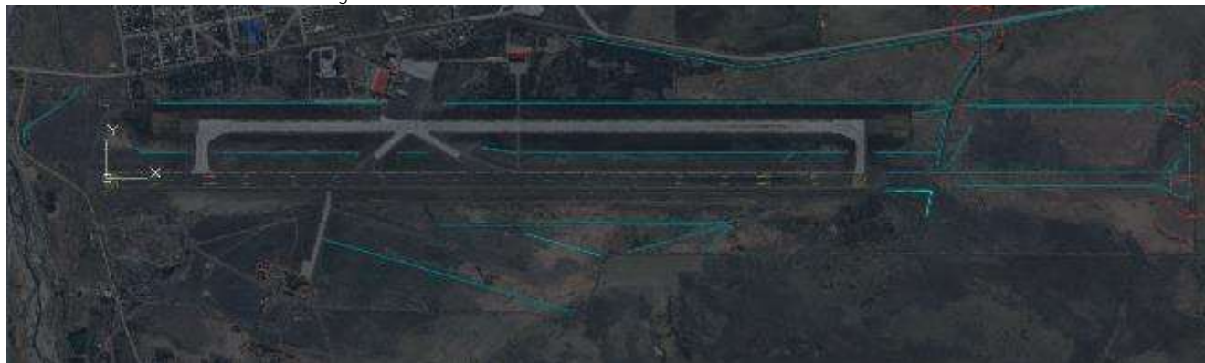
Figura 4.45: Desembocadura de drenes de aeródromo Balmaceda.
