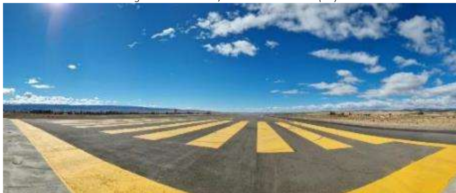
Figura 3.8: Pista 09/27 – Vista Poniente (09)
