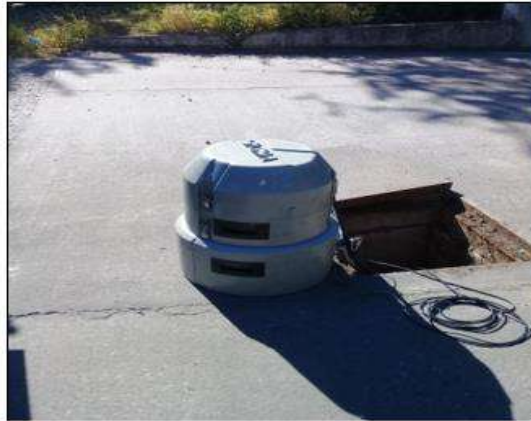
Fotografía 1: Instalación Equipo Automático
