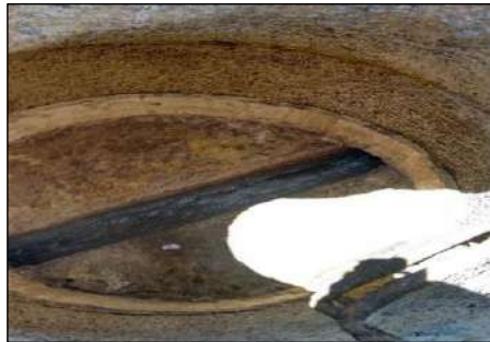
Fotografía 2: Punto de Monitoreo
