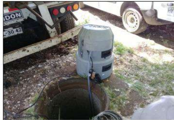
Fotografía 1: Instalación Equipo Automático
