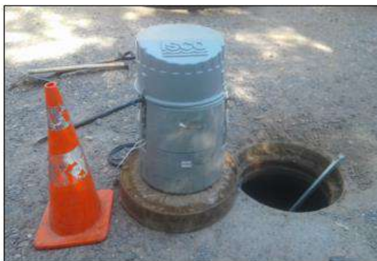
Fotografía 1: Instalación Equipo Automático
