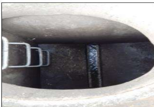
Fotografía 1: Instalación Equipo Automático
