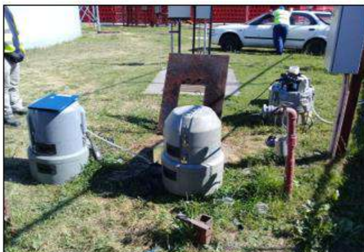
Fotografía 1: Instalación Equipo Automático
