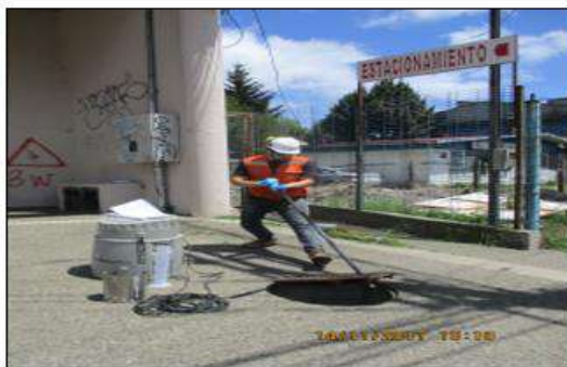
Fotografía 1: Instalación Equipo Automático
