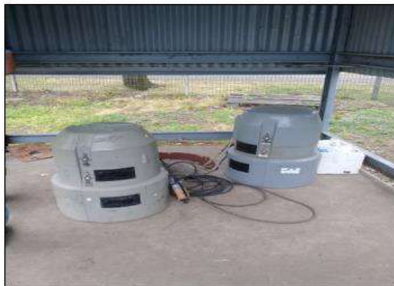
Fotografía 1: Instalación Equipo Automático
