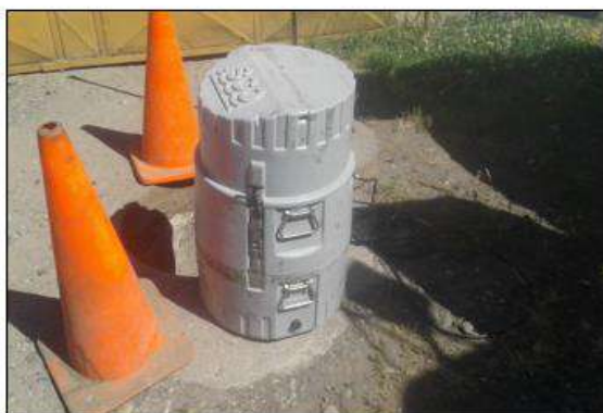
Fotografía 1: Instalación Equipo Automático
