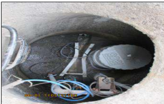
Fotografía 1: Instalación Equipo Automático
