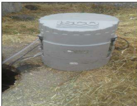
Fotografía 1: Instalación Equipo Automático
