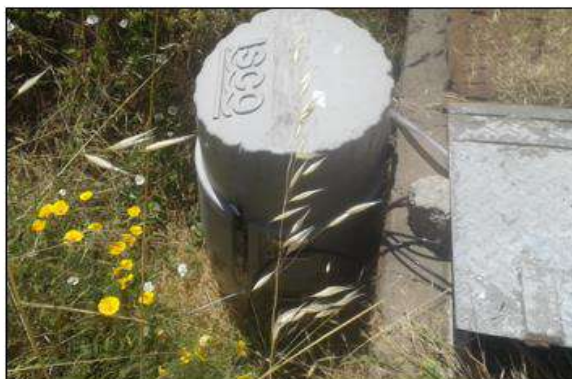
Fotografía 1: Instalación Equipo Automático
