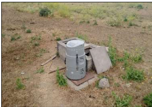
Fotografía 2: Equipo Automático Instalado
