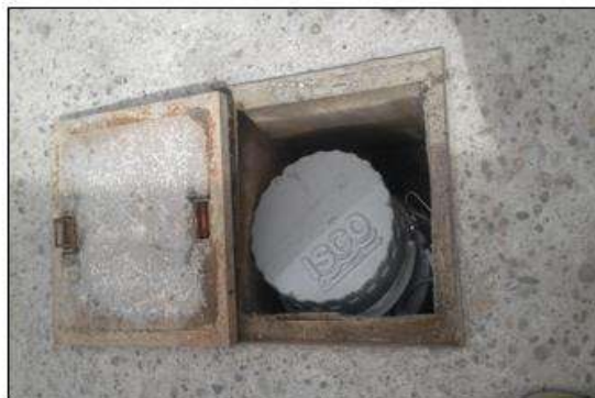
Fotografía 1: Instalación Equipo Automático
