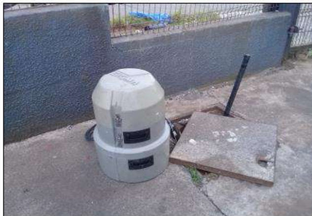
Fotografía 1: Instalación Equipo Automático
