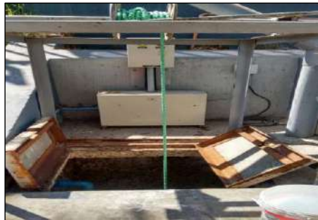
Fotografía 2: Punto de Monitoreo
