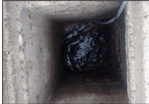
Fotografía 1: Punto de Monitoreo
