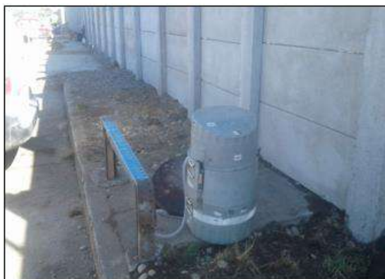
Fotografía 1: Instalación Equipo Automático
