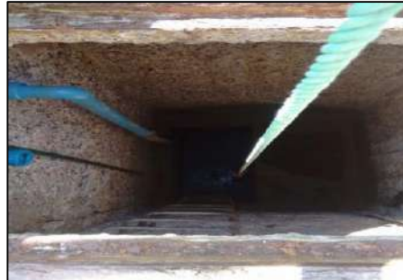
Fotografía 1: Punto de Monitoreo
