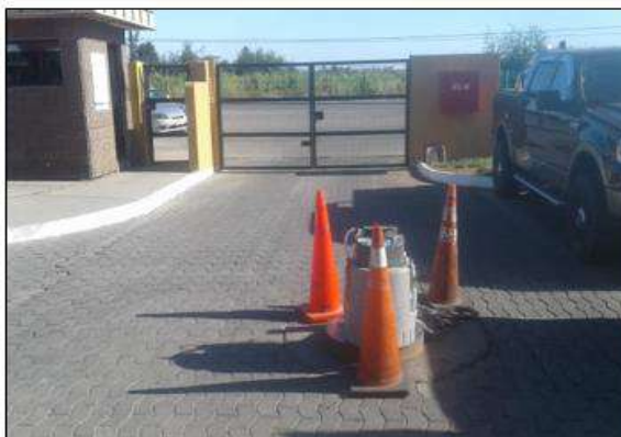
Fotografía 1: Instalación Equipo Automático
