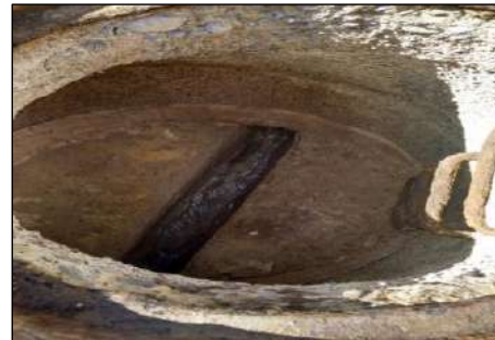
Fotografía 3: Punto de Monitoreo
