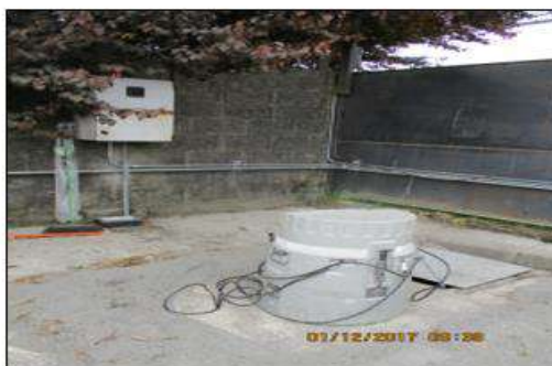
Fotografía 1: Instalación Equipo Automático
