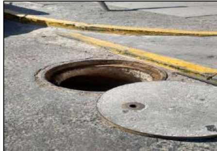
Fotografía 1: Punto de Monitoreo
