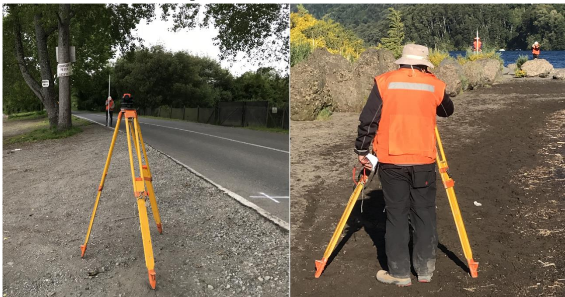
Figura 3-5 Nivelando en Localidades
