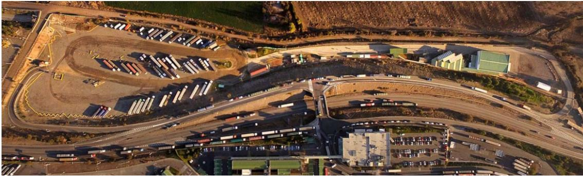
Figura N°6.2- 5: Almacén Extraportuario El Sauce S.A.
