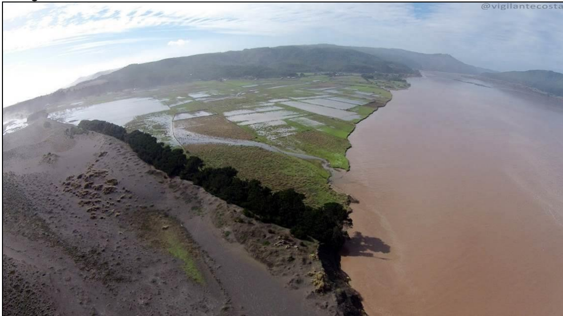
Fotografía N° 2.1: Inundación sector norte - Boca de Itata
