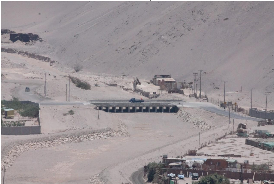
Figura 5-17. Vista de enrocado aguas abajo de obra de arte ubicada en Ruta A-301 (entrada Pueblo de Acha)
