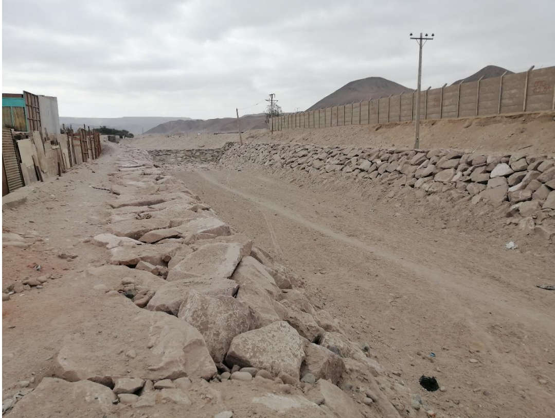
Figura 7-3. Puente Cerro Sombrero Vista hacia Aguas Arriba – Ubicación (7953027, 365468)
