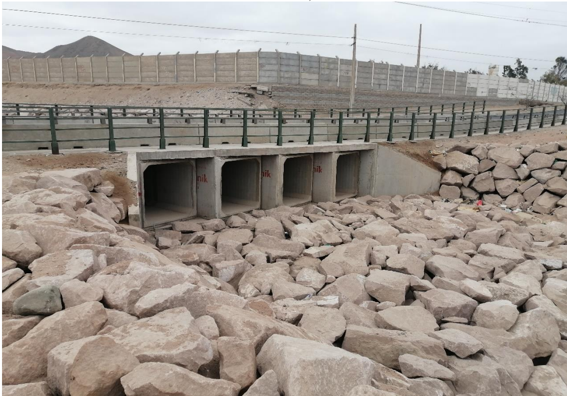
Figura 5-15. Obra de Arte Cerro Sombrero Vista hacia Aguas Abajo – Ubicación (7953027, 365468)
