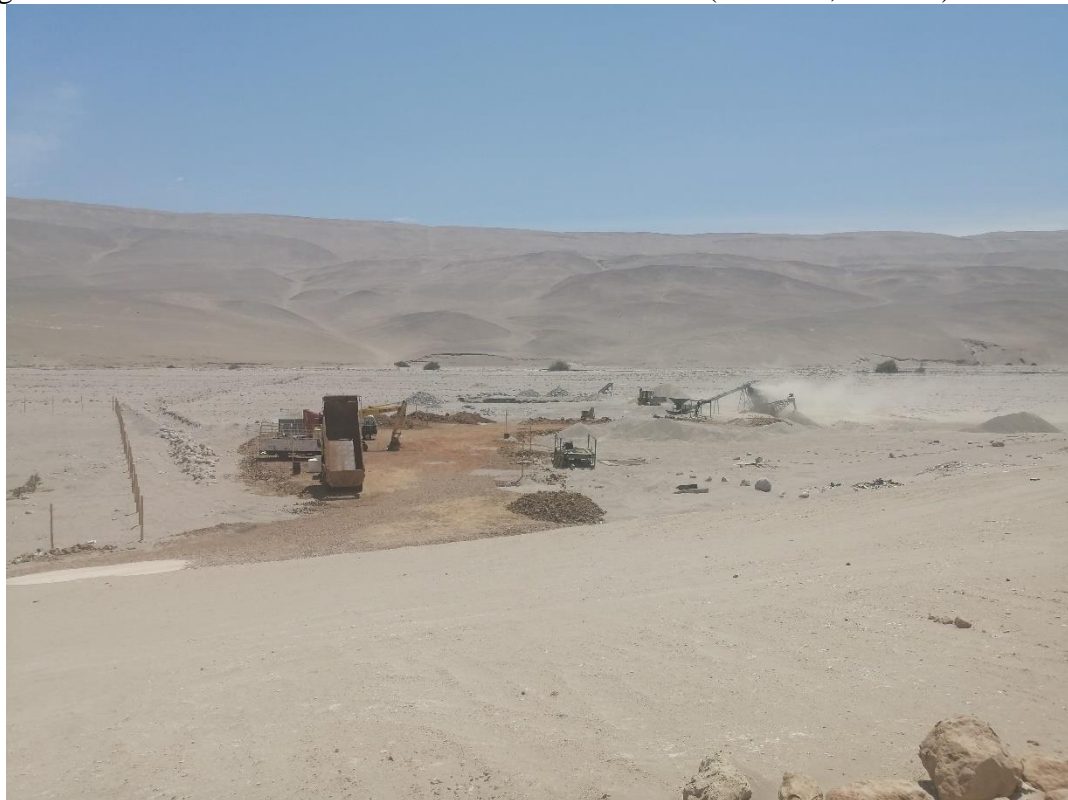
Figura 5-23. Planta de Extracción de Áridos – Ubicación (7940318, 372729) km 33+000
