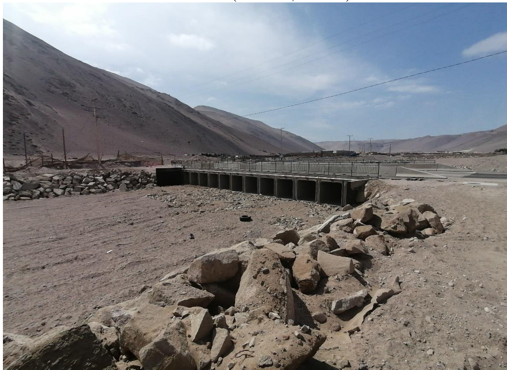
Figura 5-16. Obra de arte Ruta A-301 entrada a pueblo de Acha Vista hacia Aguas Abajo – Ubicación (7946956, 368359)
