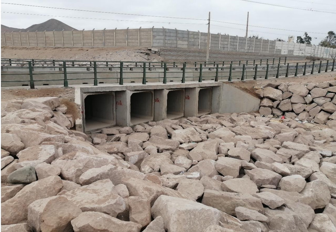
Figura 7-2. Puente Cerro Sombrero Vista hacia Aguas Abajo – Ubicación (7953027, 365468)
