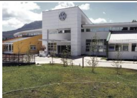
EDIFICIO TELETÓN Calle Ejército N° 567
