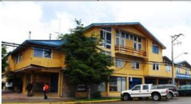
Edificio Consistorial Francisco Bilbao N° 357
