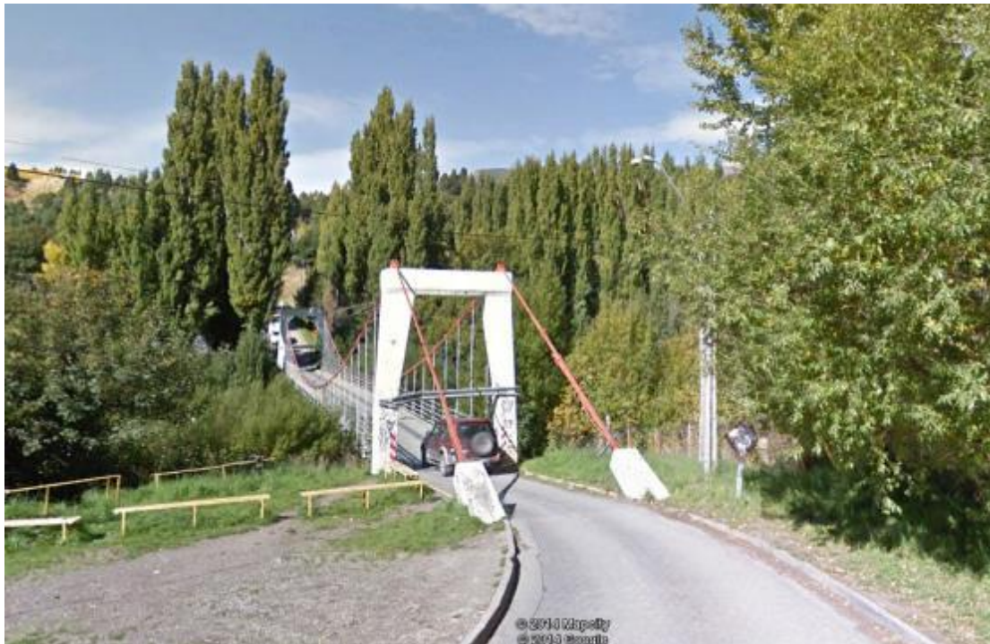
Figura N° 4-23 Puente Camino del Indio
