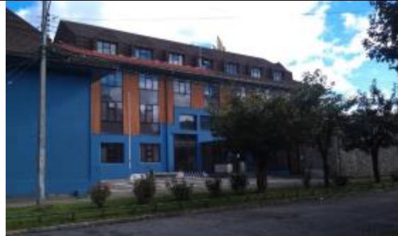
Edificio MOP Riquelme N°465
