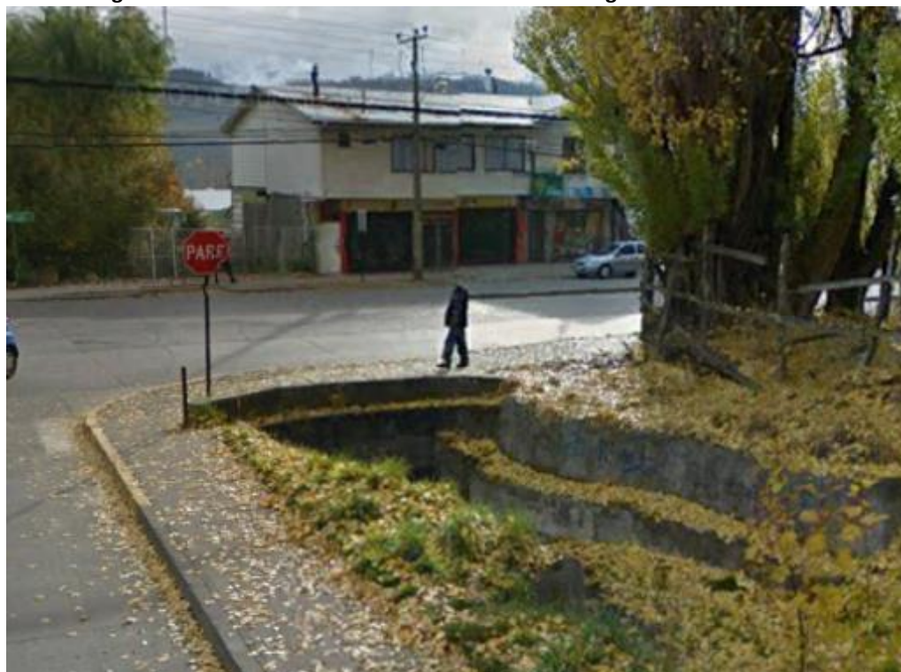
Figura N° 4-26 Obra de arte en intersección de Av. Ognana con Los Mañíos
