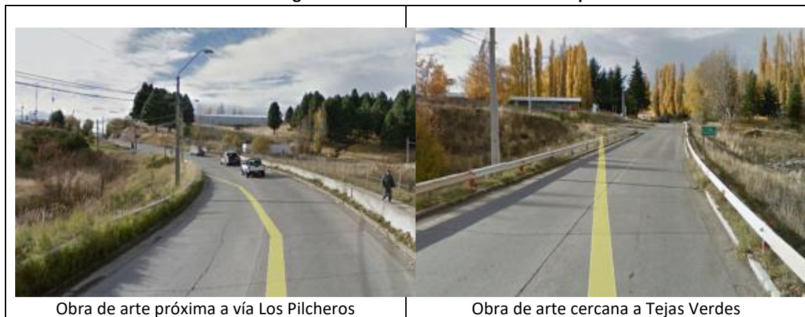
Figura N° 4-25 Obras de Arte en Av. Baquedano
