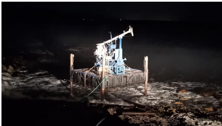
imagen 3-3 Trabajos Sondaje marítimo N°2
