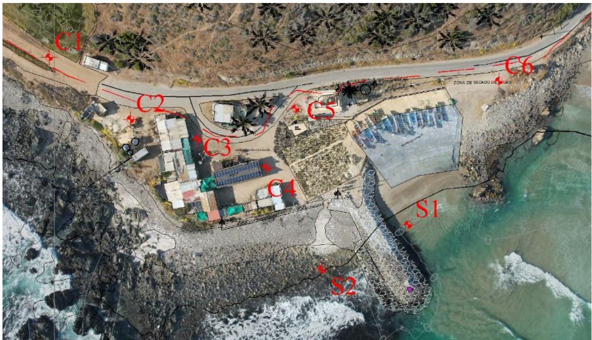
imagen 6-1 Ubicación de sondaje y calicatas
