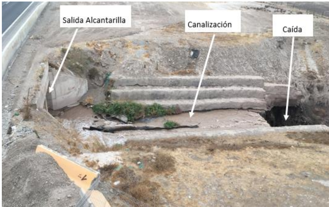
FIGURA 11-10: BOCA DE SALIDA ALCANTARILLA DE CRUCE CANAL SANTA MARTA BAJO AUTOPISTA DEL SOL.
