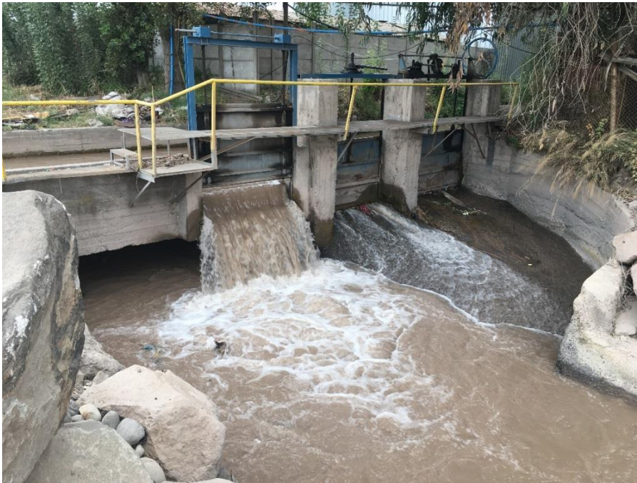
FIGURA 12-5: DESCARGA CANAL LO ESPEJO EN CANAL SANTA MARTA CON COMPUERTAS NORTE ABIERTAS.
