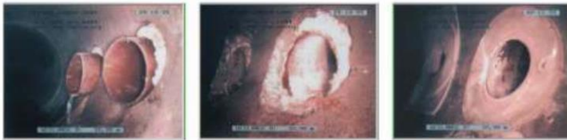
Conexión de UD's antes, durante y después de reparación mediante robots.
