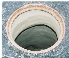
Sellado interior de CI con mortero de cemento
