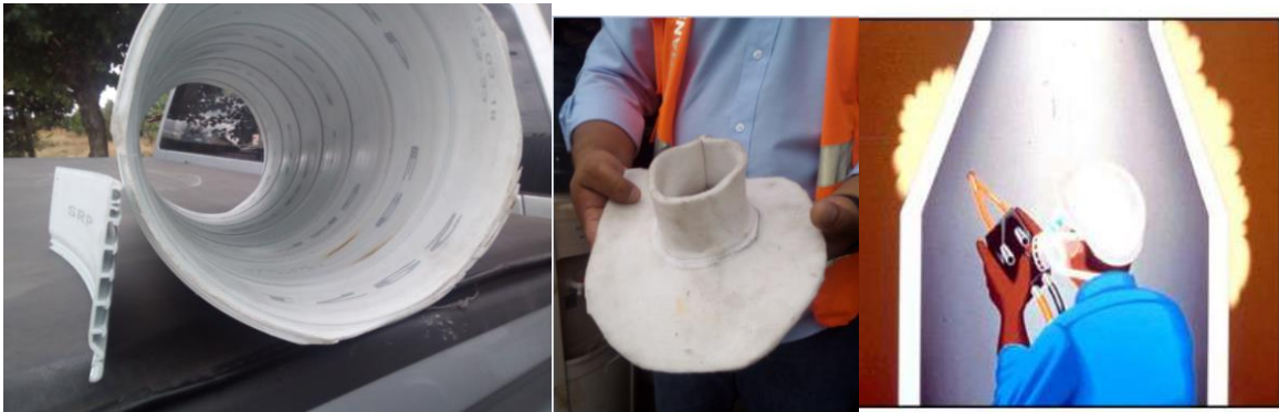
Glemans, rehab. SWP alcantarillado de San Clemente, NuevoSur (2019)
