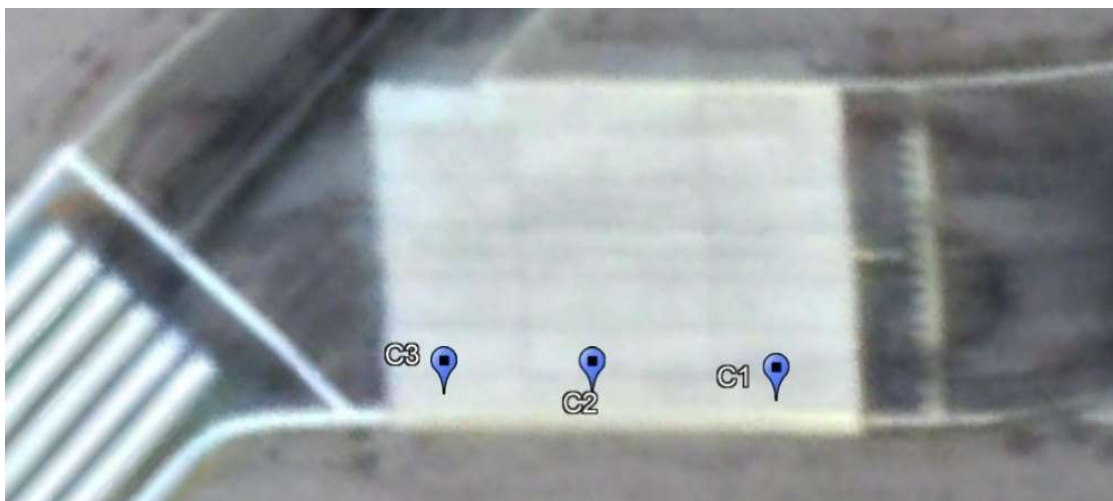
Figura 75: Evaluación Calle de Rodaje Bravo (Hormigón)- Línea 1.
