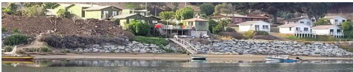
Figura 4-35: Fotografías del enrocado en sector La Pesca, abril 2024.
